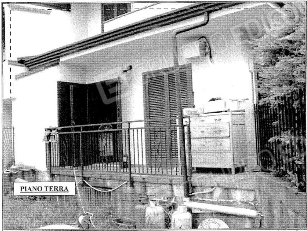
- Foto 3 (Vista esterna del Piano Terra) -
