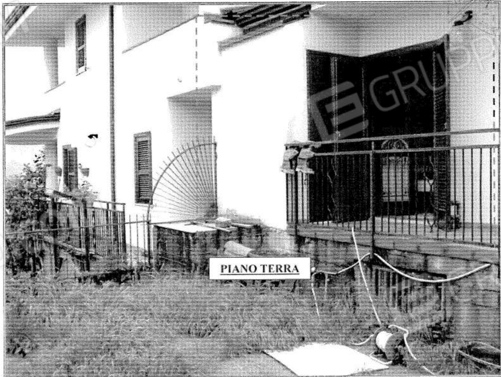
- Foto 4 (Vista esterna del Piano Terra) -
