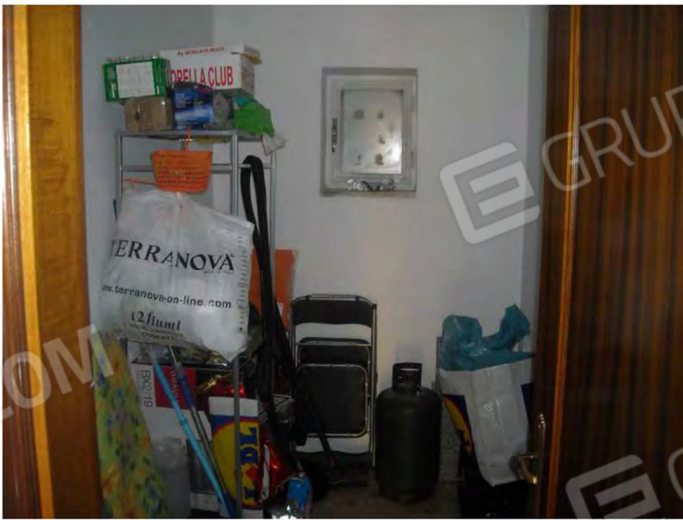
Foto n.8 Particolare interno ripostiglio
