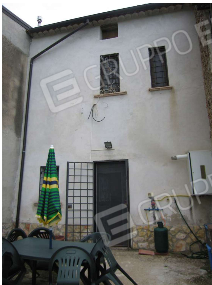
Foto n° 19 - Vista esterna lato nord-est
