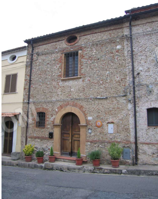
Foto n° 3 - Vista esterna da Via Ex Provinciale
