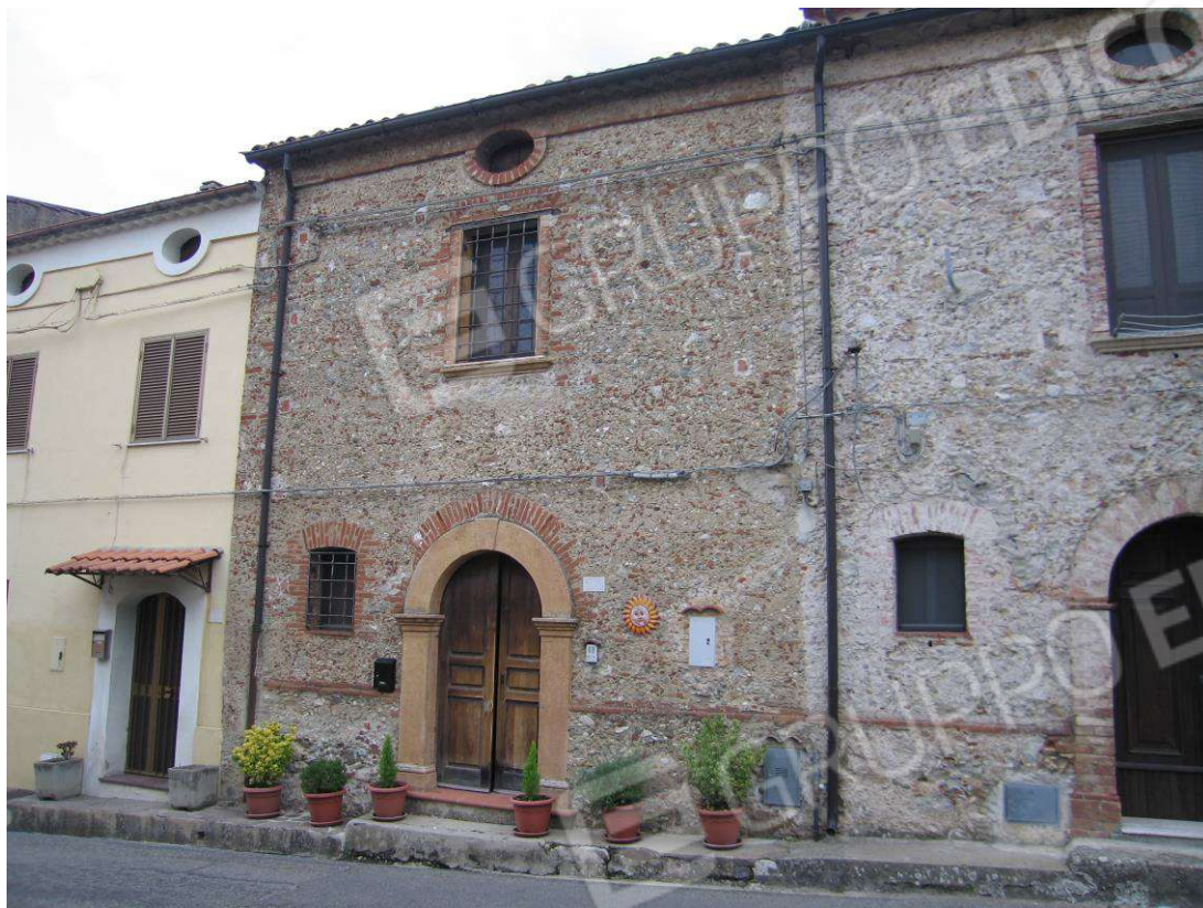
Foto n° 1 e 2 - Vista esterna da Via Ex Provinciale
