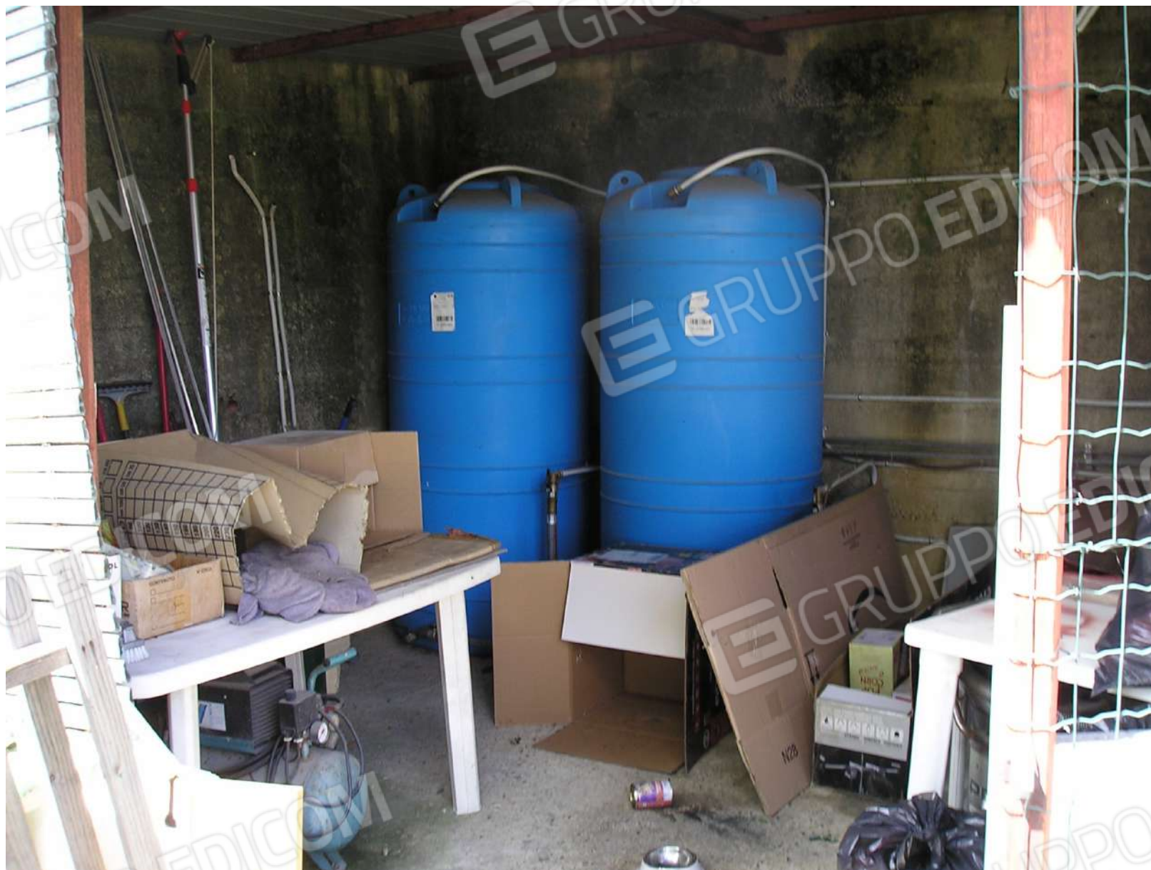
Foto n. 25: Serbatoio autoclave
