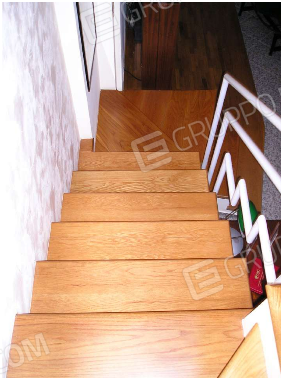
Foto n. 22: Particolare scala interna di collegamento
