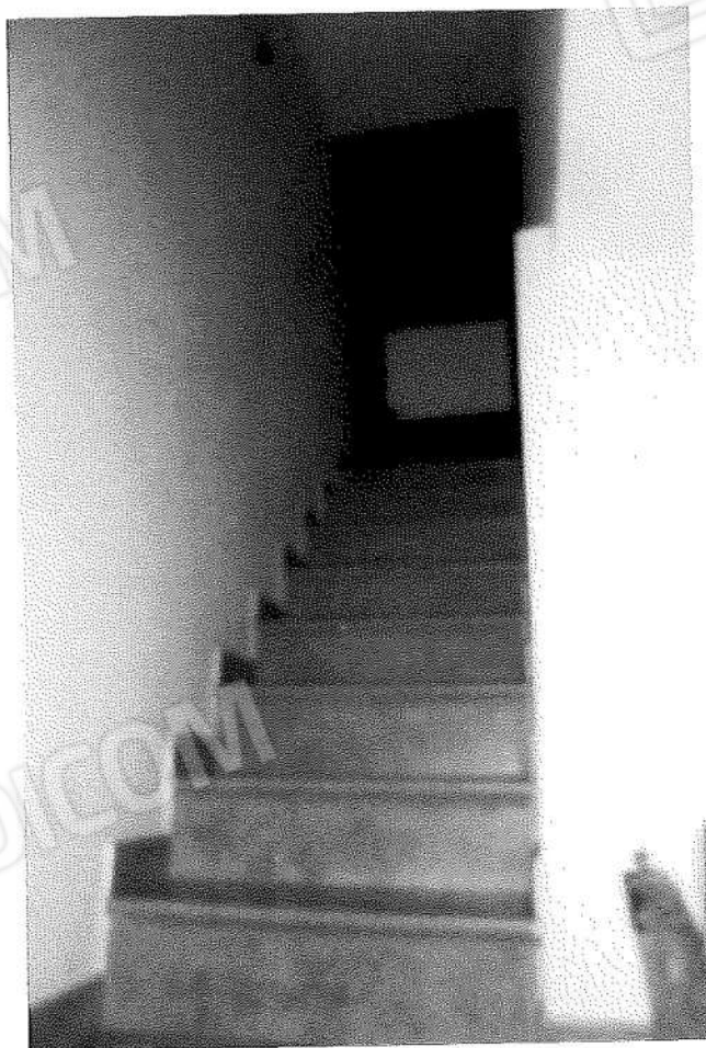
Foto n° 13 - scale di accesso al terrazzo e soffitta
