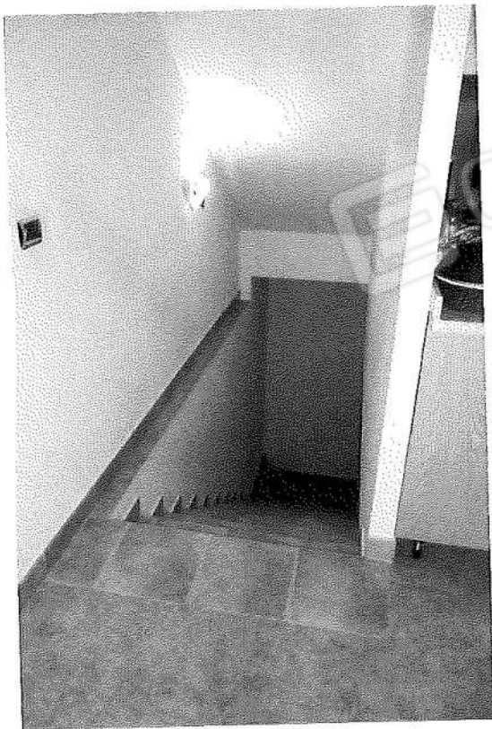
Foto n° 8 - scale di accesso al piano terra
