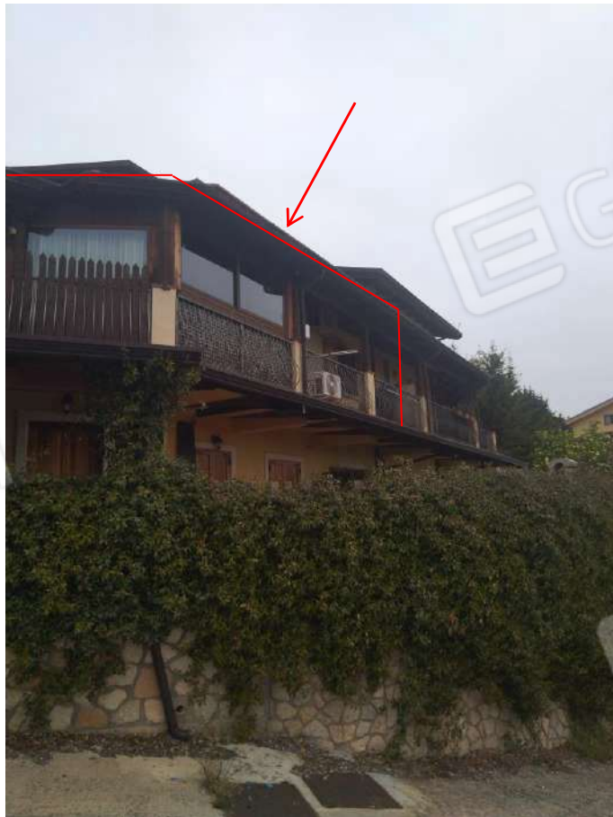
FOTO 4 – Vista SUD – EST
