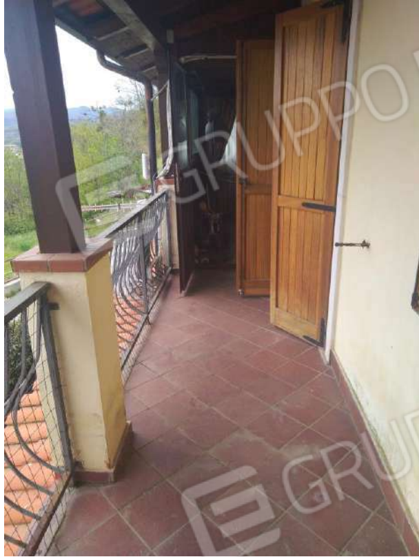
FOTO 15 – Balcone al piano terra
