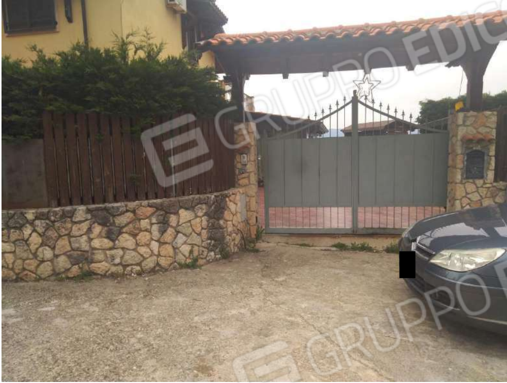
FOTO 1 – Ingresso unità immobiliare
