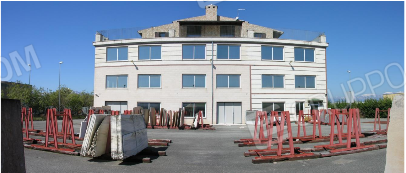
Foto 2: vista esterna ingresso Sud Est.
