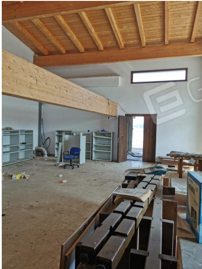
Foto 22: interno immobile sul lastrico solare.
