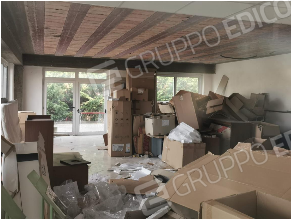
Foto 19: interno piano terra. Fg. 29 p.lla 197 sub 4.
