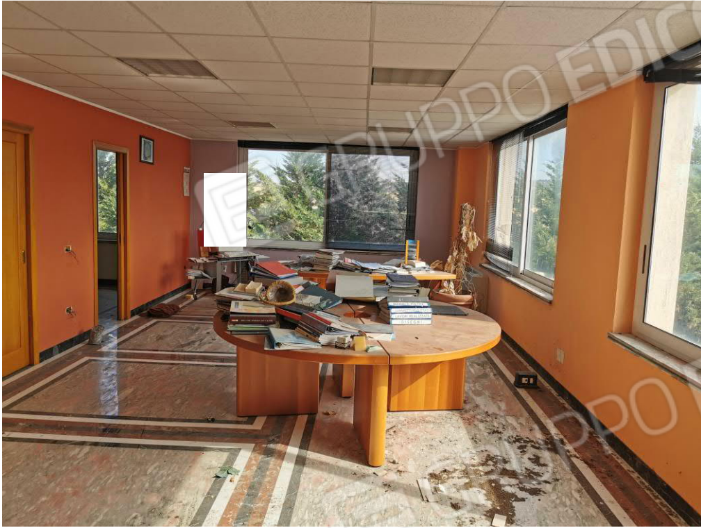
Foto 11: interno zona uffici piano primo. Fg. 29 P.Ila 196 sub 2
