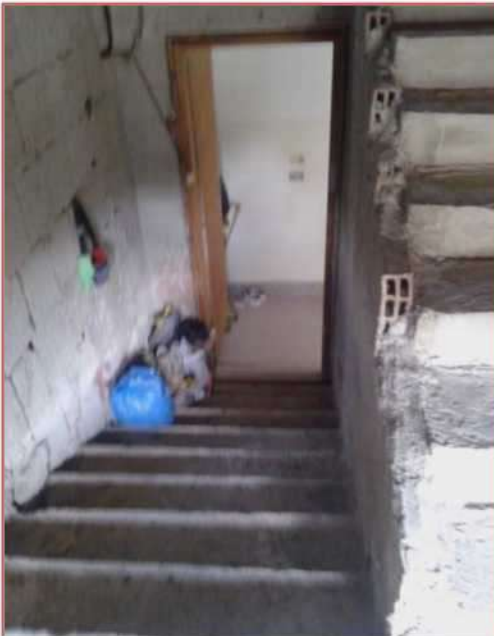
Foto n.21–scale di accesso al sottotetto-1ª rampa
