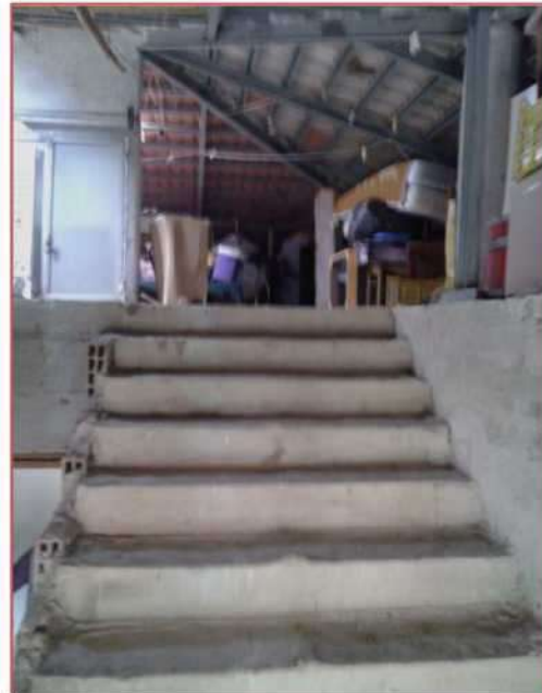
Foto n.22–scale di accesso al sottotetto-2ª rampa
