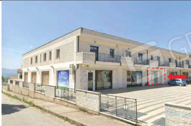
Vista generale del compendio di immobili con individuazione del cespite n. 1
