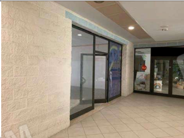
Vista dell'accesso dalla corte interna
