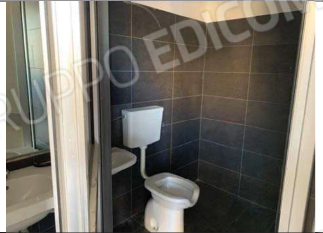
Vista interna del locale commerciale – bagno
