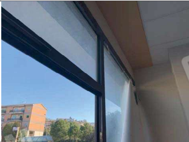
Vista interna del locale commerciale – infissi
