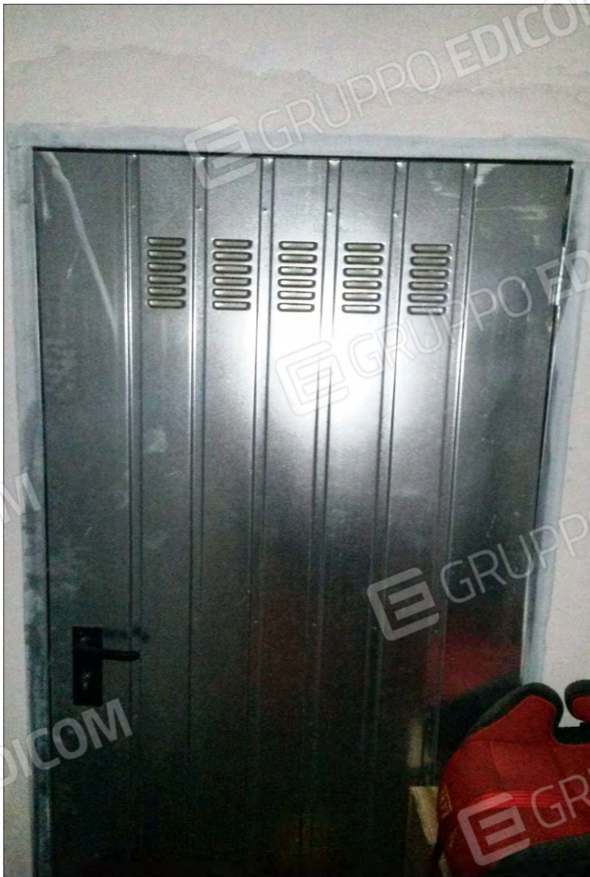
Porta di ingresso alla cantina
