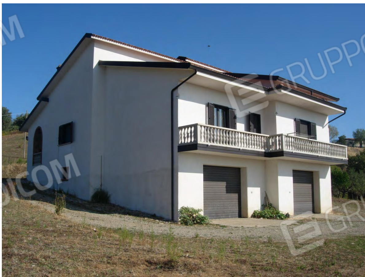
Foto 4: il prospetto sud-ovest.
