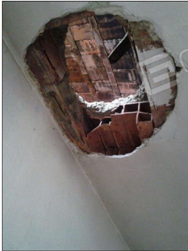
Fotografia 12: particolare di parte di solaio del fabbricato rurale ispezionato (cucina).
