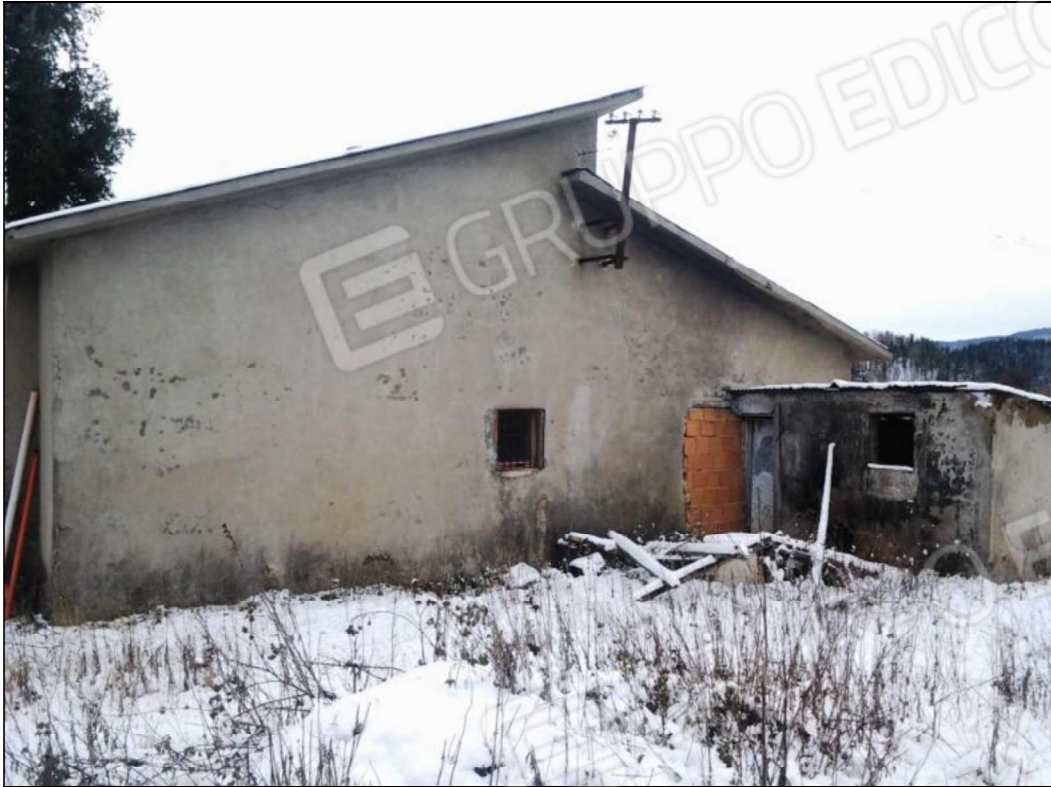
Fotografia 9: prospetto posteriore fabbricato ispezionato.
