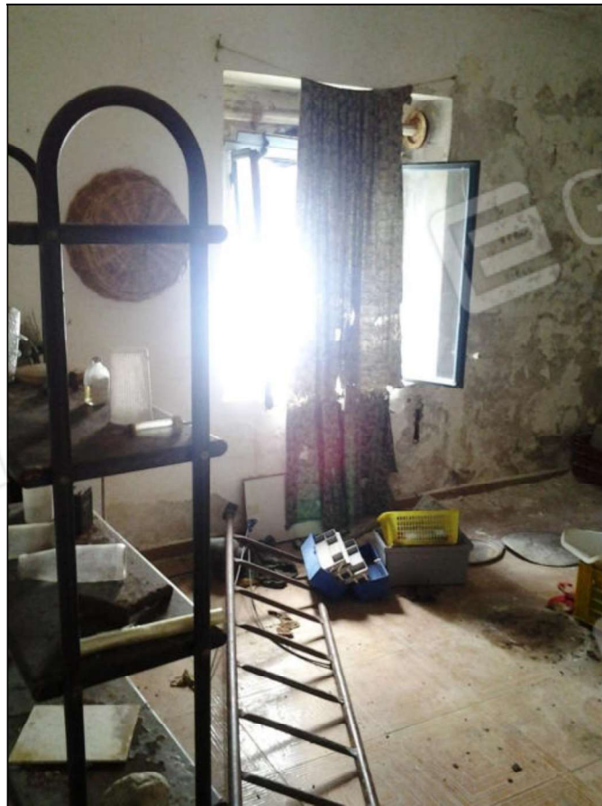
Fotografie 13 e 14: interno del fabbricato rurale ispezionato
