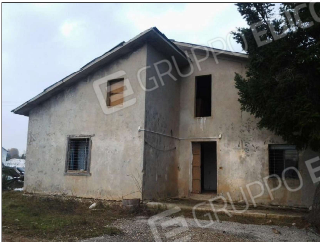
Fotografia 7: prospetto principale fabbricato ispezionato.
