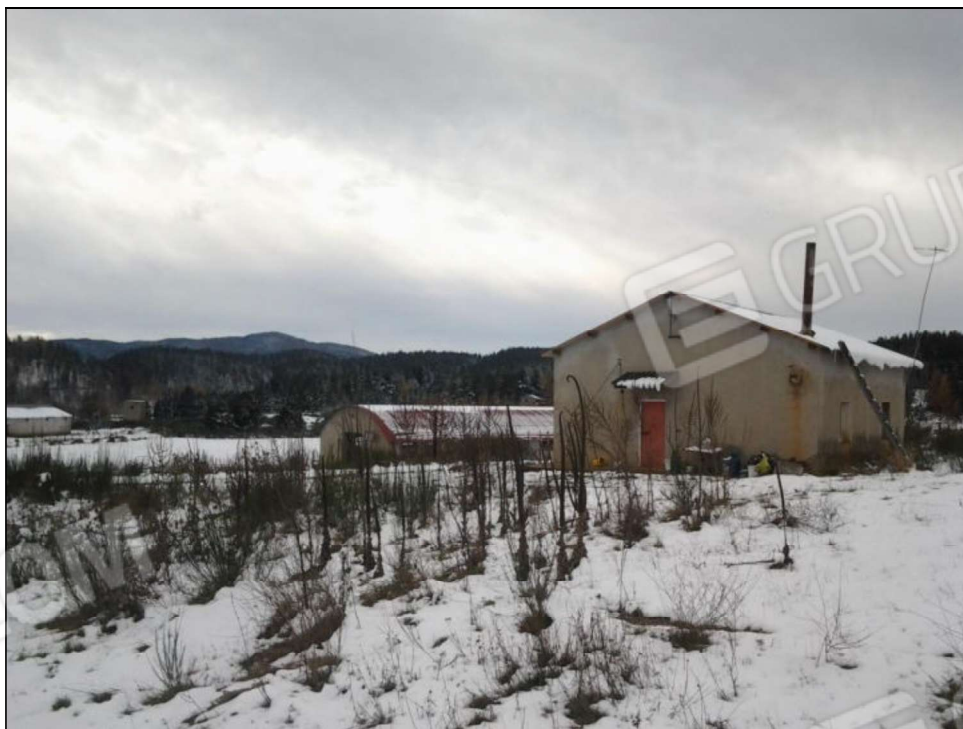
Fotografia 21: prospetto principale altro (presunto) fabbricato rurale.
