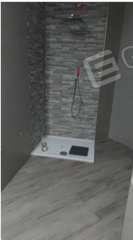
Foto 18 - interni alloggio custode;
