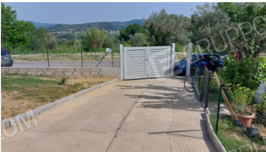
Foto 10 – esterni – terreno adiacente – zona ingresso;
