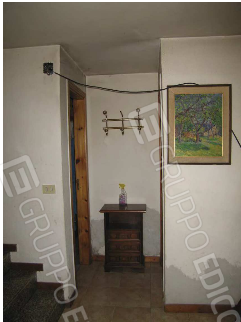
Foto n° 12 - Piano seminterrato (disimpegno)
