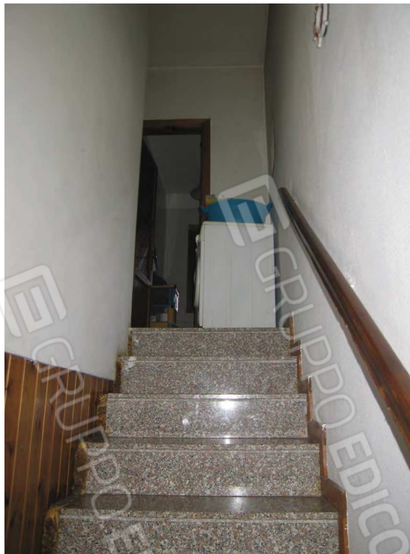
Foto n° 24 - Scala interna fra i piani terra e primo
