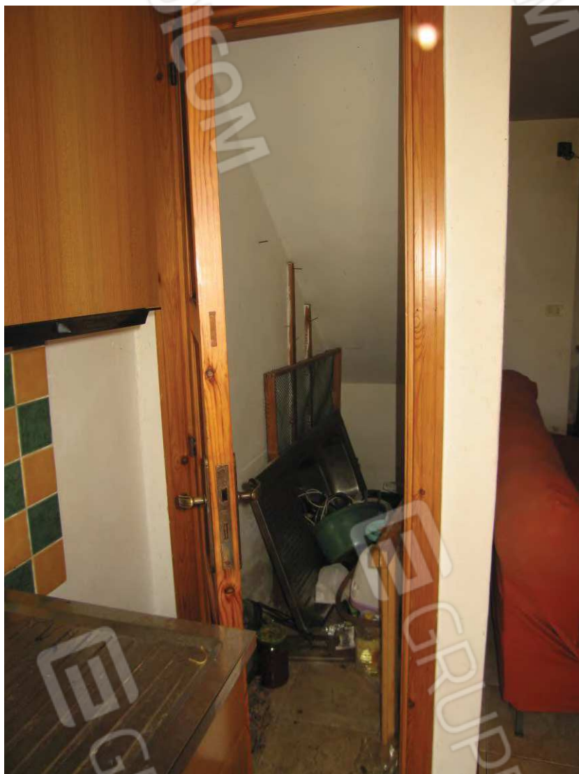
Foto n° 11 - Piano seminterrato (vano sottoscala)
