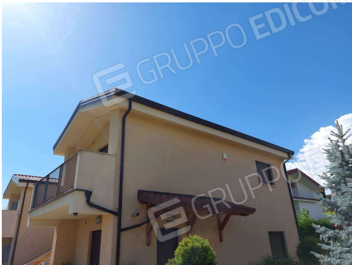
Foto N.10: Sub.4_ Prospetto fabbricato Ovest
