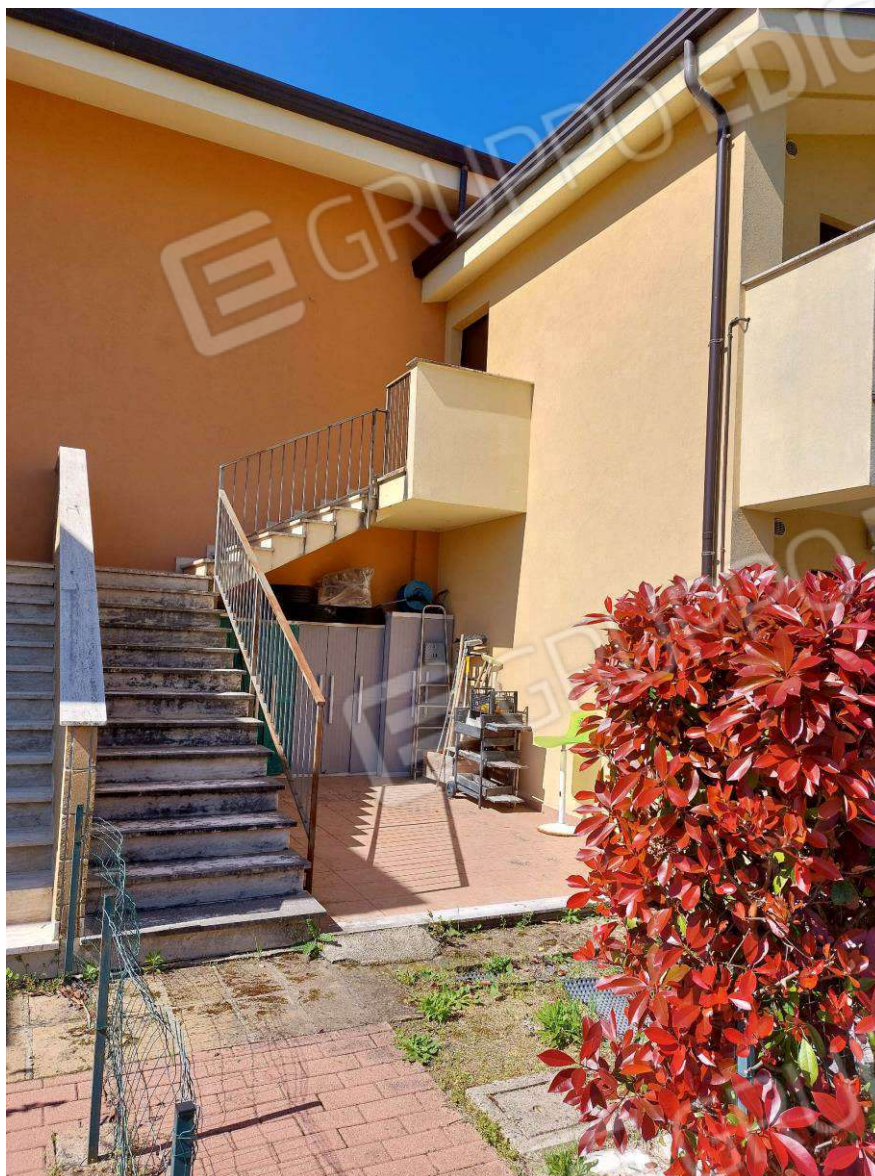
Foto N.9: Sub.4_ Prospetto fabbricato Est
