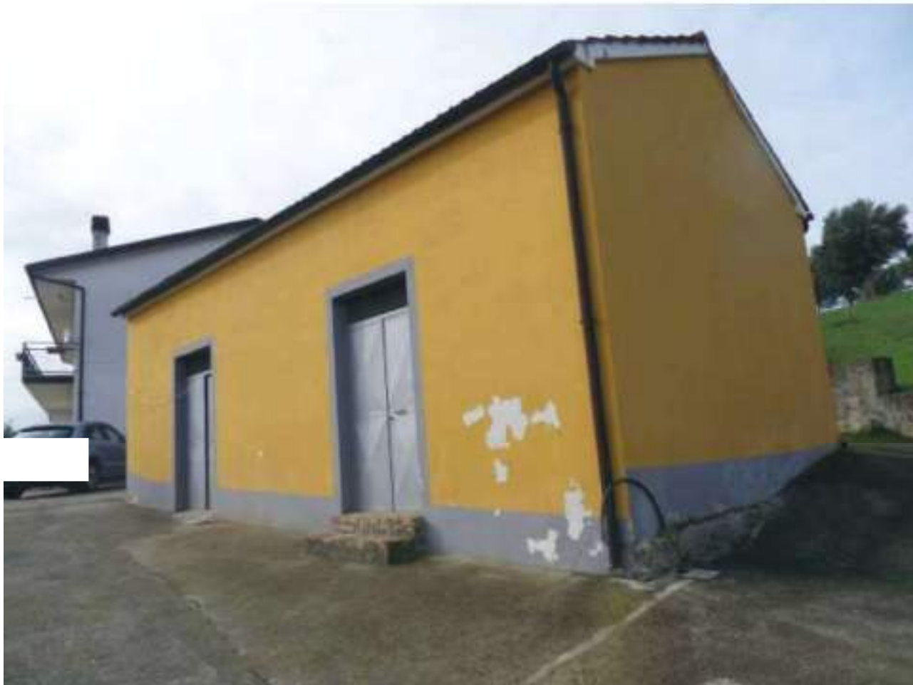
FOTO N. 122: Prospetto EST Bene N. 2
