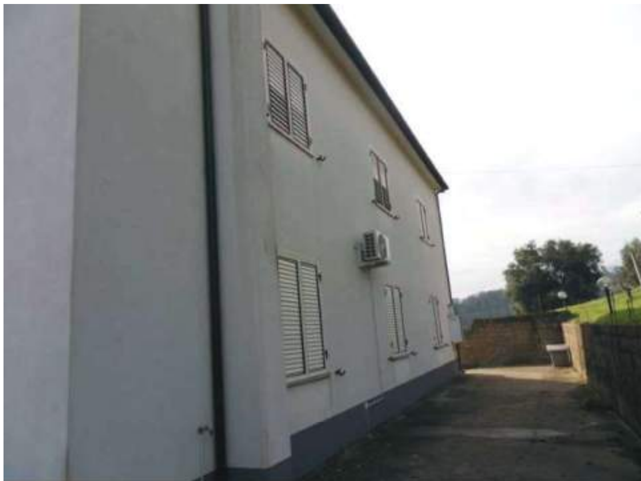
FOTO N. 13: Prospetto NORD - OVEST Bene N. 1
