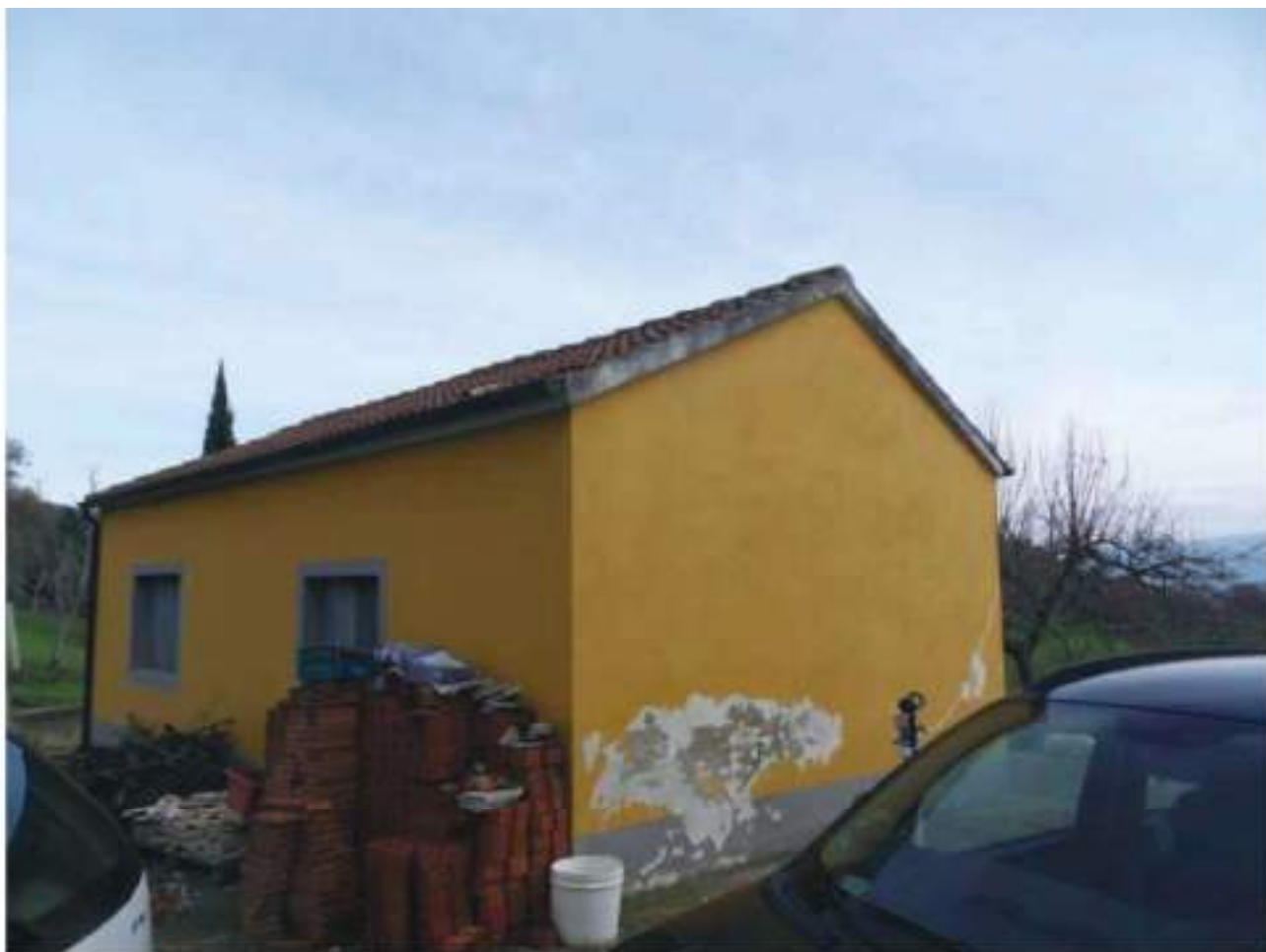
FOTO N. 135: Prospetto NORD – OVEST Bene N. 2
