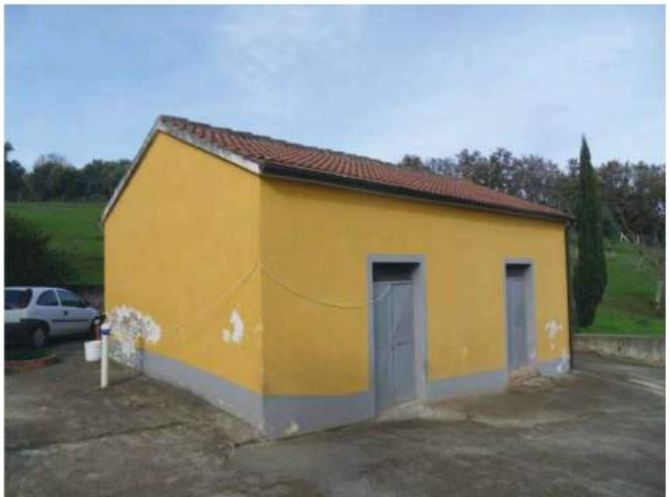
FOTO N. 118: Prospetto SUD - EST Bene N. 2
