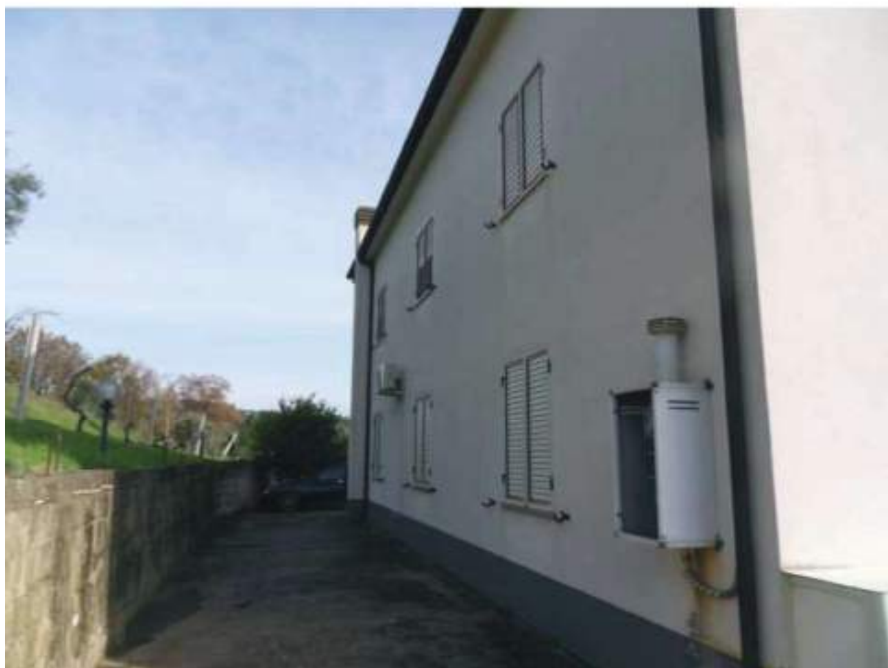
FOTO N. 14: Prospetto NORD - OVEST Bene N. 1
