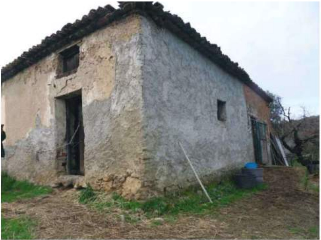
FOTO N. 149: Prospetto SUD – EST Bene N. 3
