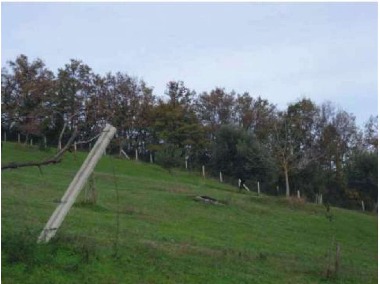
FOTO N. 164: Vista Bene N. 6 e N. 7 da Corte Bene N. 1
