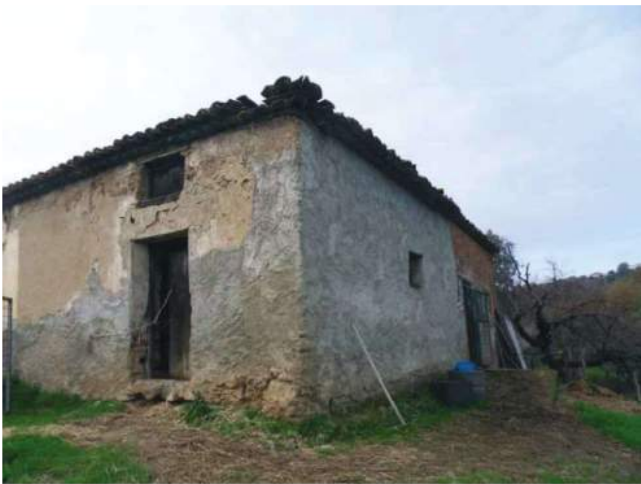
FOTO N. 137: Prospetto SUD – EST Bene N. 3
