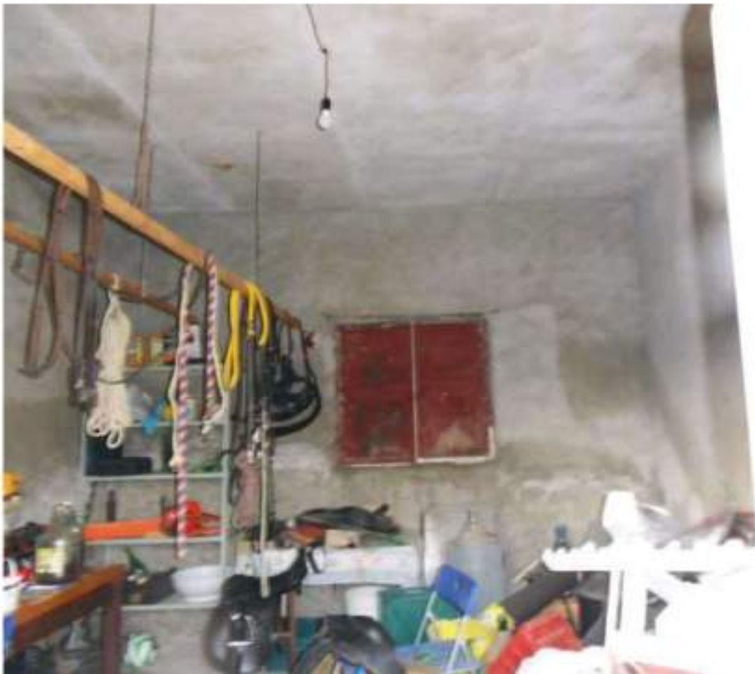
FOTO N. 130: Interni Bene N. 2
