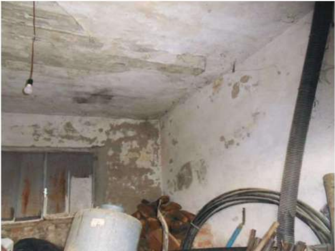
FOTO N. 126: Interni Bene N. 2
