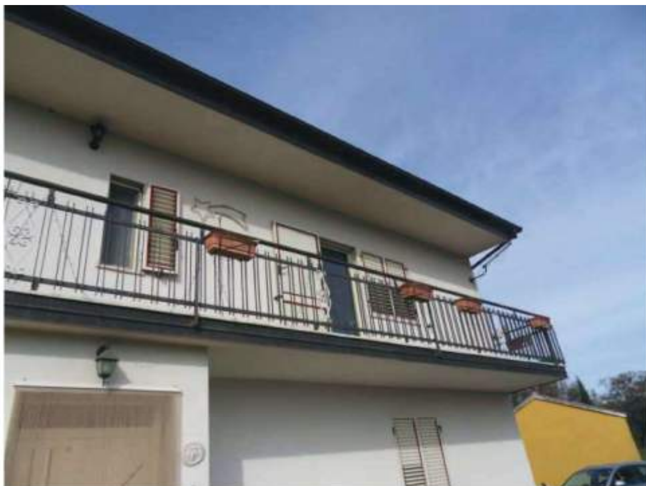
FOTO N. 7: Prospetto SUD - EST Bene N. 1
