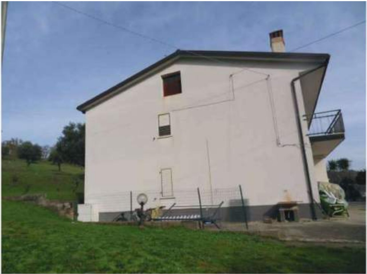
FOTO N. 15: Prospetto SUD - OVEST Bene N. 1
