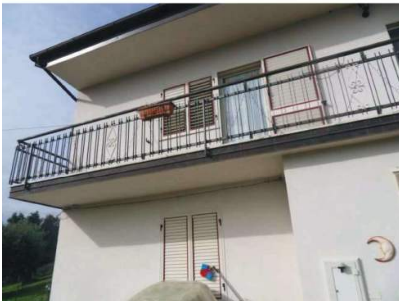
FOTO N. 8: Prospetto SUD - EST Bene N. 1
