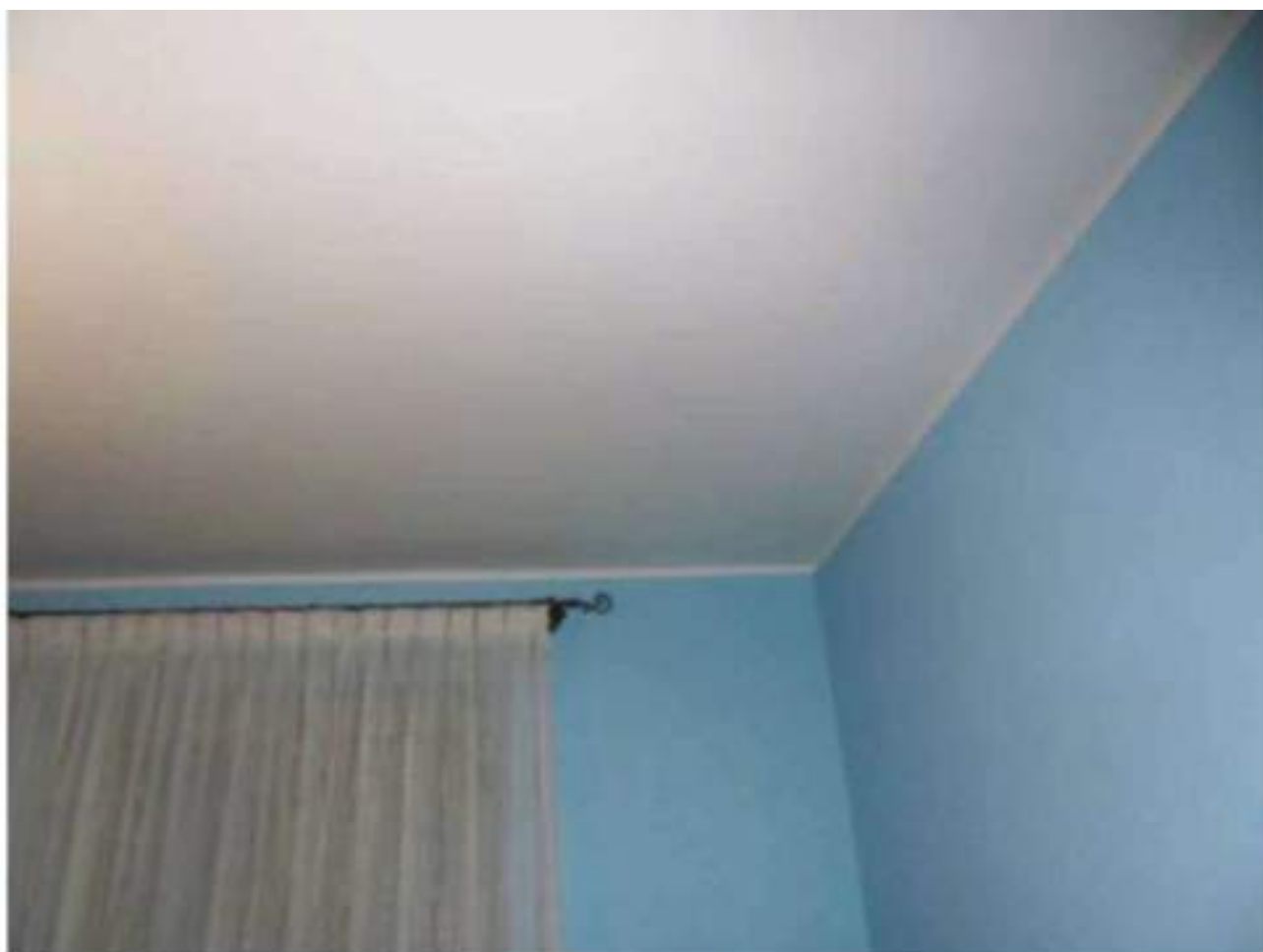
FOTO N. 63: Interni Bene N. 1 (PIANO TERRA)
