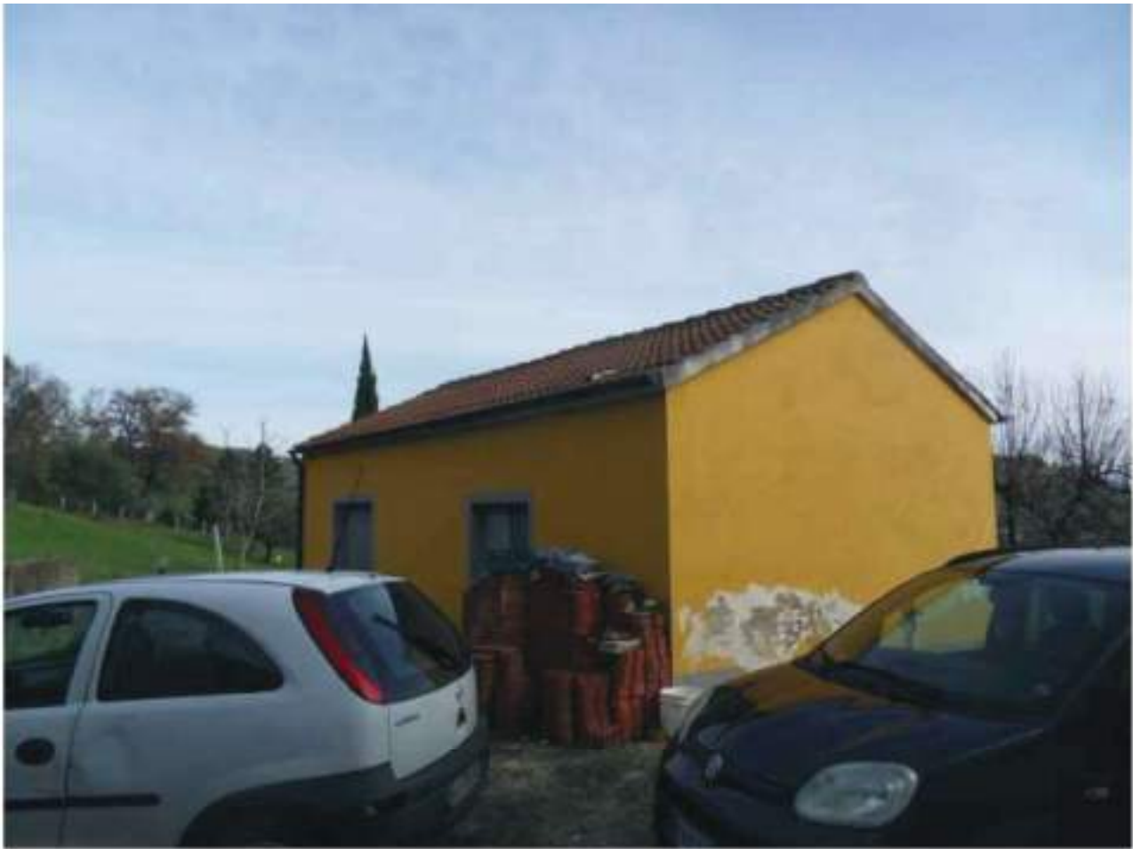
FOTO N. 121: Prospetto NORD – OVEST Bene N. 2
