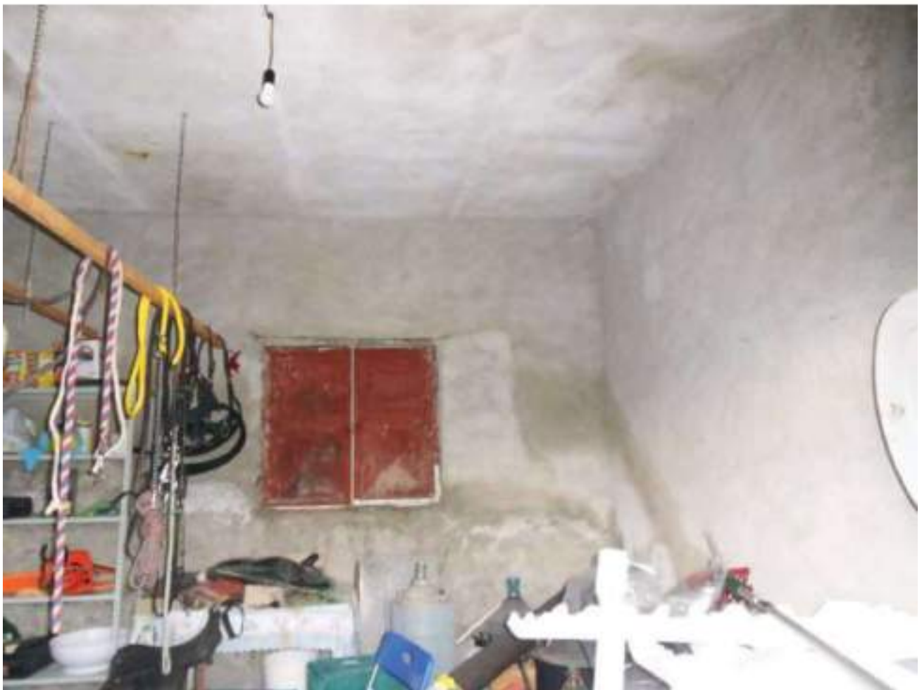
FOTO N. 134: Interni Bene N. 2
