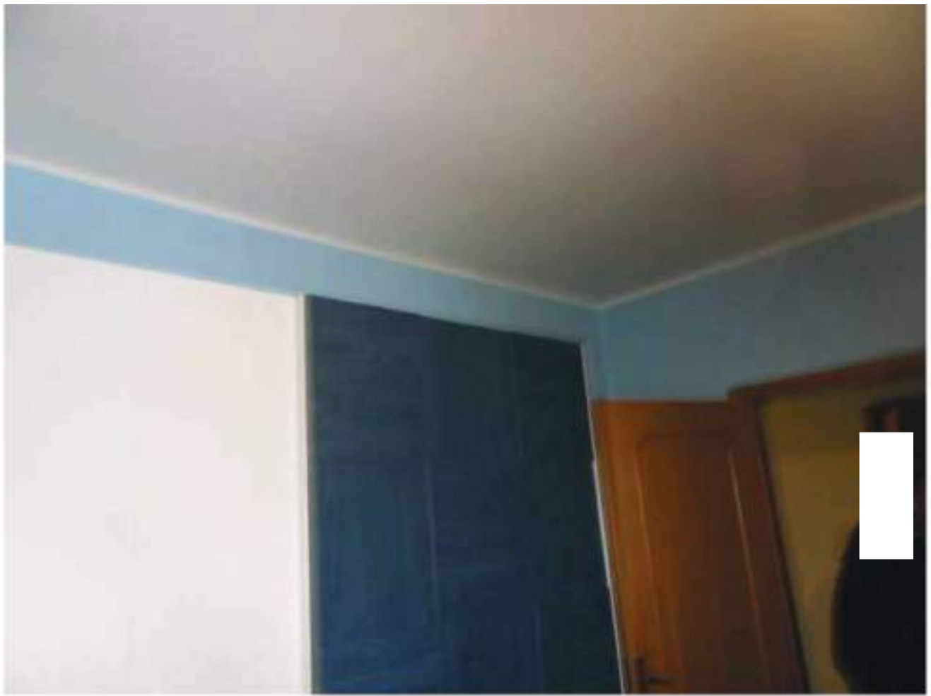
FOTO N. 109: Interni Bene N. 1 (PIANO PRIMO)
