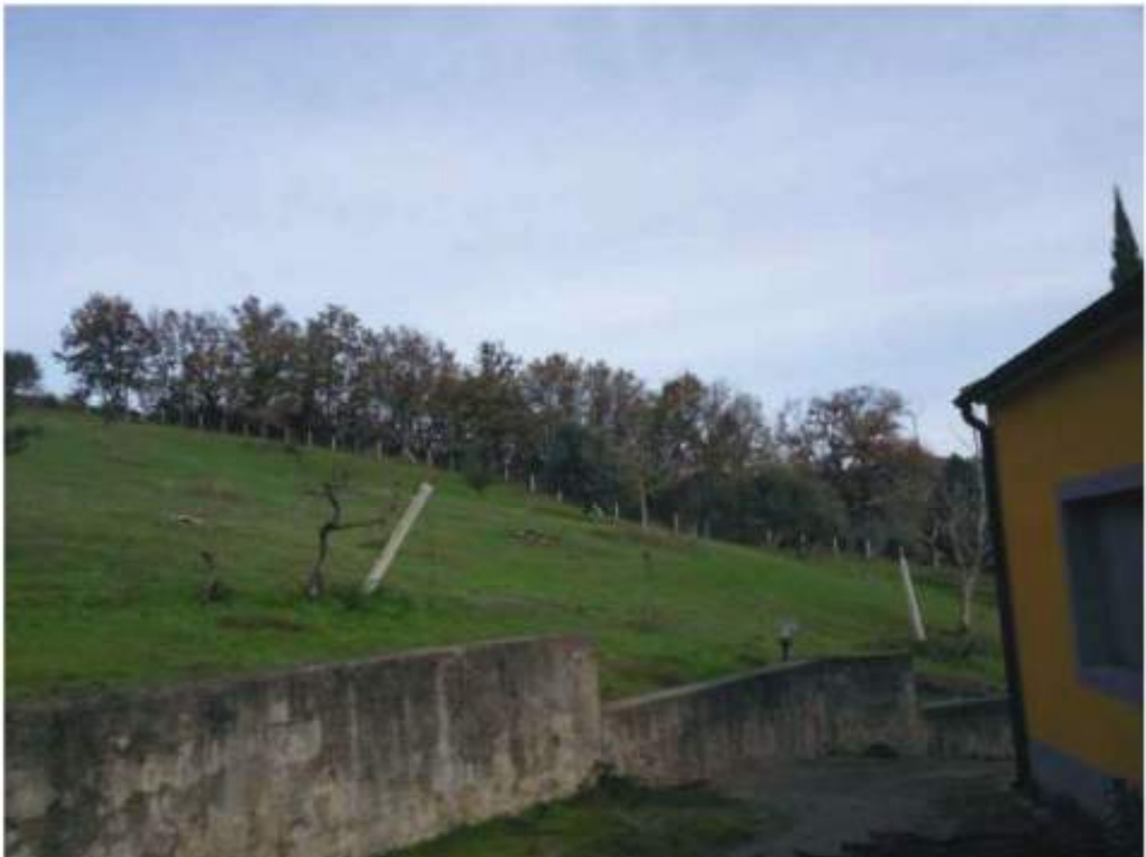
FOTO N. 162: Vista Bene N. 6 e N. 7 da Corte Bene N. 1
