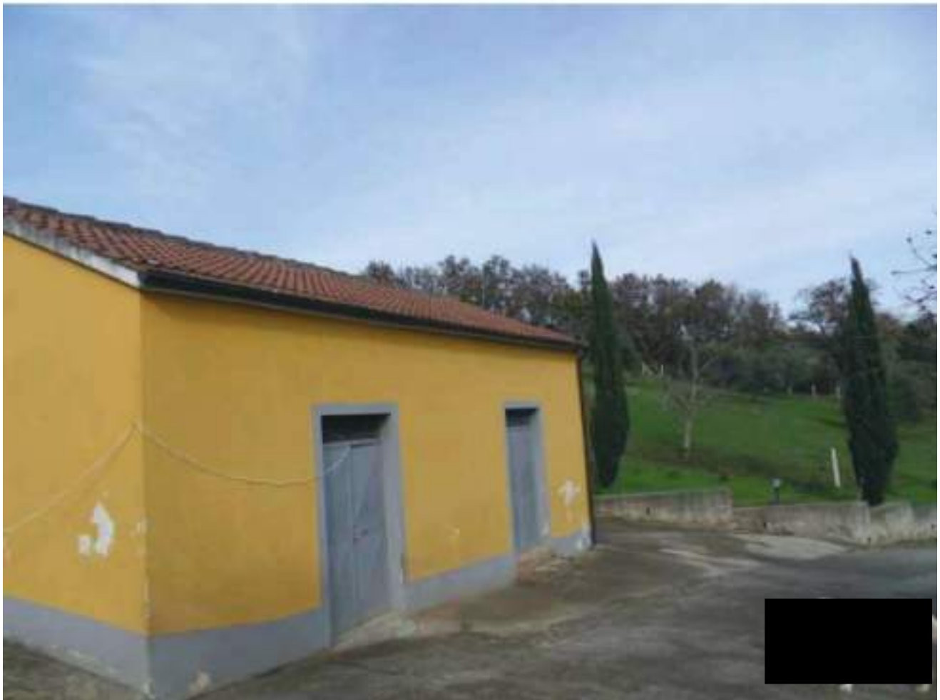
FOTO N. 120: Prospetto EST Bene N. 2
