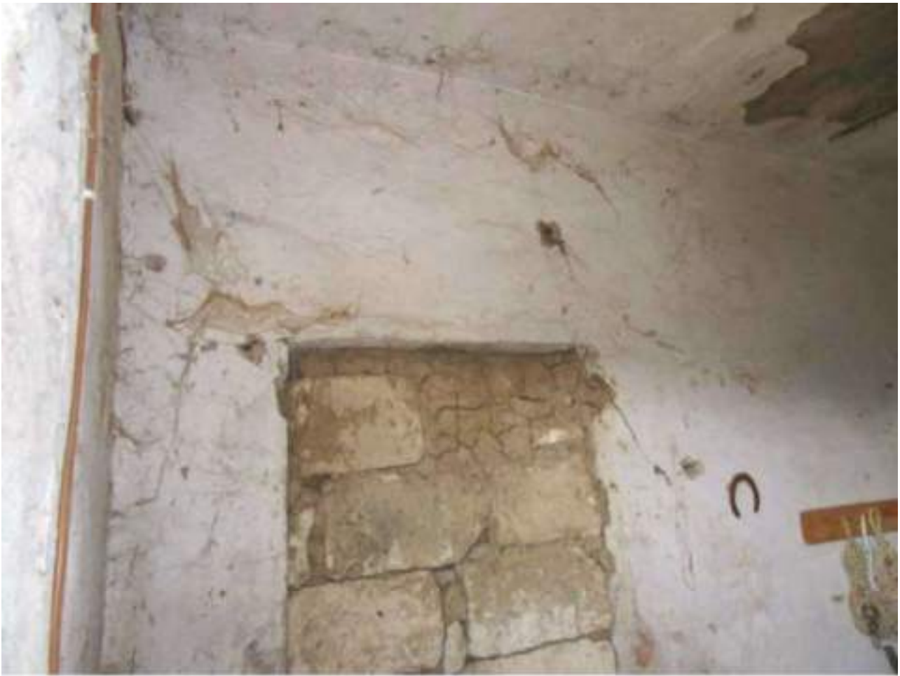
FOTO N. 125: Interni Bene N. 2
