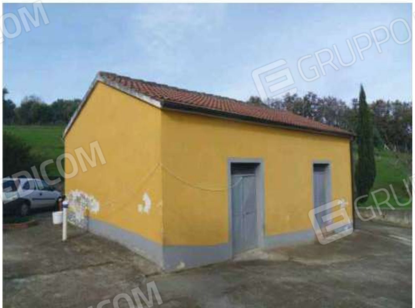
FOTO N. 118: Prospetto SUD - EST Bene N. 2
