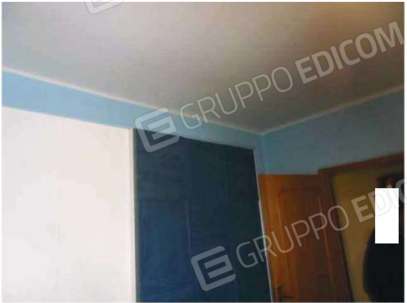
FOTO N. 109: Interni Bene N. 1 (PIANO PRIMO)
