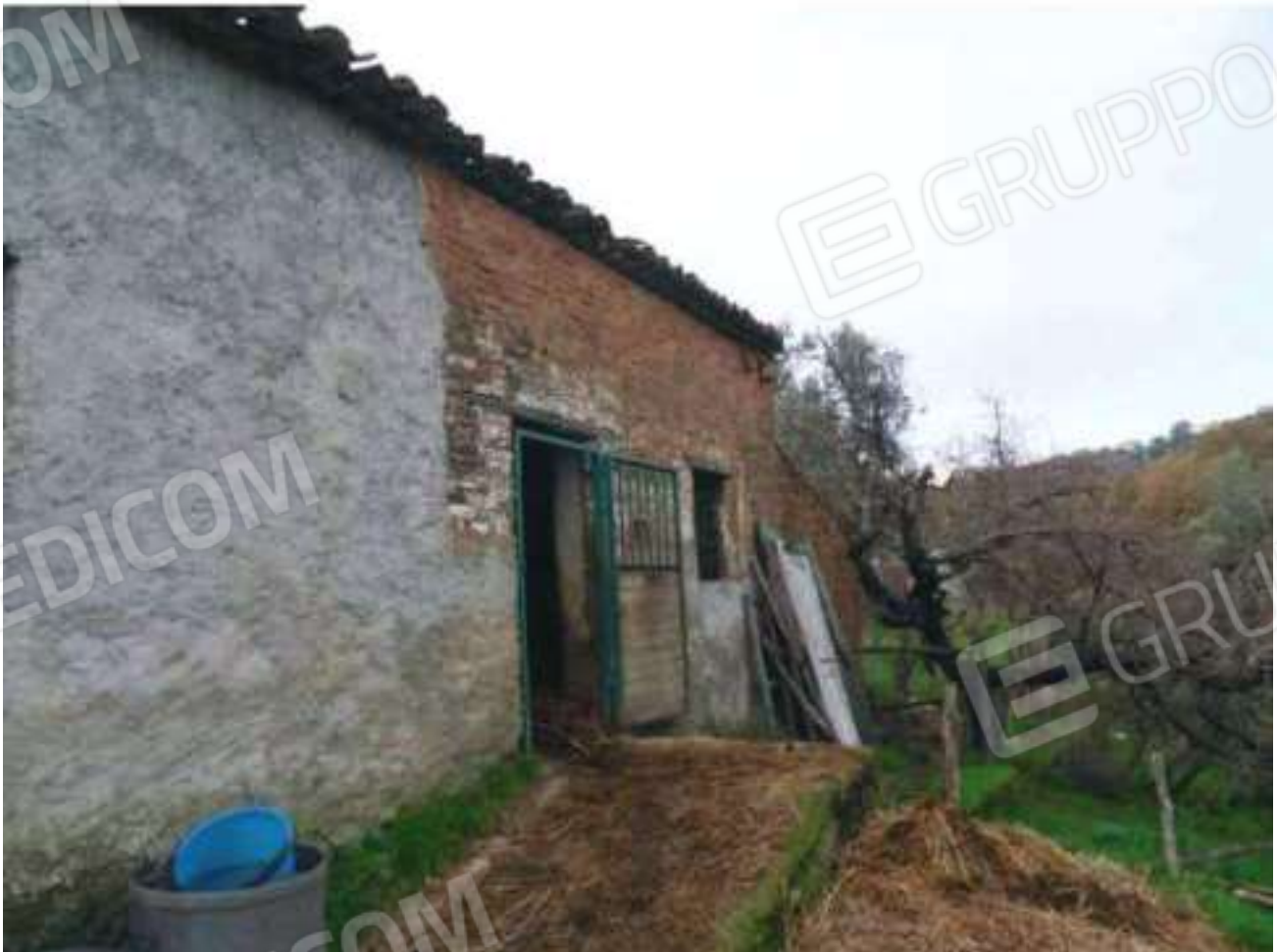
FOTO N. 140: Prospetto NORD – EST Bene N. 3
