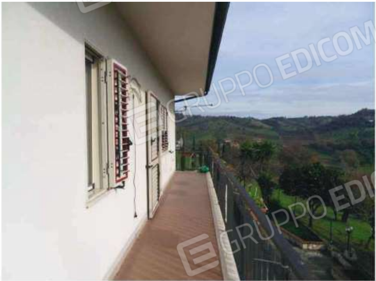
FOTO N. 79: Esterni Bene N. 1 (PIANO PRIMO - Balcone)
