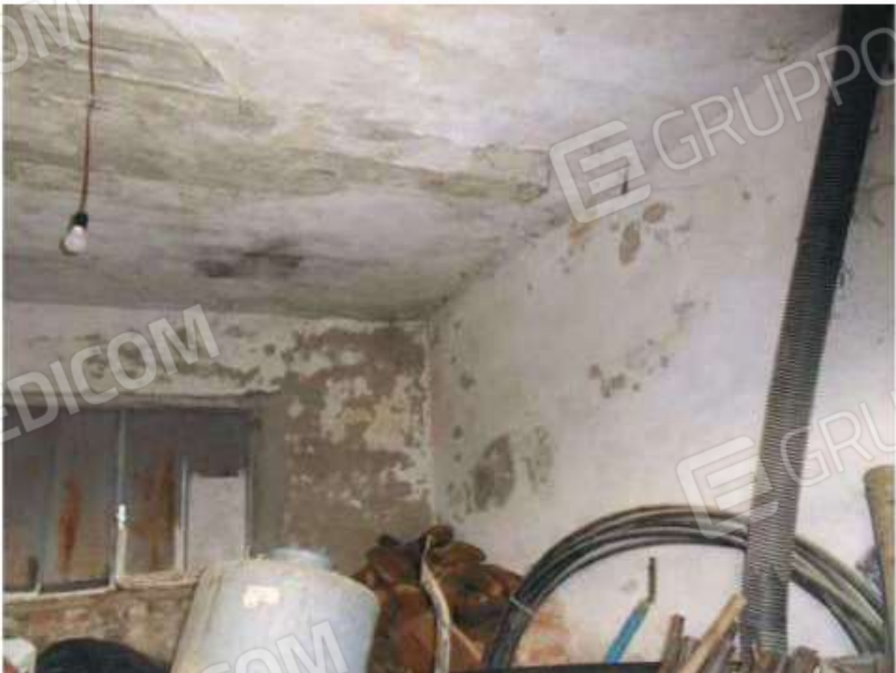
FOTO N. 126: Interni Bene N. 2
