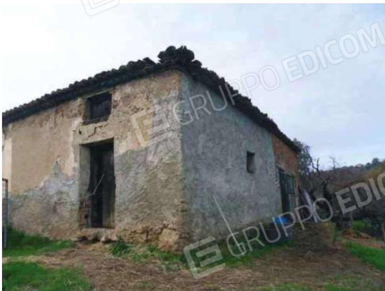
FOTO N. 137: Prospetto SUD – EST Bene N. 3
