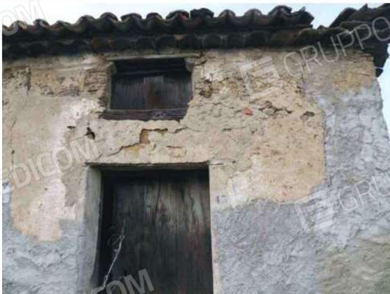
FOTO N. 150: Esterni Bene N. 3
