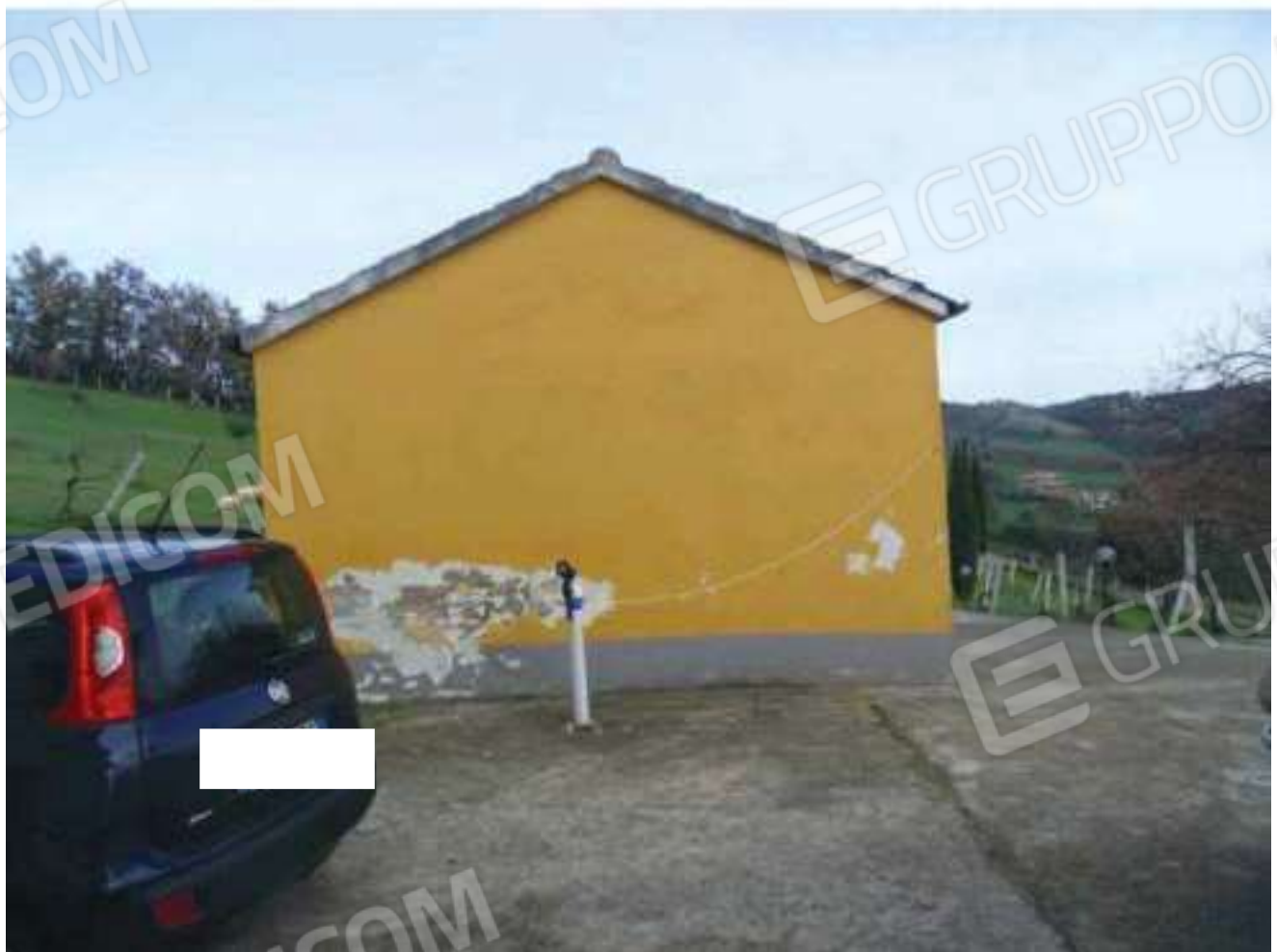
FOTO N. 136: Prospetto SUD Bene N. 2
