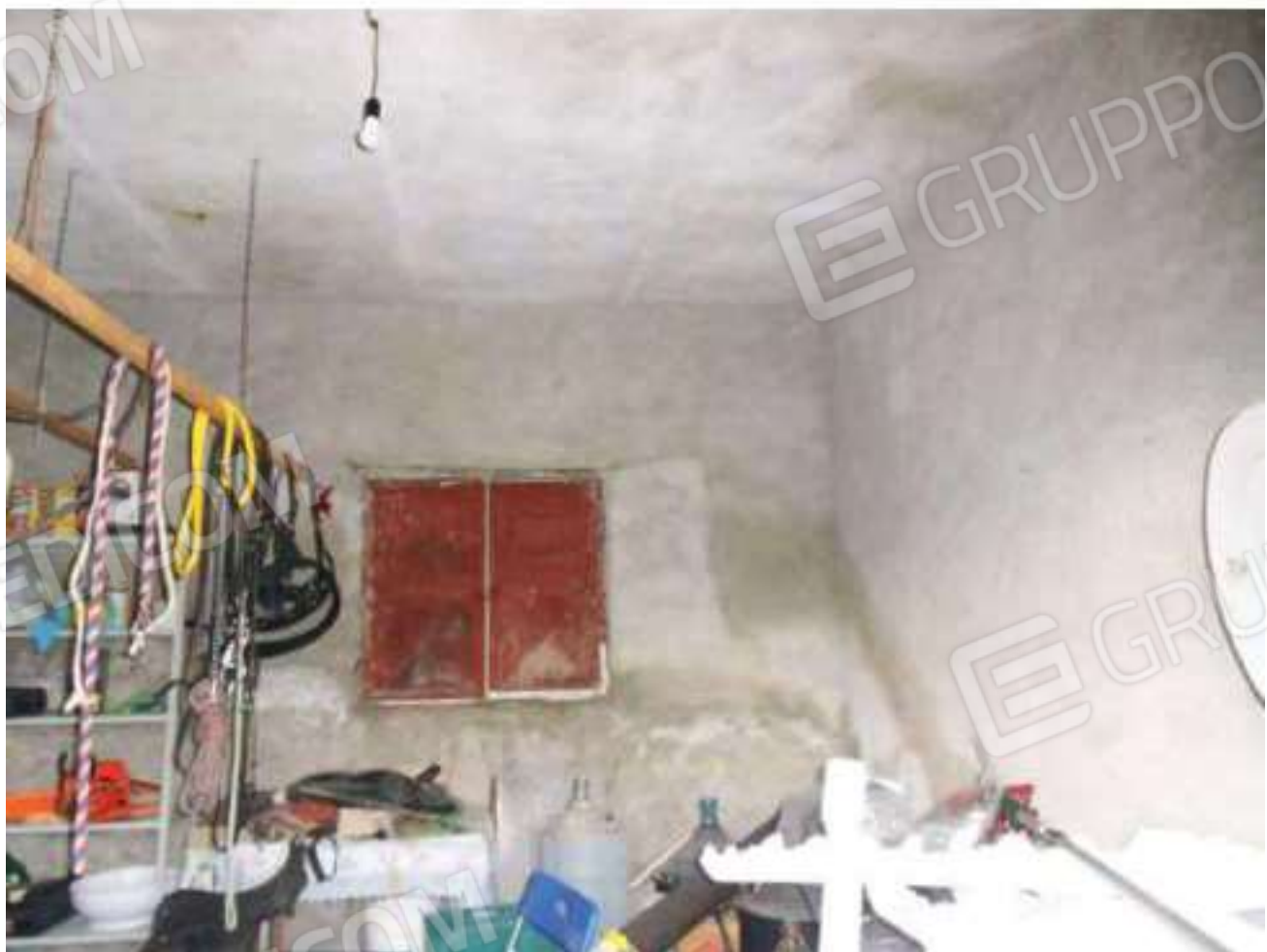
FOTO N. 134: Interni Bene N. 2
