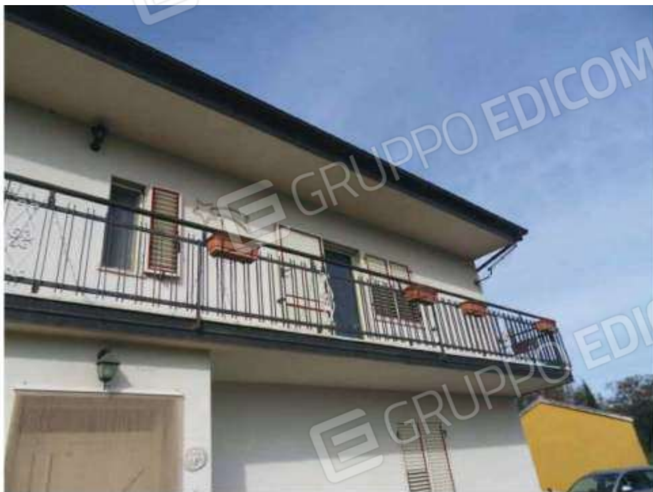
FOTO N. 7: Prospetto SUD - EST Bene N. 1
