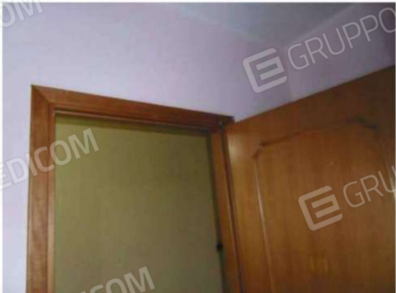
FOTO N. 116: Interni Bene N. 1 (PIANO PRIMO)
