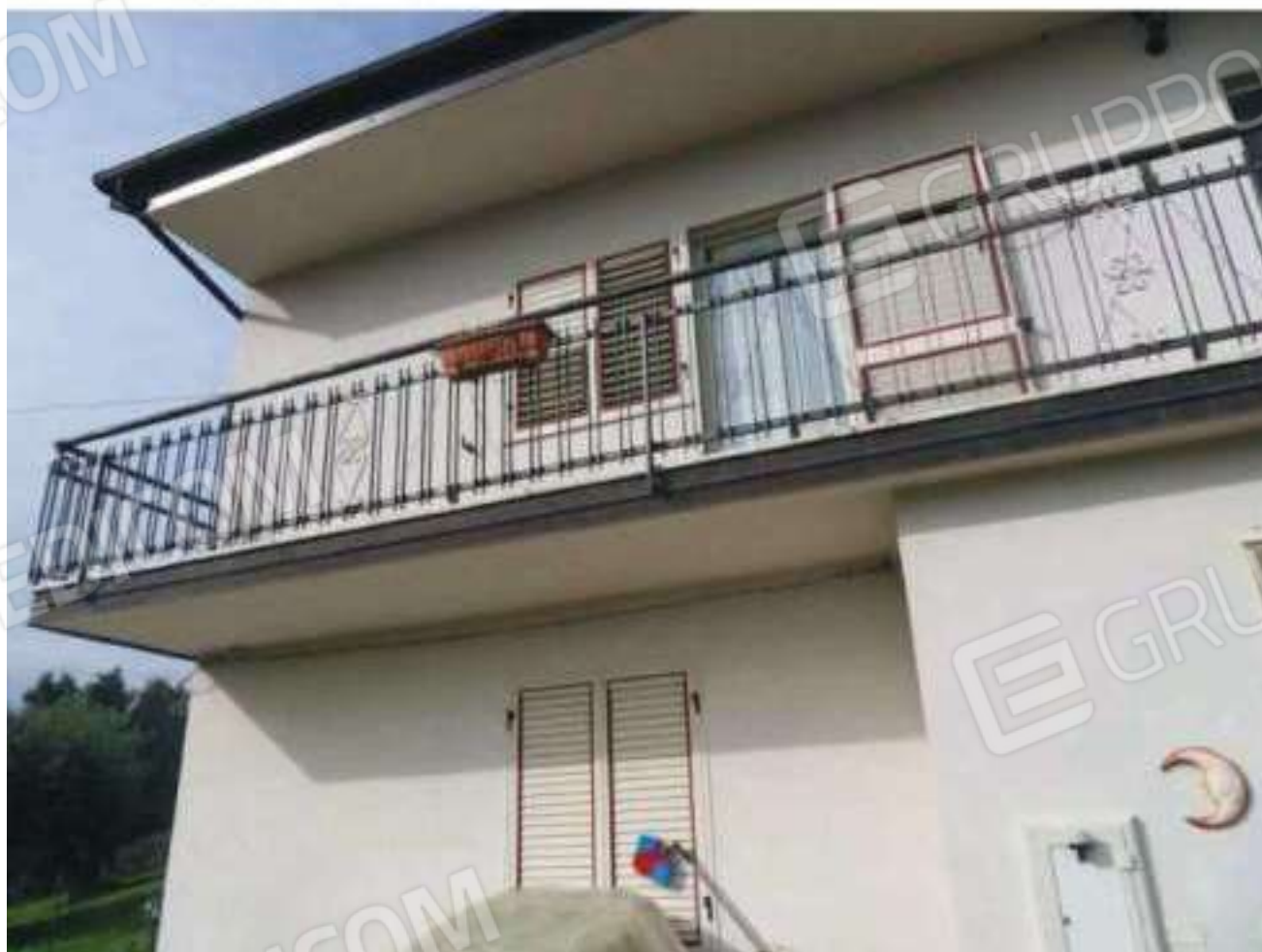
FOTO N. 8: Prospetto SUD - EST Bene N. 1
