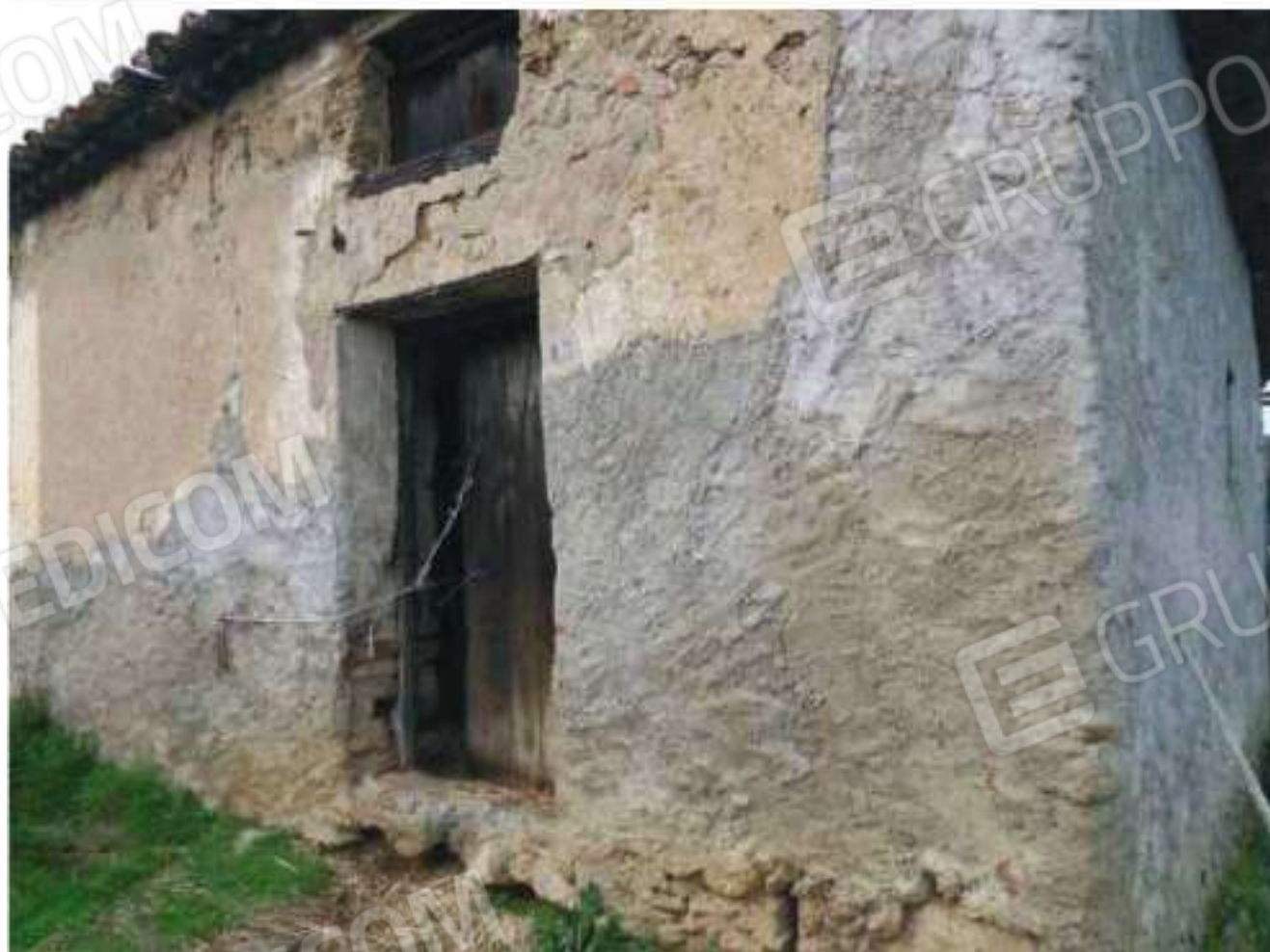
FOTO N. 138: Prospetto SUD – EST Bene N. 3
