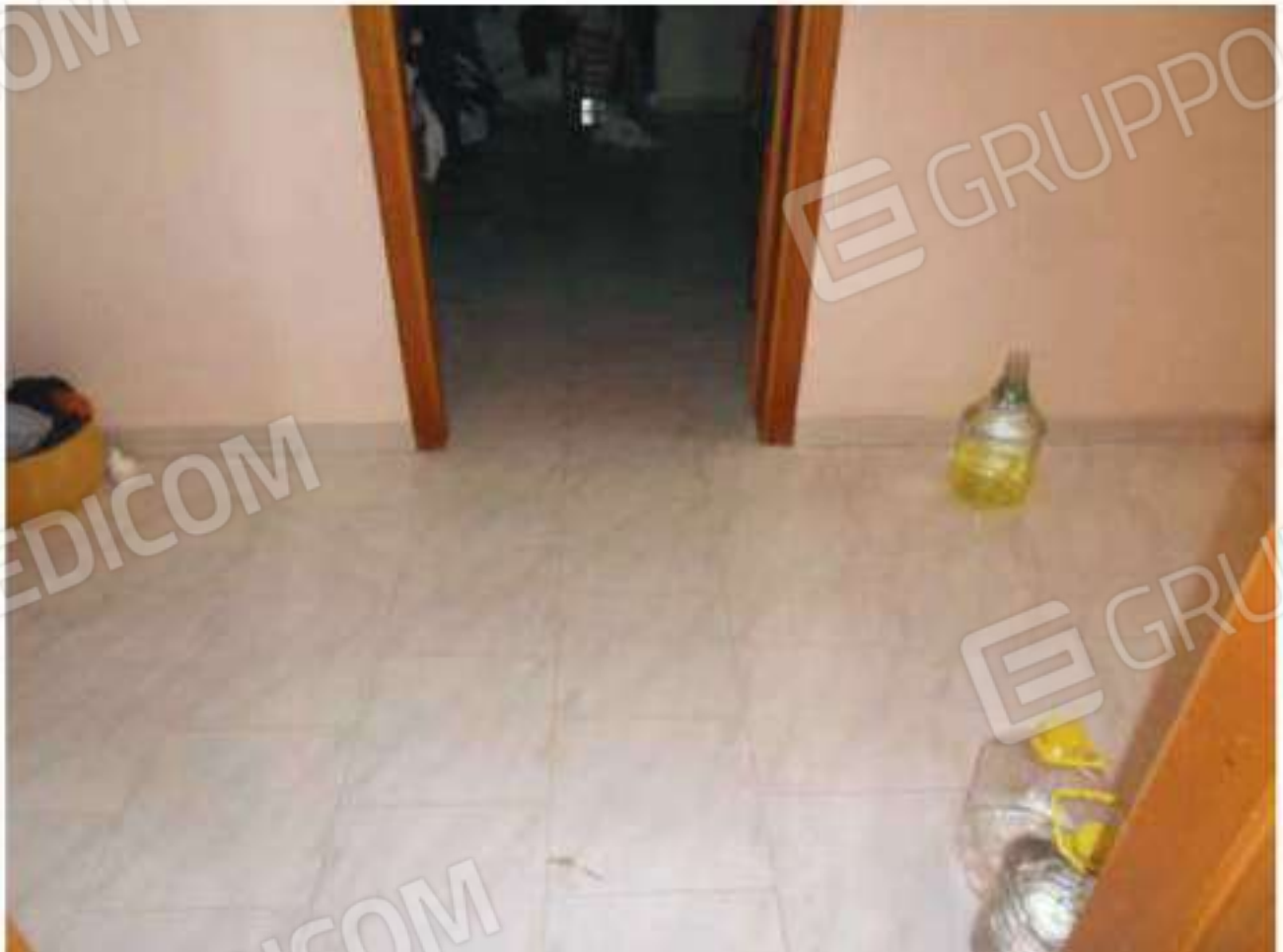
FOTO N. 26: Interni Bene N. 1 (PIANO TERRA)
