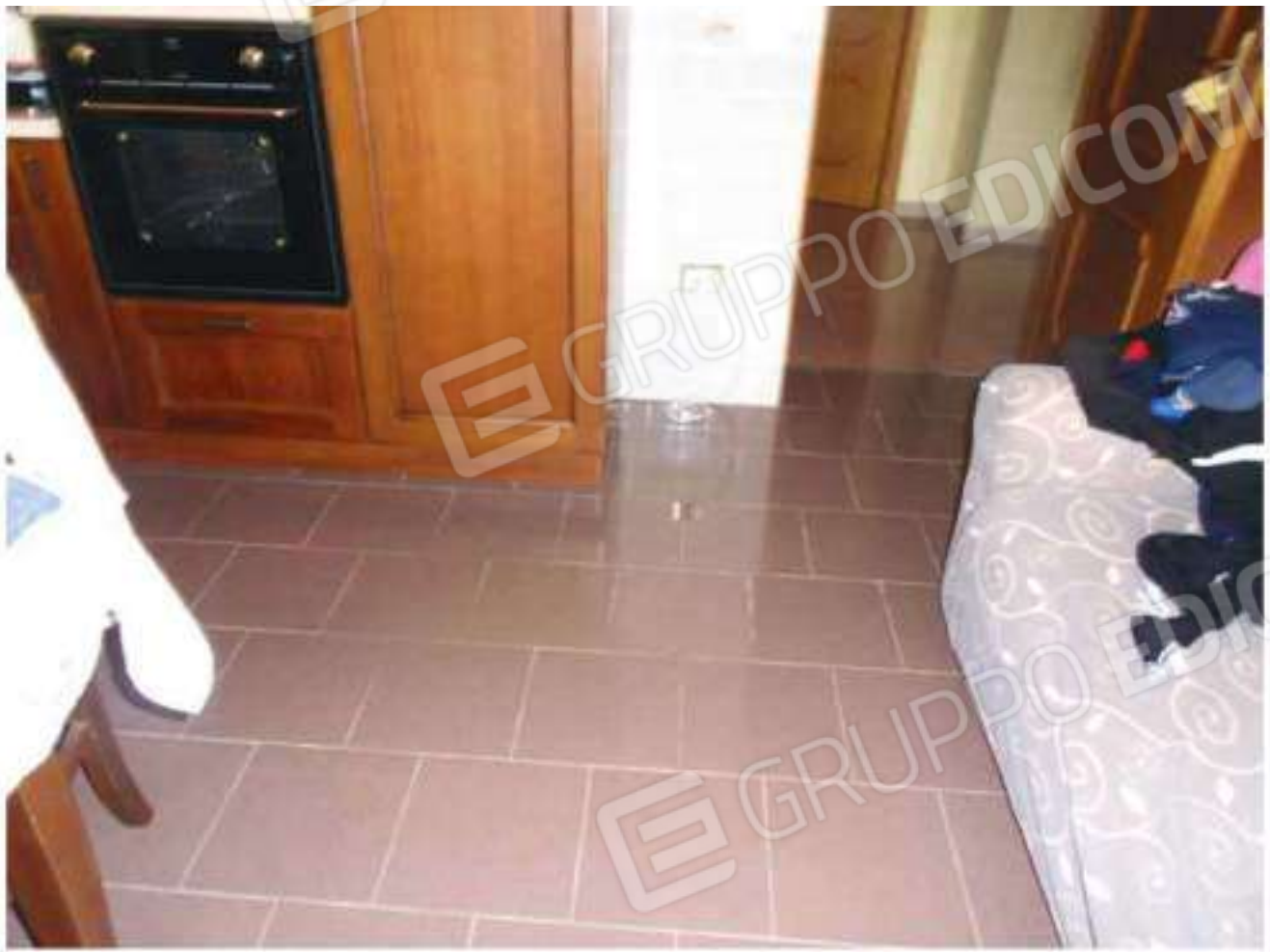
FOTO N. 77: Interni Bene N. 1 (PIANO PRIMO)
