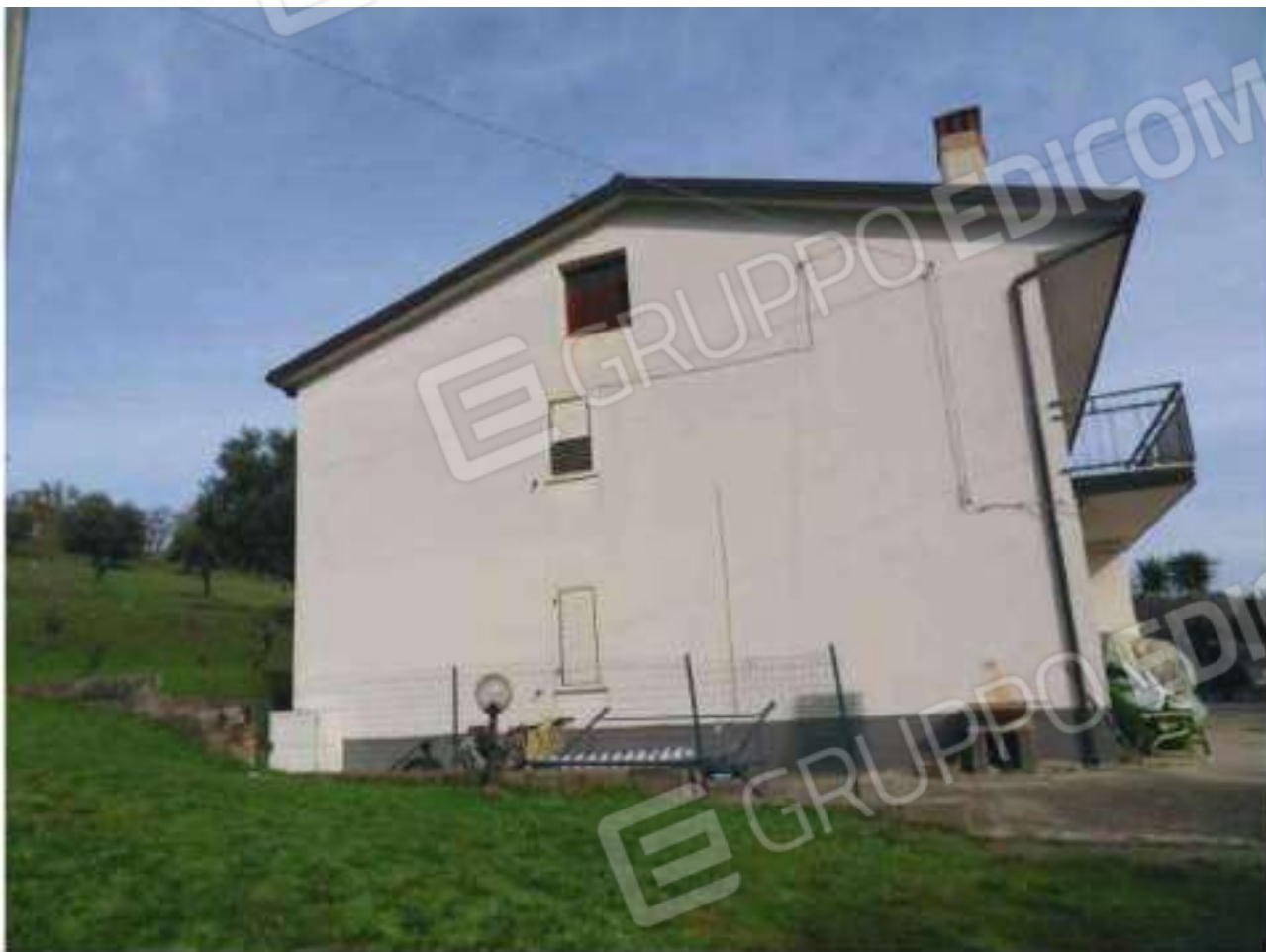
FOTO N. 15: Prospetto SUD - OVEST Bene N. 1
