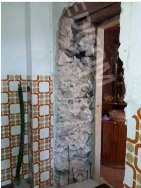
LOTTO 1: Piano primo - ripostiglio
