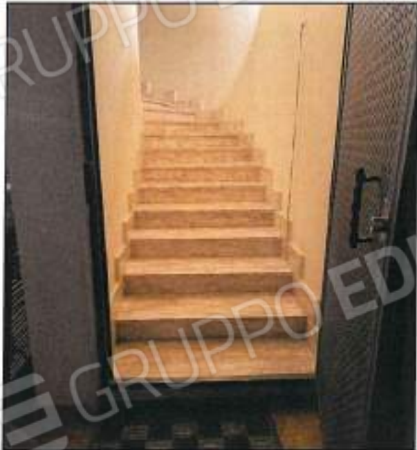
Foto n° 15 - Vista interna scala che conduce dal piano seminterato al piano terra /trabato del fabbricato, sono visibili le rifiniture in marmo travertino di buona qualità.
