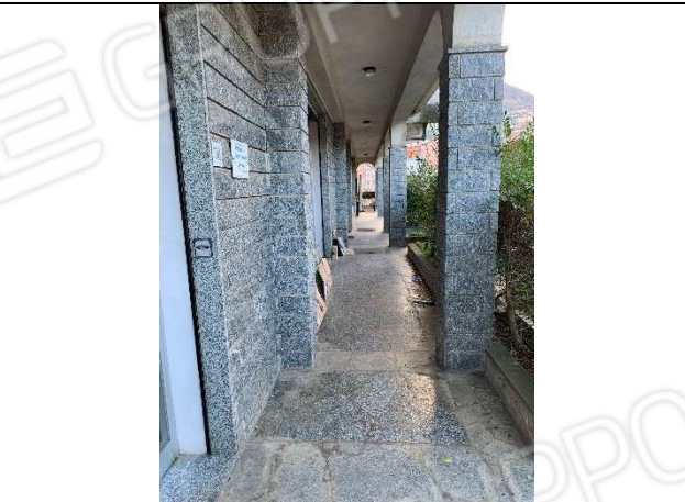
VISTA INGRESSO NEGOZIO (Cespite 3) PORTICO SU VIA M. di SAVOIA
