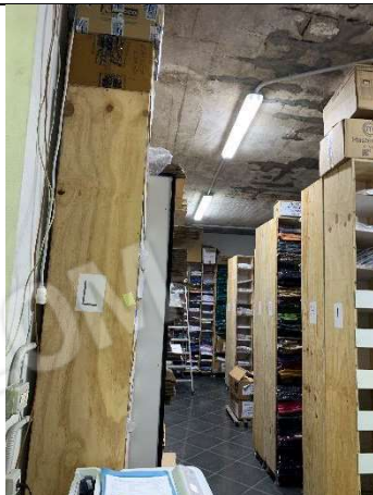
VISTA INTERNA SECONDO MAGAZZINO (Cespite 2)
