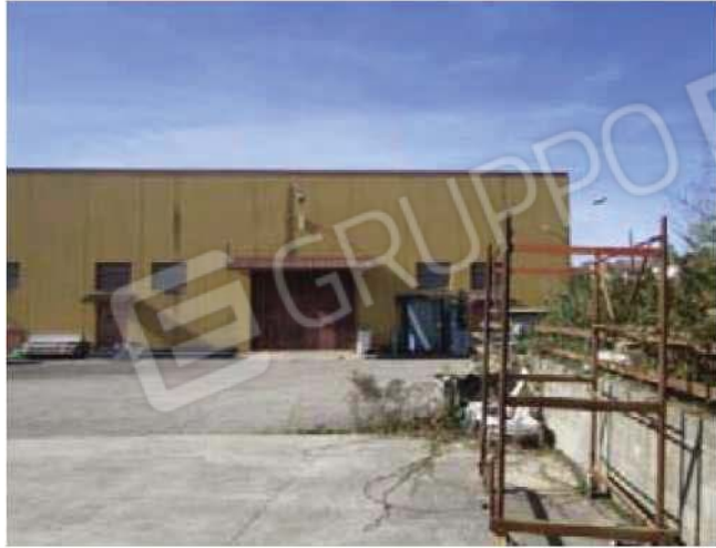
Foto 19-Vista prospetto lato Est e Corte comune -
