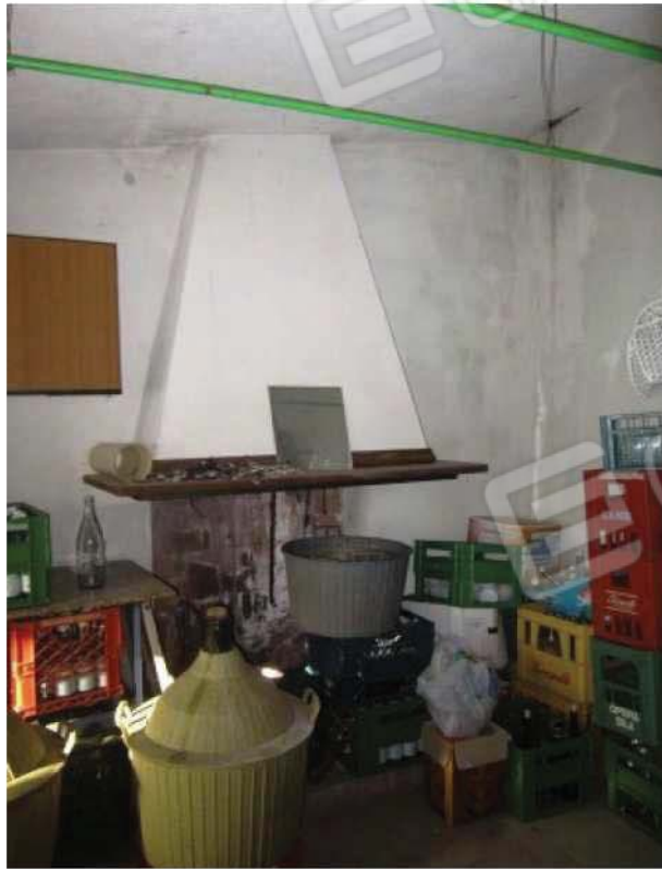
Foto 9- Locale deposito e cantina non accatastati-
