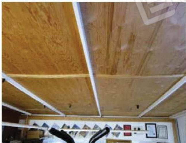
Foto 29-Locali abusivi posti al livello superiore -
