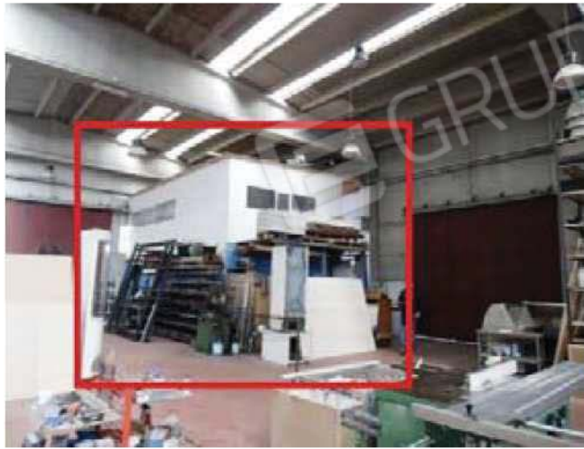
Foto 10-Piano Terra con indicazione locale abusivo realizzato-
