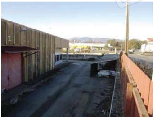
Foto 9--Vista prospetto lato Nord e Corte comune --
