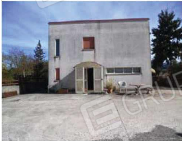
Foto 1- Vista Prospetto lato Ovest Sub 9 edificio in c.a.-
