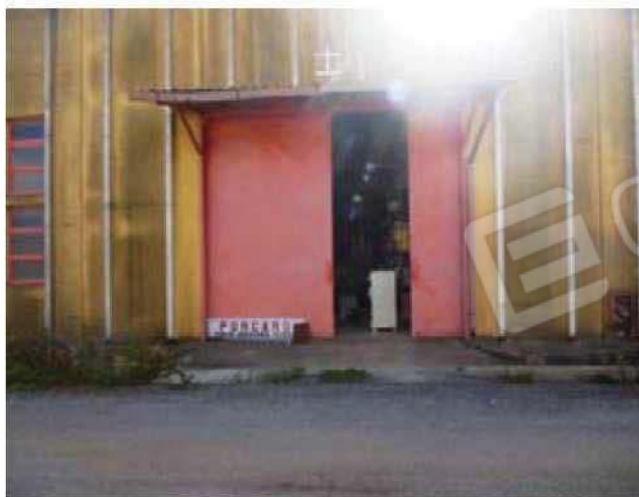
Foto 2-Ingresso Sub 9 lato Nord-
