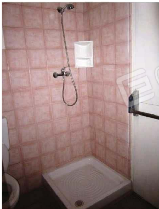
Foto 11: Servizi igienici e Porta di uscita lato Sud -
