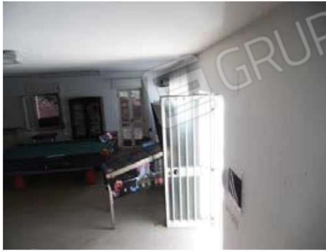
Foto 6-Ingresso a piano terra Sub 9 edificio in c.a.-
