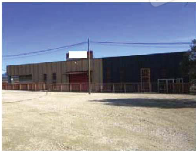
Foto 6 -Vista Prospetto Ovest -
