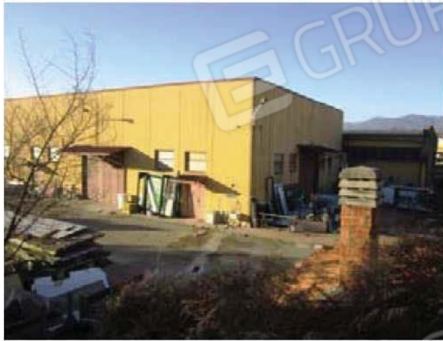
Foto 14-Vista prospetto lato Nord-Est -
