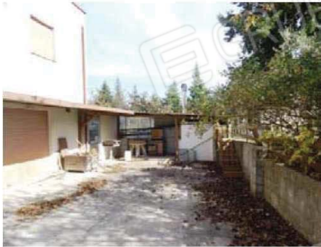
Foto 26-Vista prospetto Sud edificio in c.a. e Corte comune-
