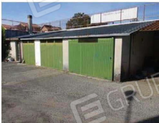
Foto 1-Locali garage, deposito e cantina non accatastati-
