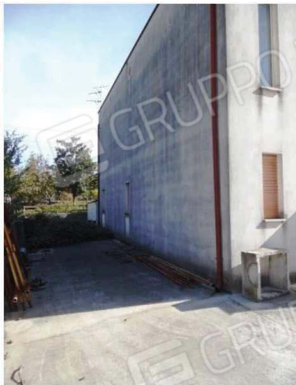
Foto 28-Vista prospetto laterale edificio in c.a. e Corte comune -
