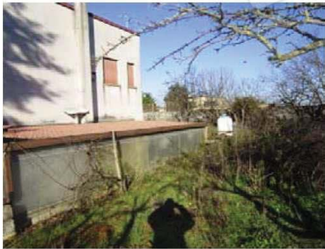
Foto 27 Vista prospetto laterale edificio in c.a. e Corte comune -
