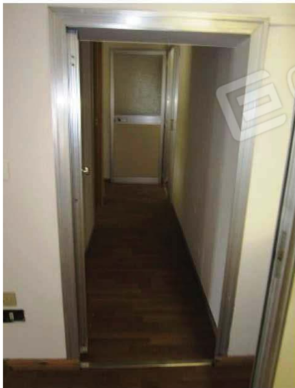
Foto 17-Ingresso piano superiore Sub 8-
