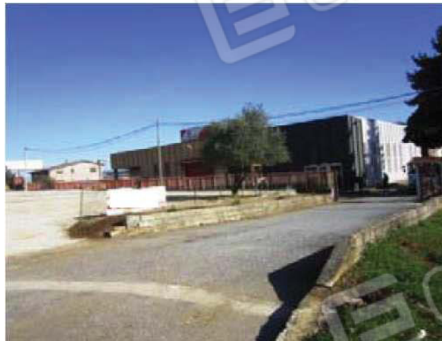
Foto 2- Ingresso lato Ovest -
