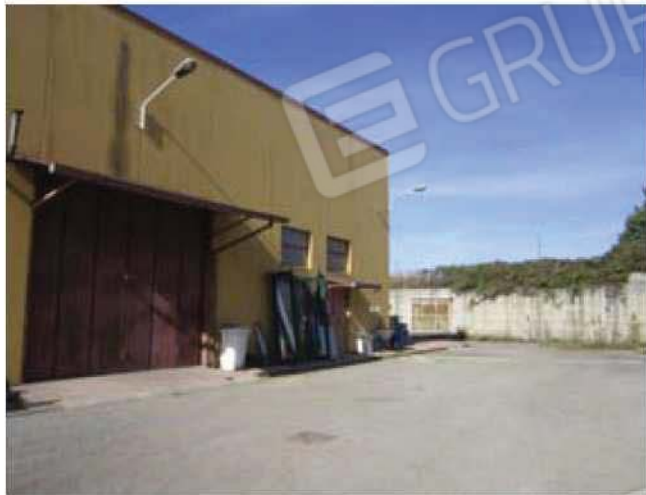
Foto 20-Vista prospetto lato Est e Corte comune -
