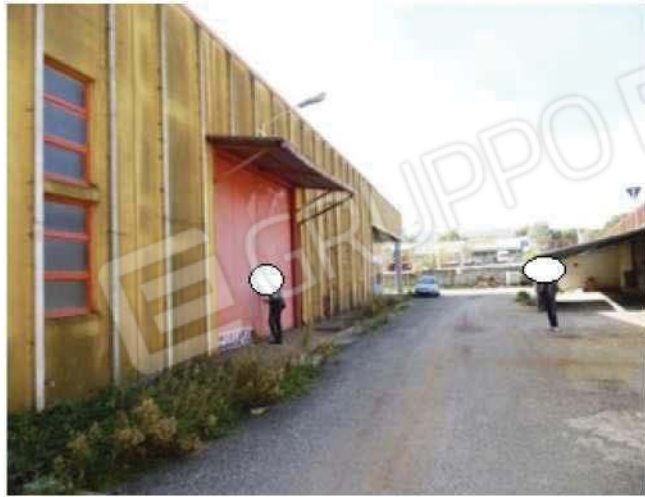
Foto 10-Vista prospetto lato Nord e Corte comune -
