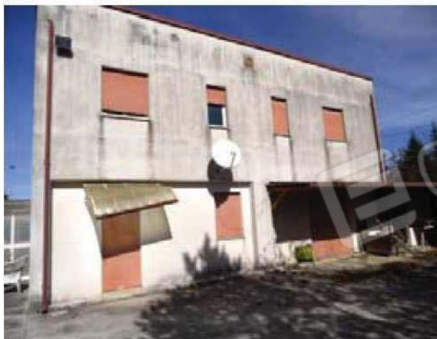
Foto 2- Vista Prospetto lato Sud sub 9-
