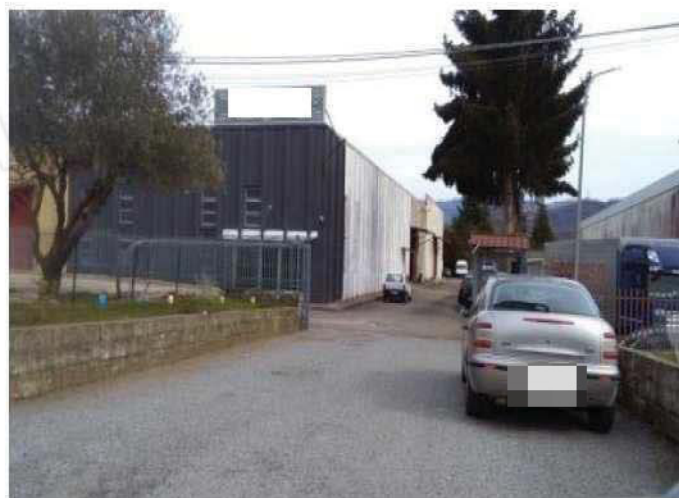
Foto 3-Ingresso lato Ovest e Vista Prospetto lato Sud/Ovest -
