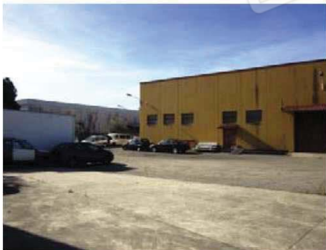
Foto 18-Vista prospetto lato Est e Corte comune -
