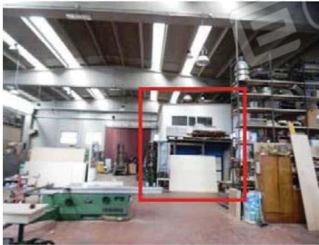
Foto 8-Piano Terra con indicazione locale abusivo realizzato-
