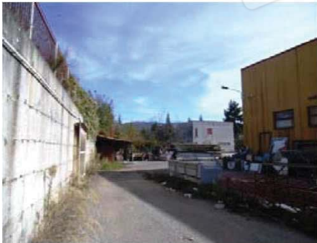
Foto 12-Vista prospetto lato Nord e Corte comune -
