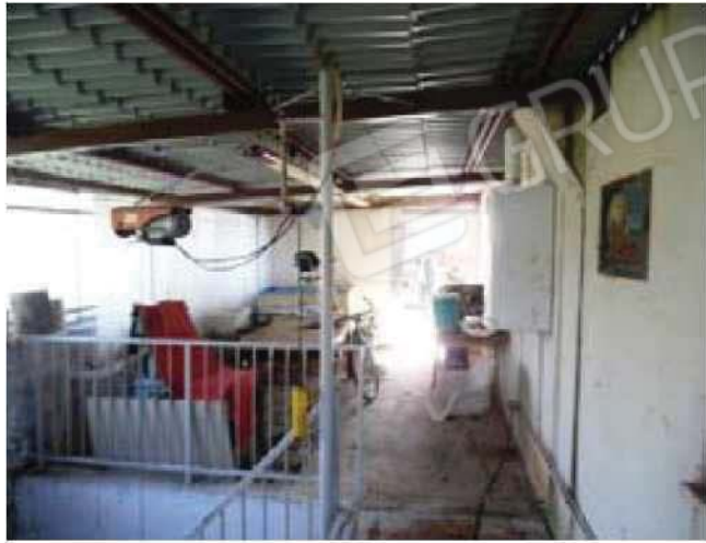
Foto 32-Locale abusivo retrostante il fabbricato non accatastato -
