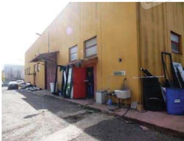
Foto 5-Ingresso lato Est Sub 9-
