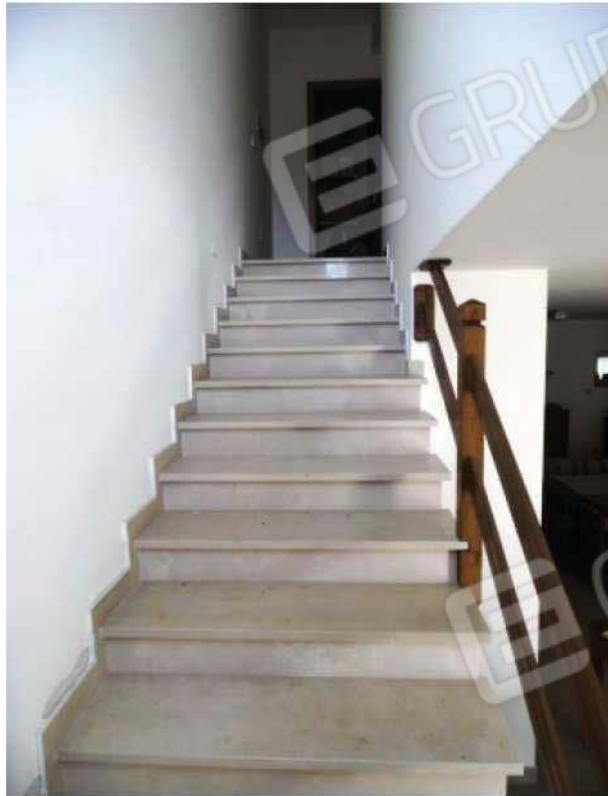
Foto 18-Scala interna di accesso al piano superiore-
