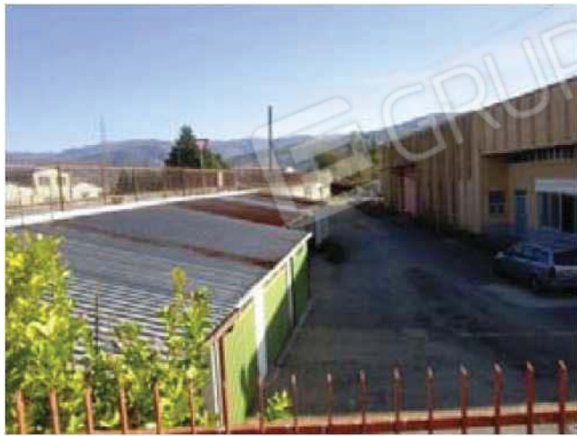
Foto 8--Vista prospetto lato Nord e Corte comune -
