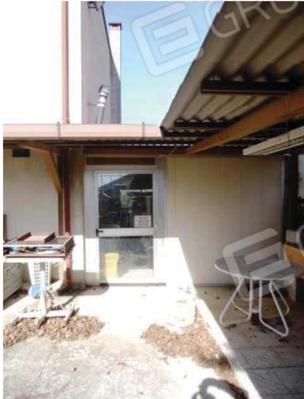
Foto 30-Locale abusivo retrostante il fabbricato non accatastato
