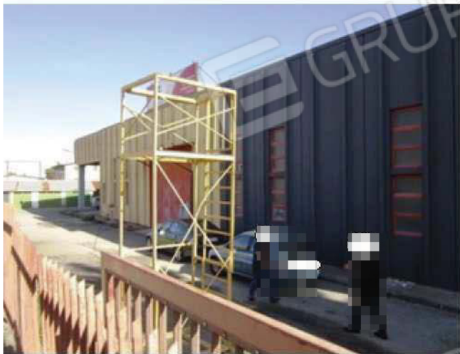
Foto 5 -Vista Prospetto Ovest -
