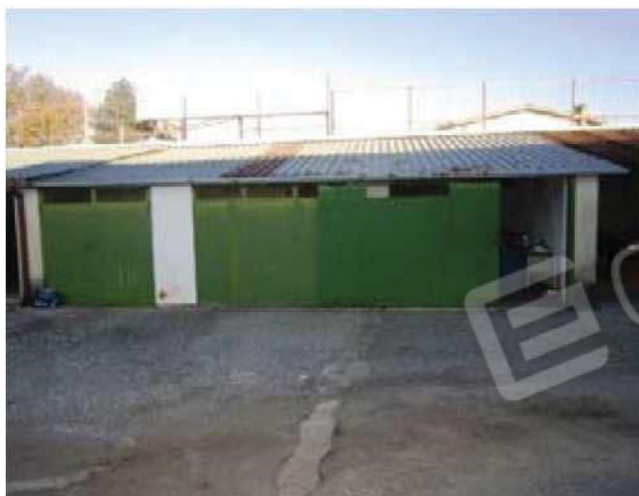
Foto 2-Locali garage, deposito e cantina non accatastati-
