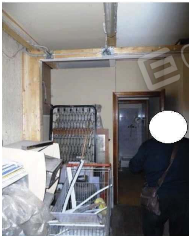
Foto 13-Locali abusivi posti a piano terra Sub 9-
