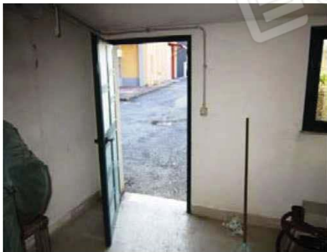
Foto 7-Ingresso Locale deposito e cantina non accatastati-
