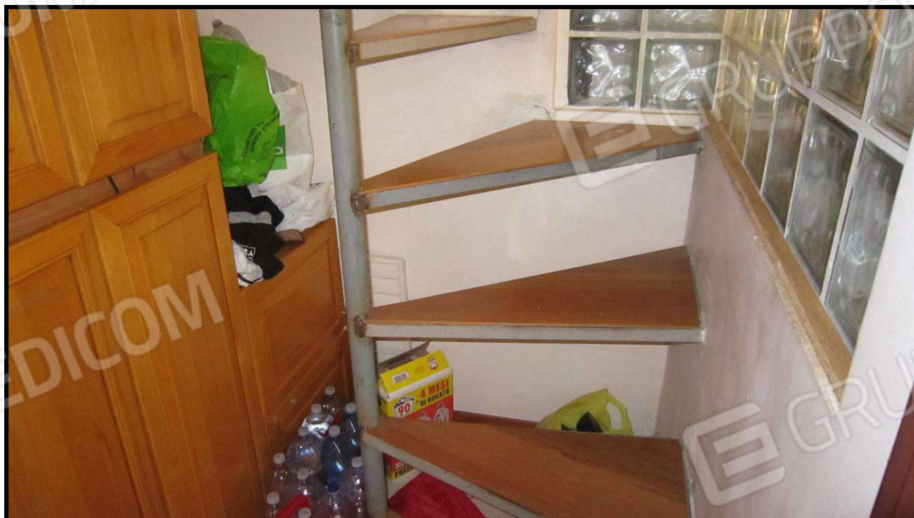
Foto 20 Abitazione part. 755 sub. 3 – Scala di accesso al sottotetto
