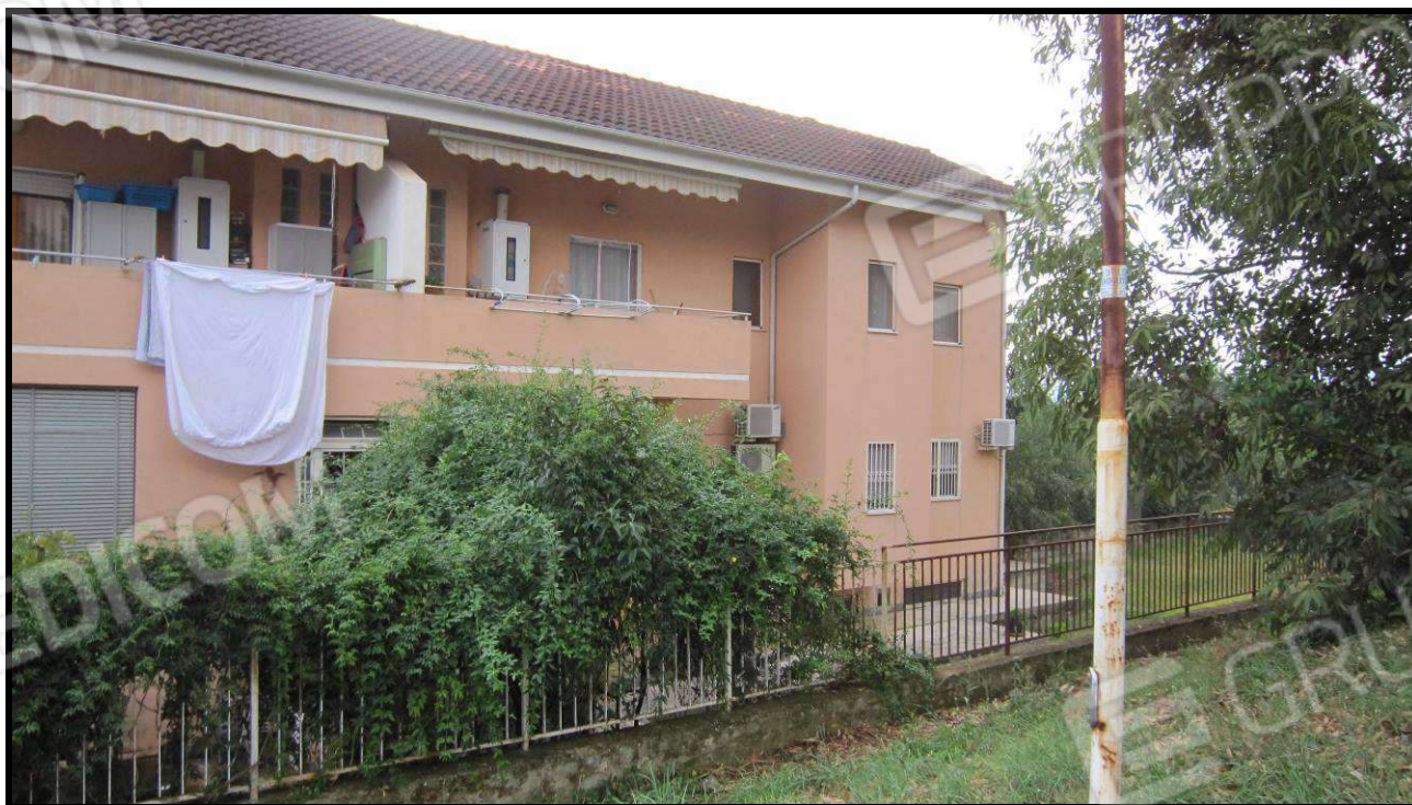
Foto 2 Fabbricato part. 755 in vista da Nord-Ovest
