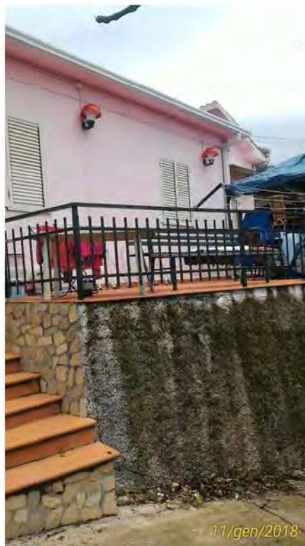
Fig. 6 – Visione particolareggiata della corte
