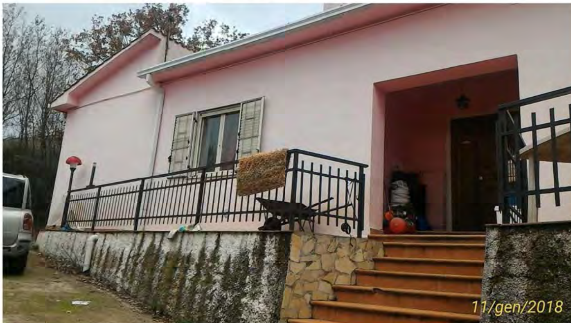
Fig. 7 – Visione particolareggiata della corte
