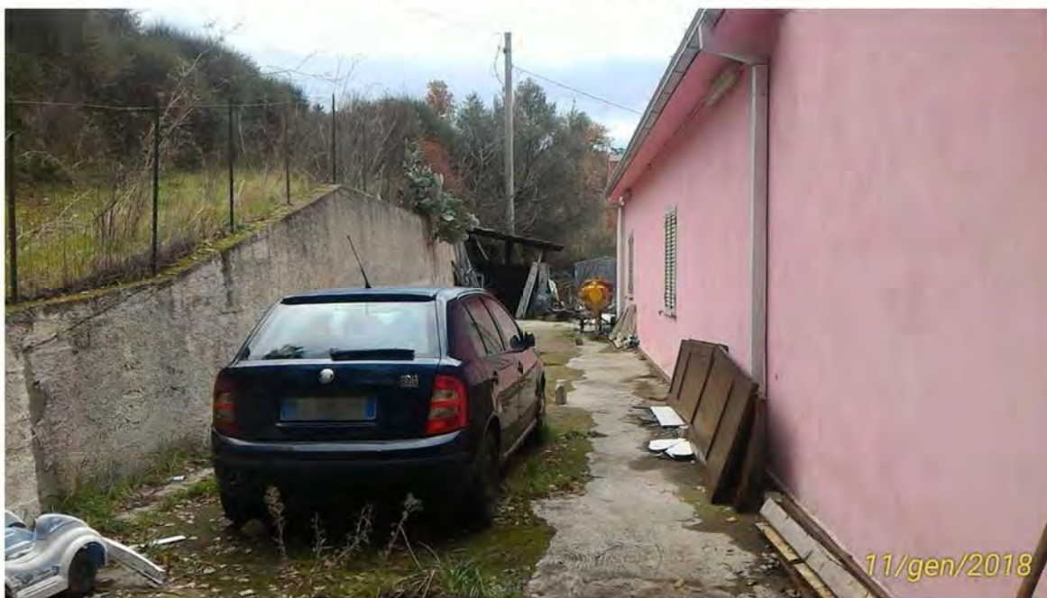
Fig. 2 – Visione particolareggiata del muro di sostegno
