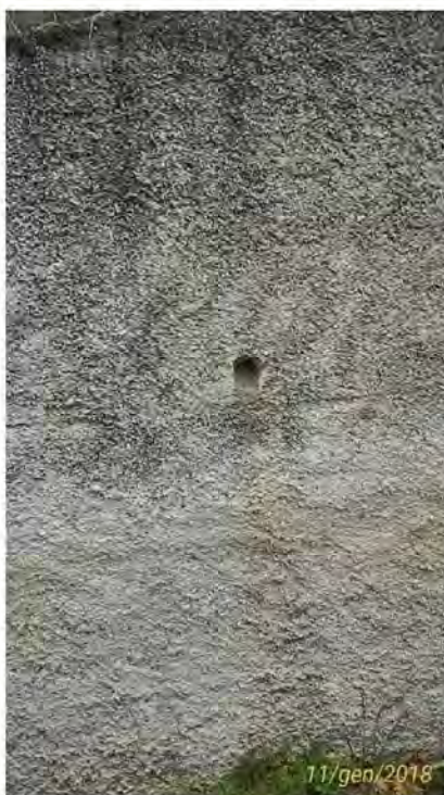
Fig. 23 – Visione particolareggiata muro intasato
