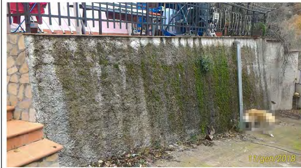
Fig. 12 – Visione particolareggiata opere di livellamento
