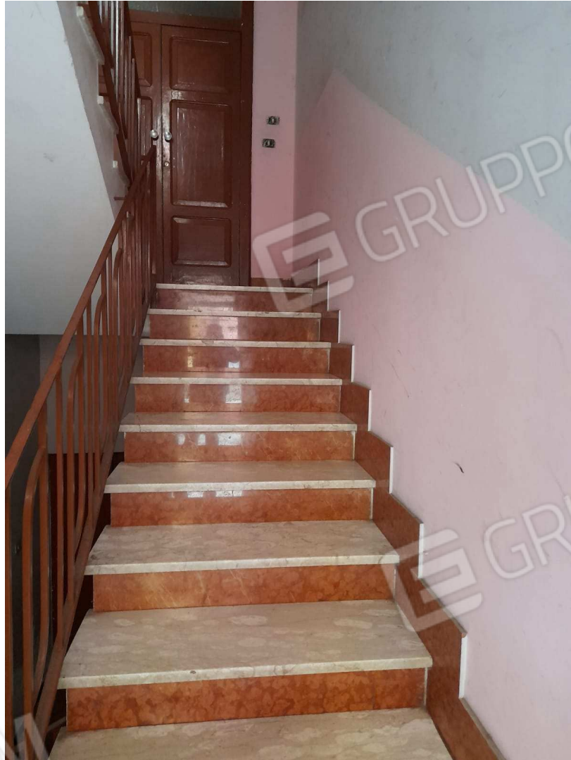
Scala accesso appartamento
