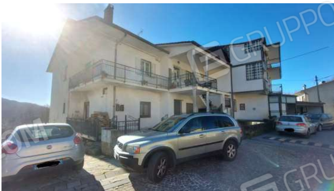
Foto n.2: Vista generale esterna
