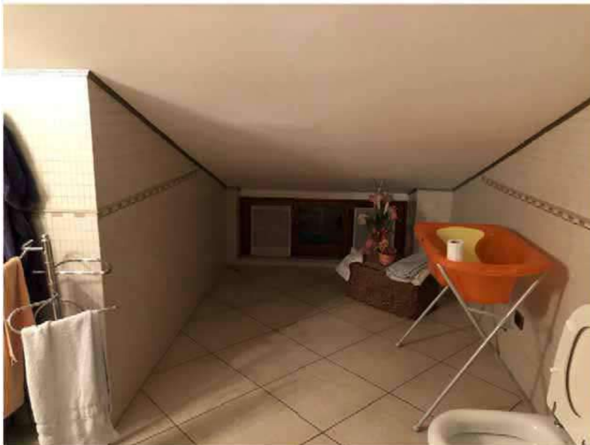
Foto 41 – Bagno al piano secondo/sottotetto.
