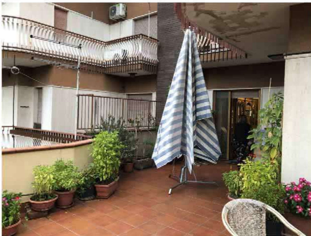
Foto 19 – Terrazzo piano terra lato Ovest.
