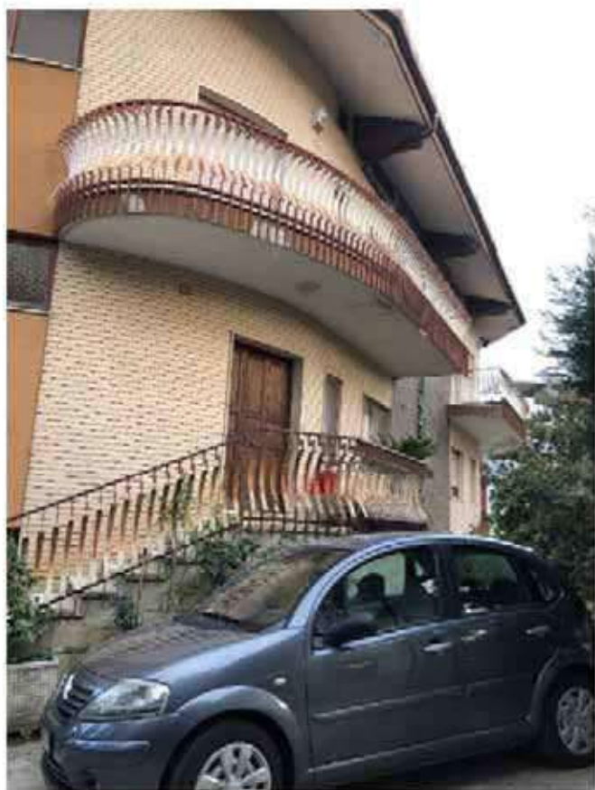
Foto 2 – Scala esterna di ingresso lato Est.
