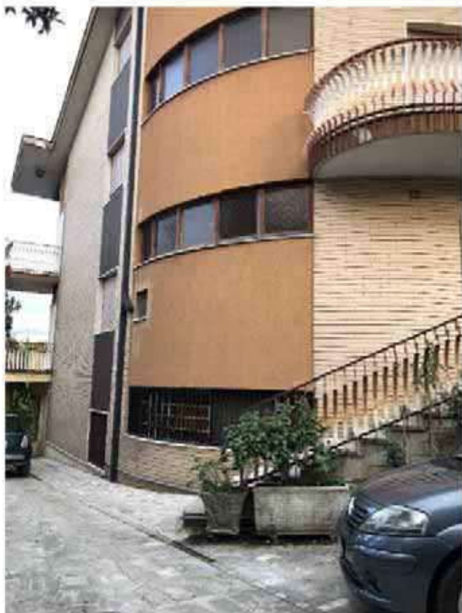
Foto 1 – Esterno fabbricato lato Sud.
