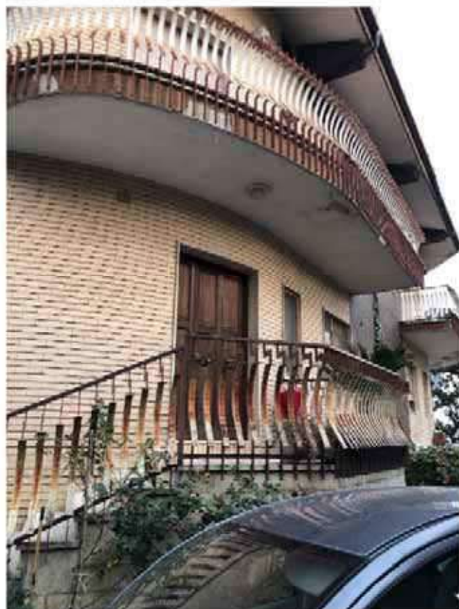
Foto 7 – Ballatoio scala di accesso esterna al piano terra lato Est.
