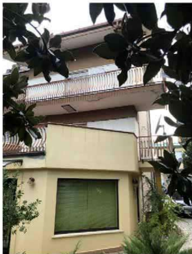
Foto 3 – Terrazzo piano terra lato Ovest
