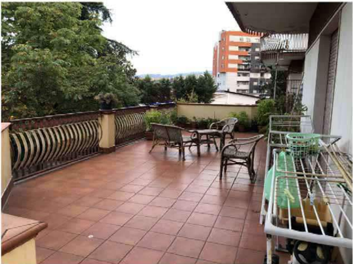
Foto 22 – Terrazzo piano terra lato Ovest.
