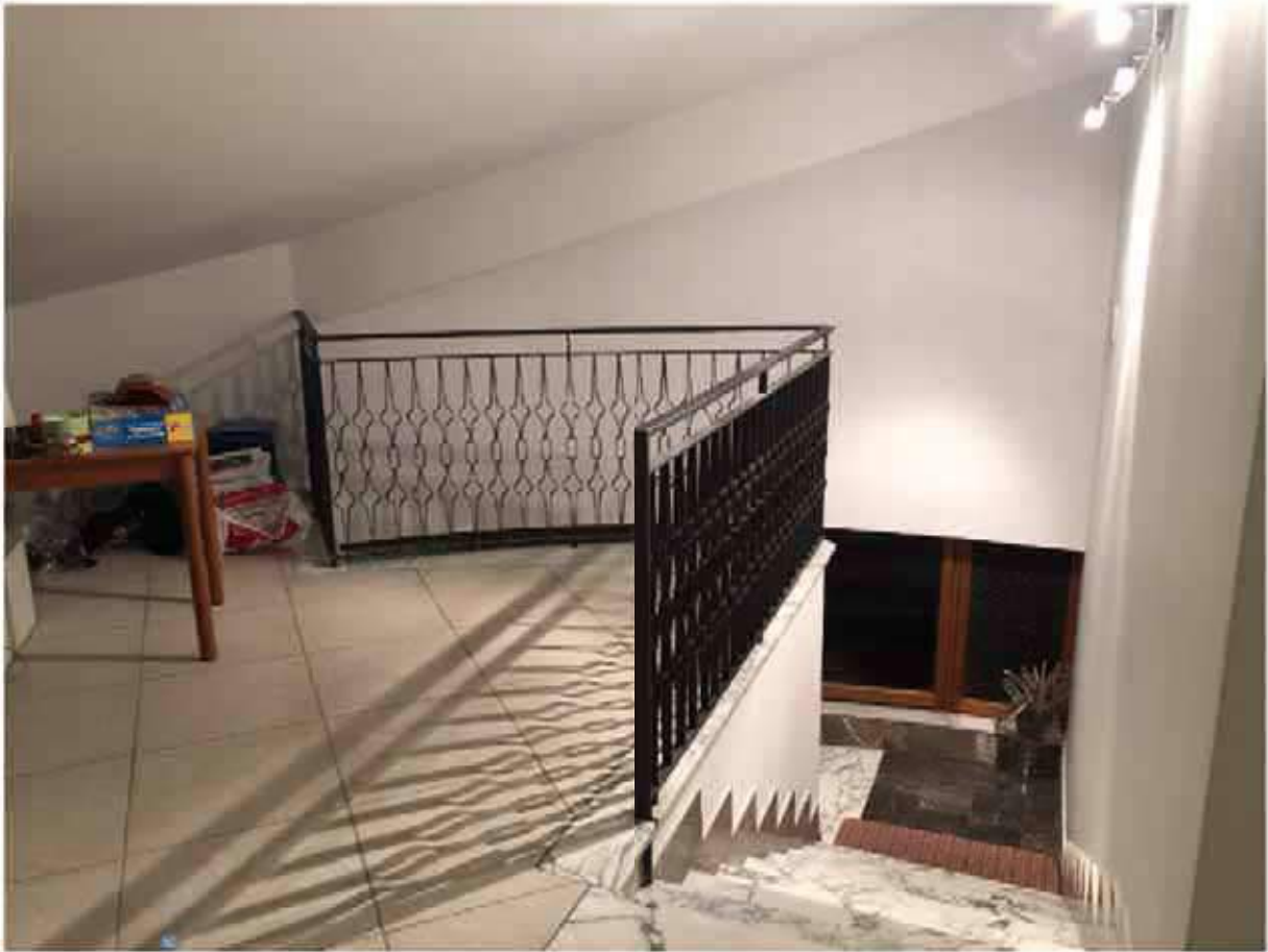
Foto 31 – Ballatoio scala al piano secondo/sottotetto.
