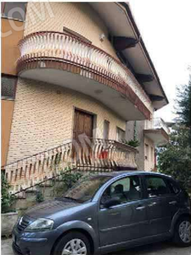
Foto 2 – Scala esterna di ingresso lato Est.
