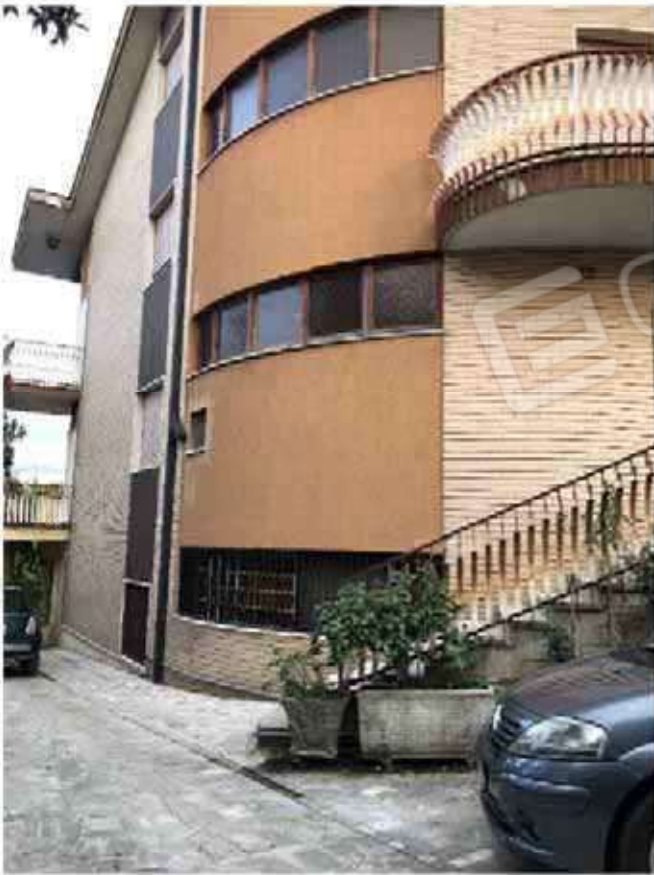
Foto 1 – Esterno fabbricato lato Sud.
