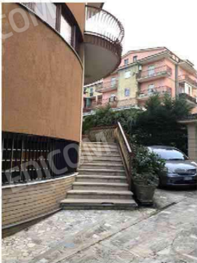
Foto 6 – Scala esterna di accesso al piano terra lato Est.
