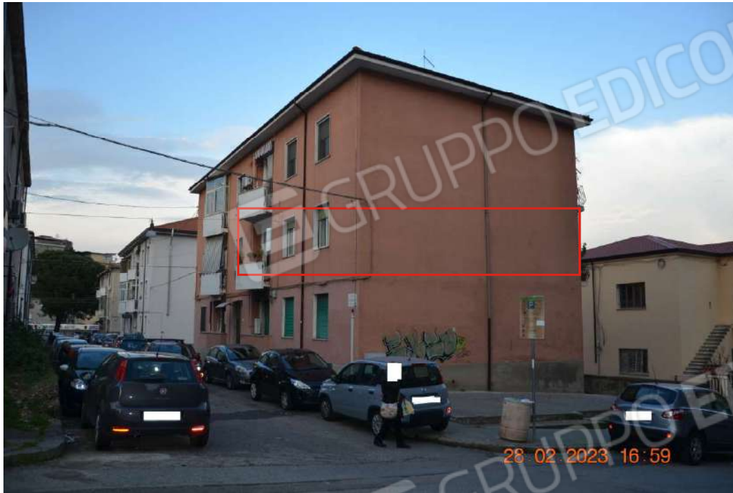
FOTO N. 1 - Fabbricato in Cosenza Via Tommaso Telesio, 2 Appartamento posto al Piano Primo
