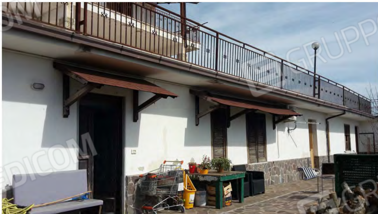
Ingresso e fronte principale dell'appartamento al livello seminterrato
