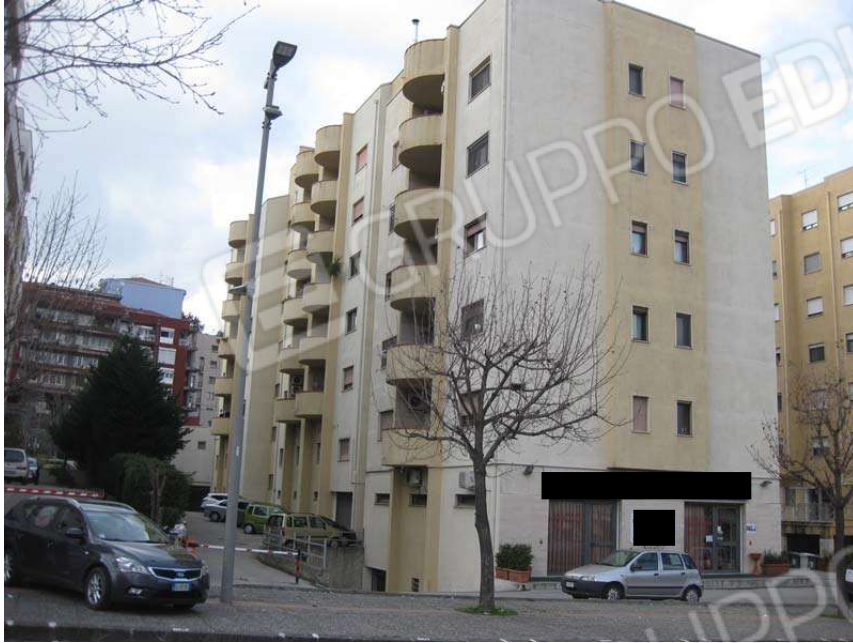
Fabbricato sito in via P. Borsellino n.263/A – Prospetto Sud - Est
