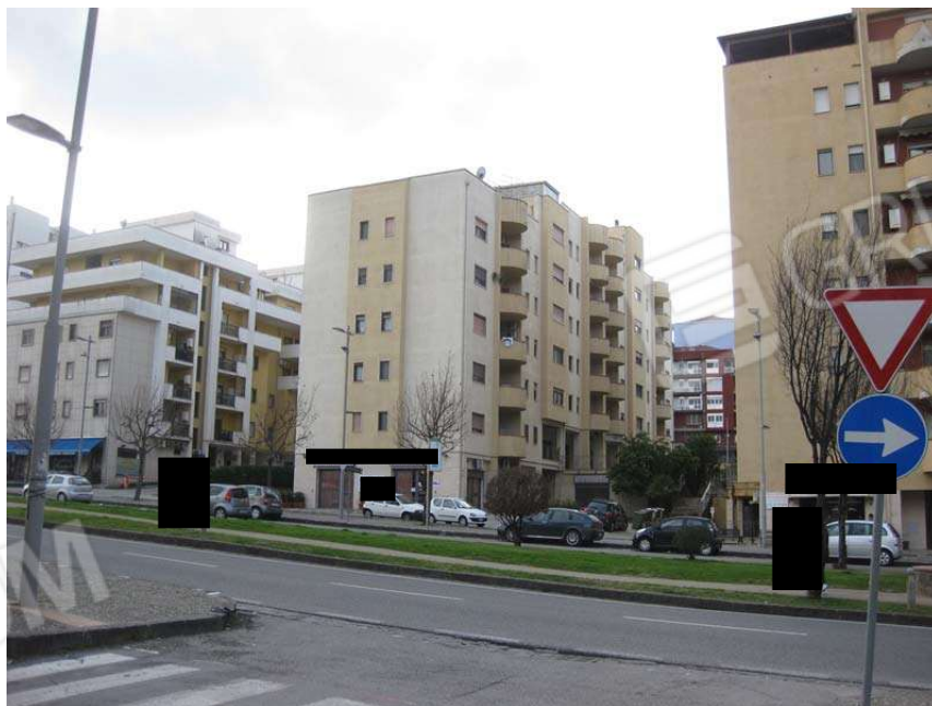
Fabbricato sito in via P. Borsellino n.263/A – Prospetto Nord - Est
