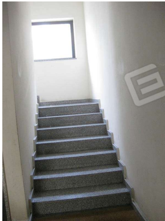
Fabbricato sito in via P. Borsellino n.263/A – Ingresso al fabbricato dal piano Terra – Vano scala
