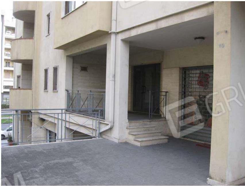
Fabbricato sito in via P. Borsellino n.263/A – Portone ingresso dal piano Terra
