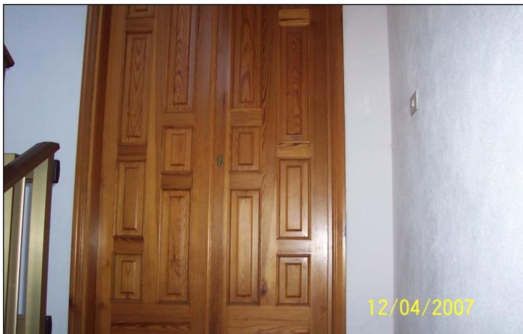
Fotografia n° 18: porta d'ingresso dell'appartamento sito al secondo piano
