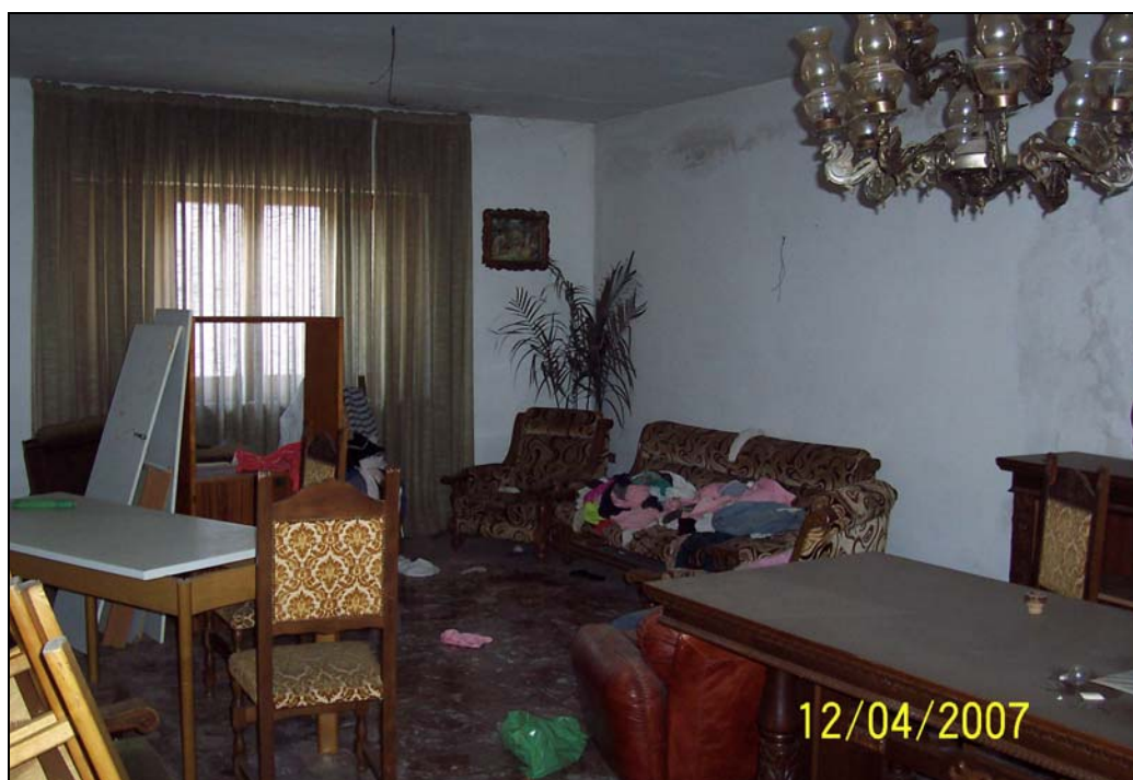
Fotografia n° 10: salone - sui muri a destra si nota la presenza di macchie d'umido
