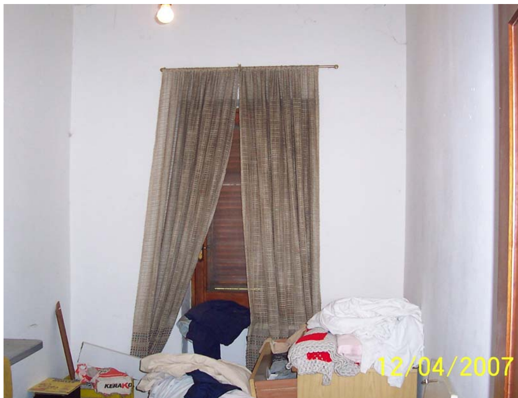
Fotografia n° 17: il vano ricavato successivamente
