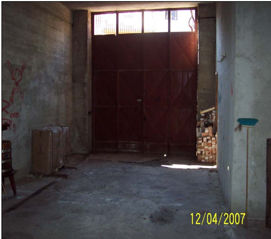
Fotografia n° 5: interno del magazzino
