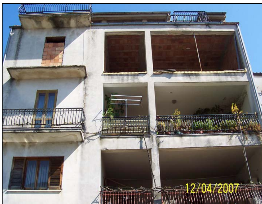
Fotografia n° 1: facciata posteriore dello stabile
