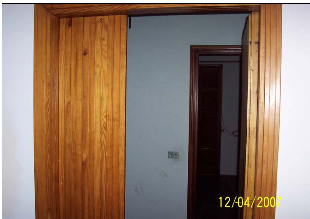
Fotografia n° 8: porta d'ingresso dell'appartamento del piano terra - rialzato
