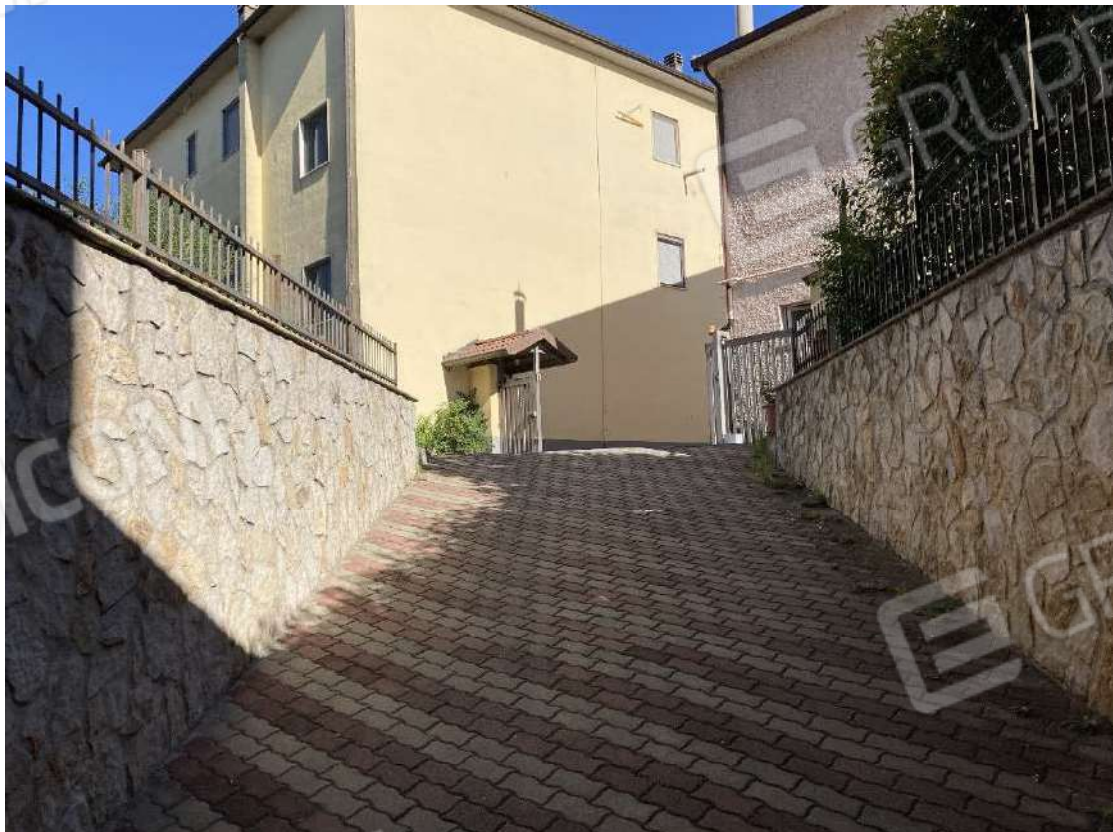
Foto 37 – rampa d'accesso a box/cantine
