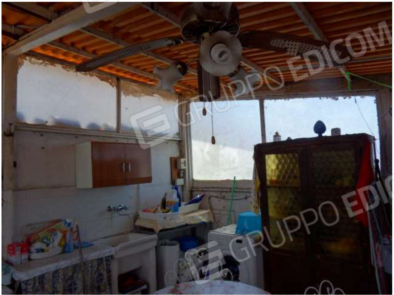
FOTO N. 29: Interni Immobile – Terrazzo
