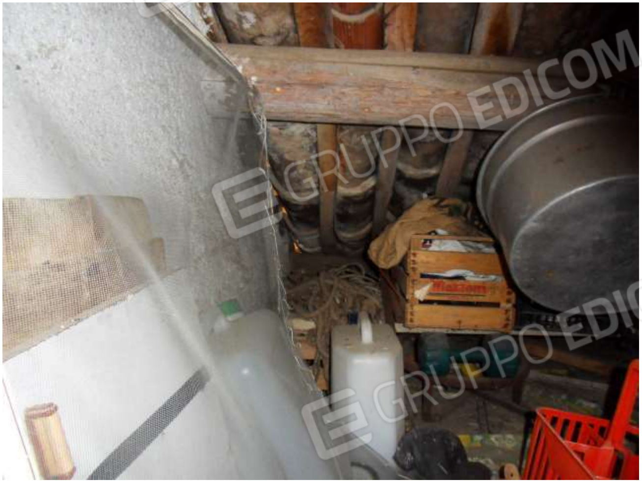
FOTO N. 41: Interni Immobile – Sottotetto
