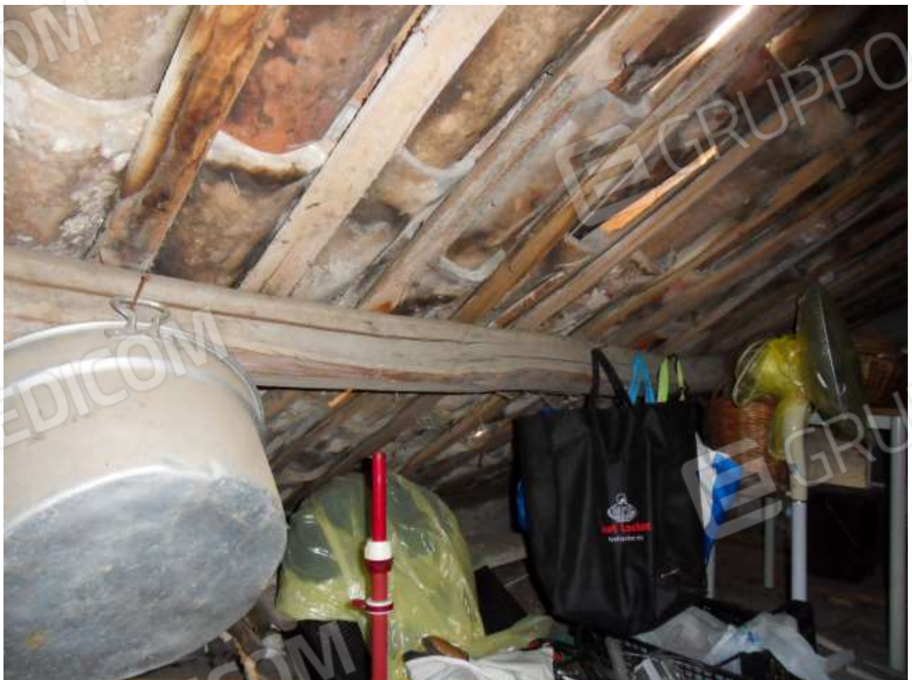
FOTO N. 40: Interni Immobile – Sottotetto
