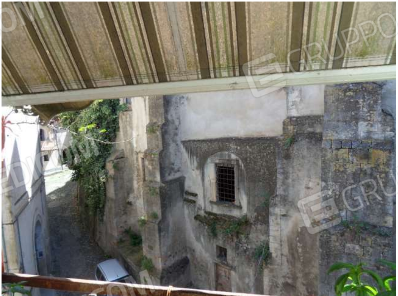
FOTO N. 64: Vista in Direzione SUD - EST da immobile
