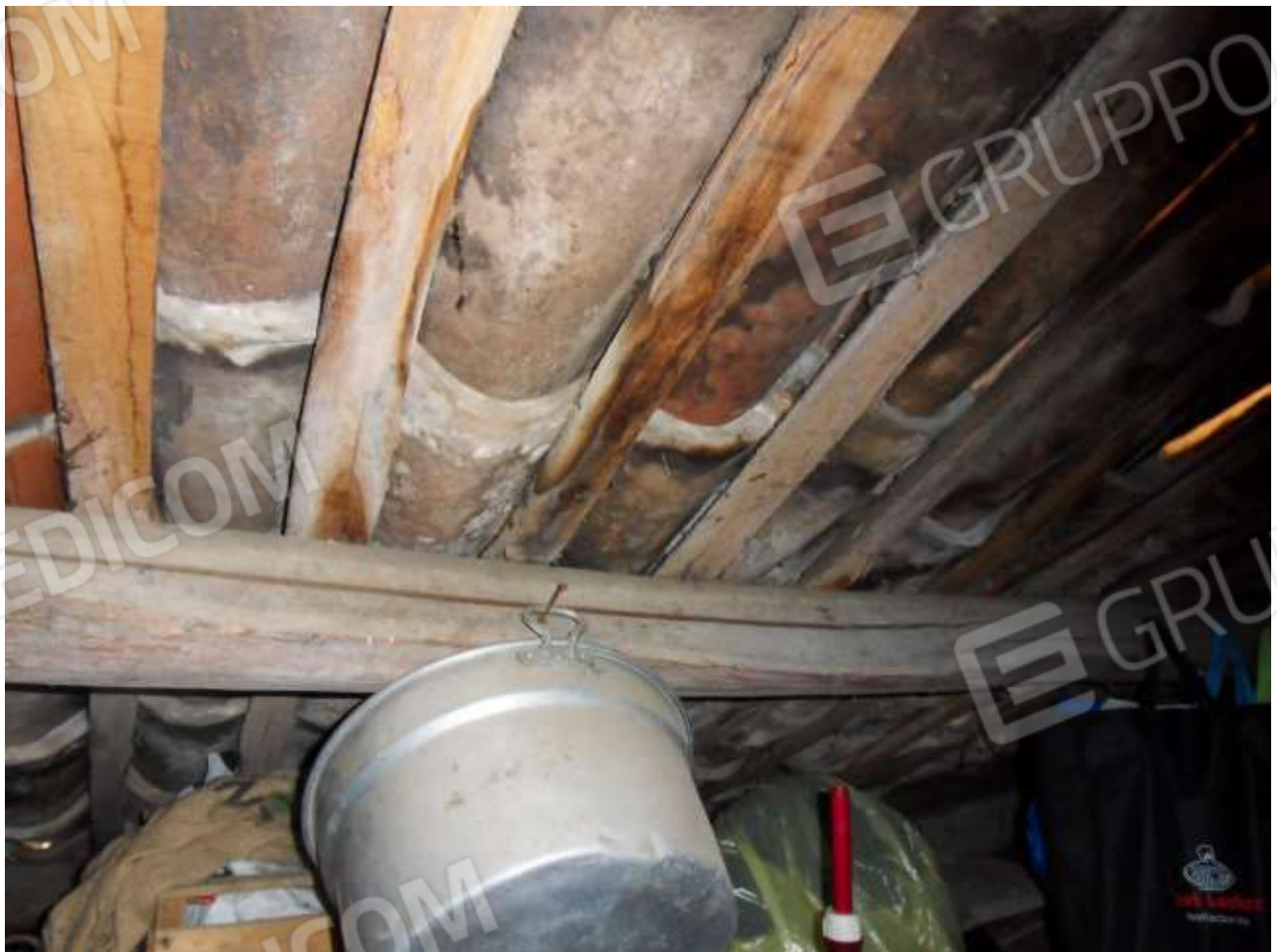
FOTO N. 42: Interni Immobile – Sottotetto
