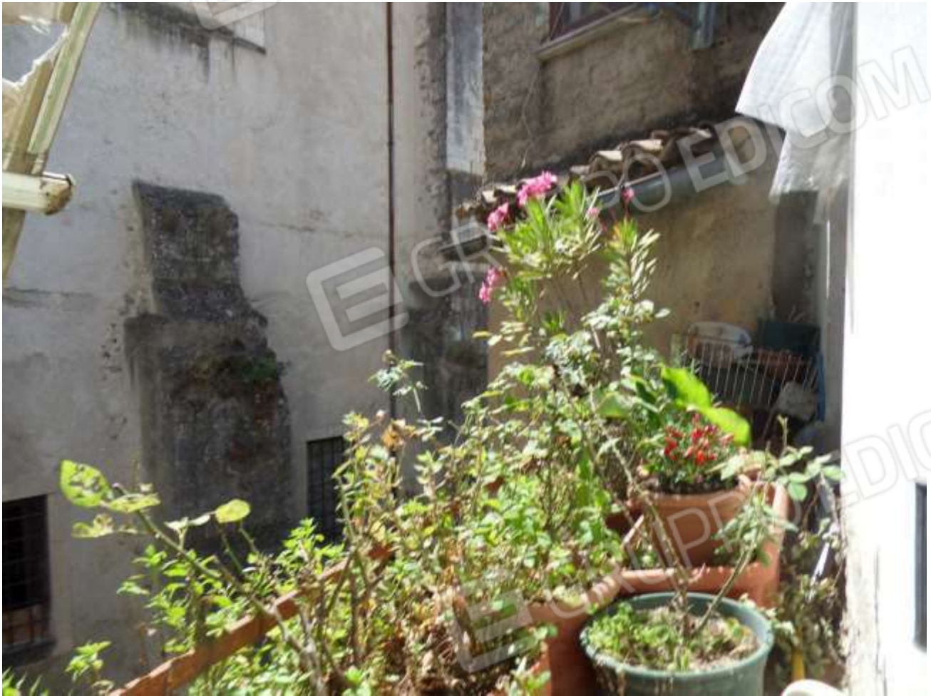
FOTO N. 65: Vista in Direzione SUD - OVEST da immobile
