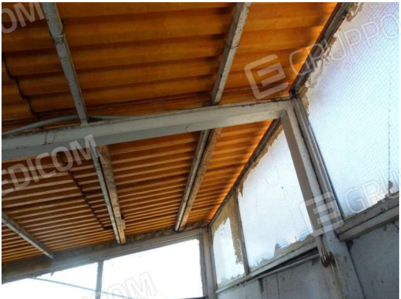
FOTO N. 34: Interni Immobile – Terrazzo
