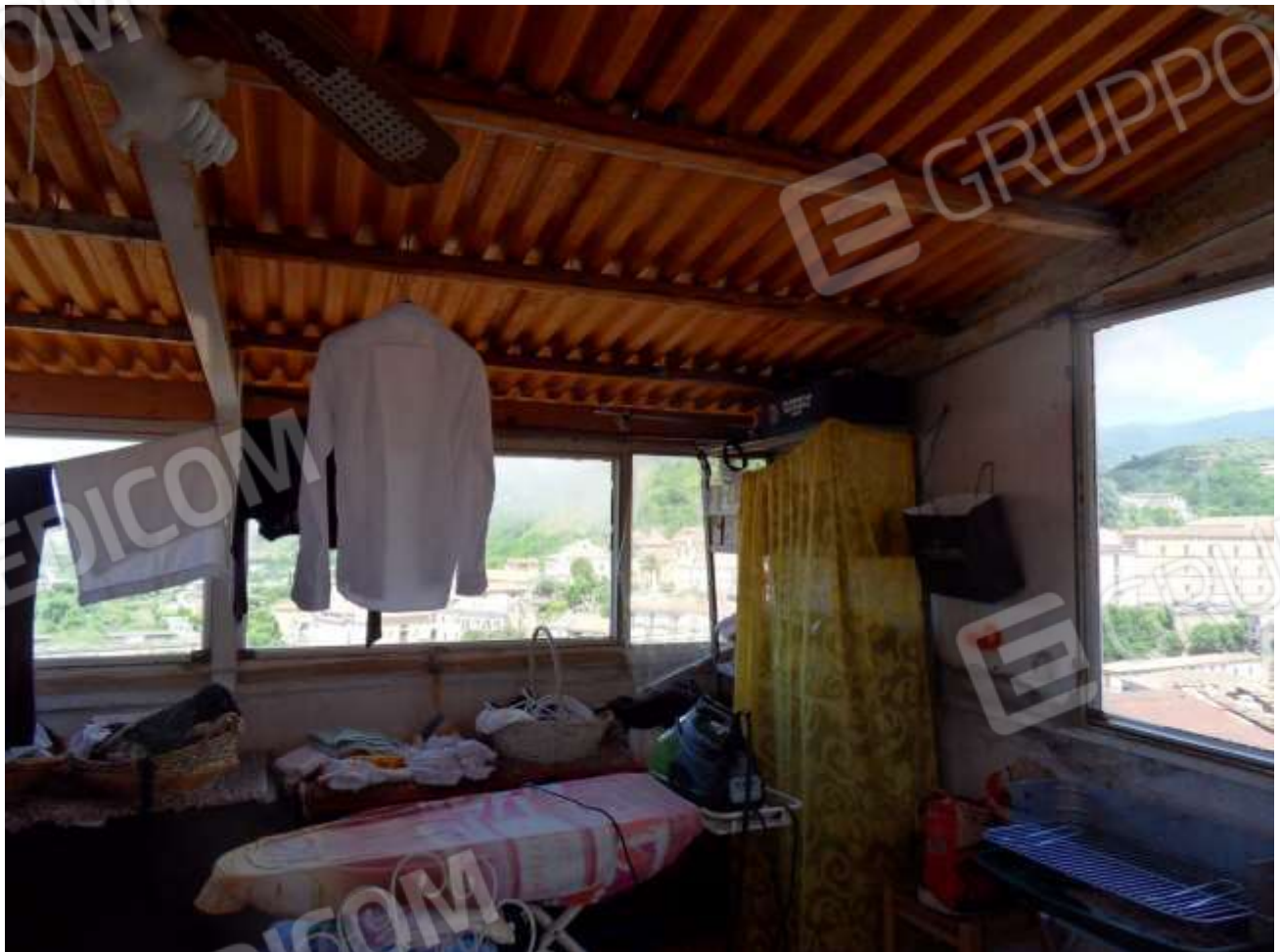
FOTO N. 36: Interni Immobile – Terrazzo
