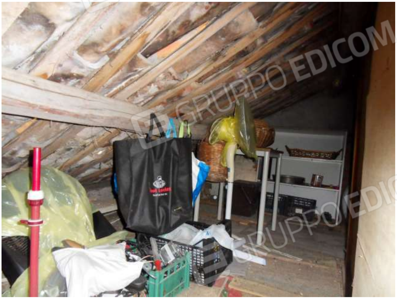
FOTO N. 37: Interni Immobile – Sottotetto
