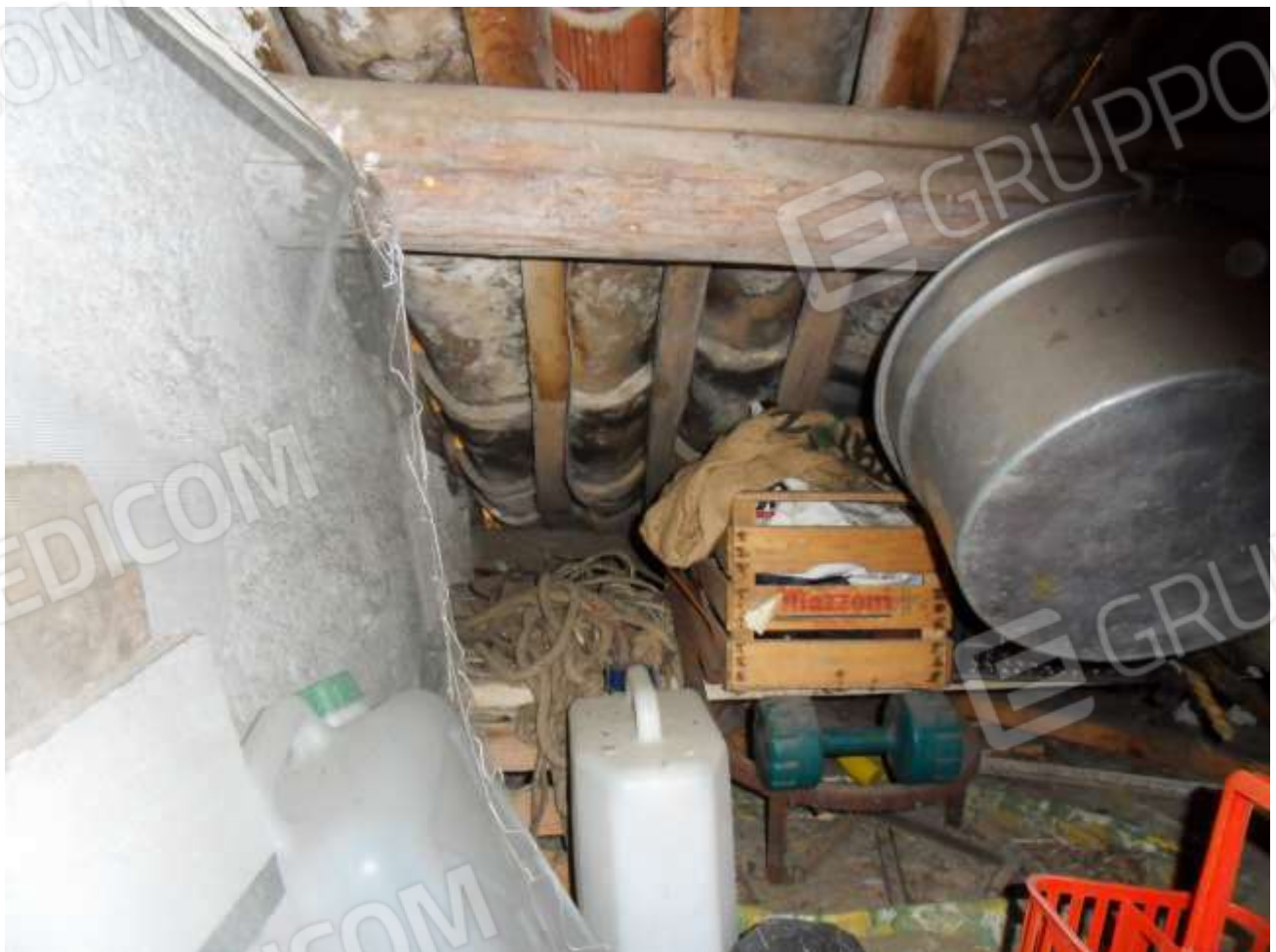
FOTO N. 38: Interni Immobile – Sottotetto
