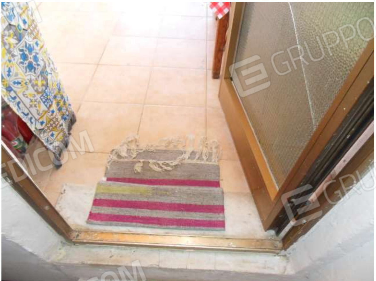
FOTO N. 46: Interni Immobile – Terrazzo
