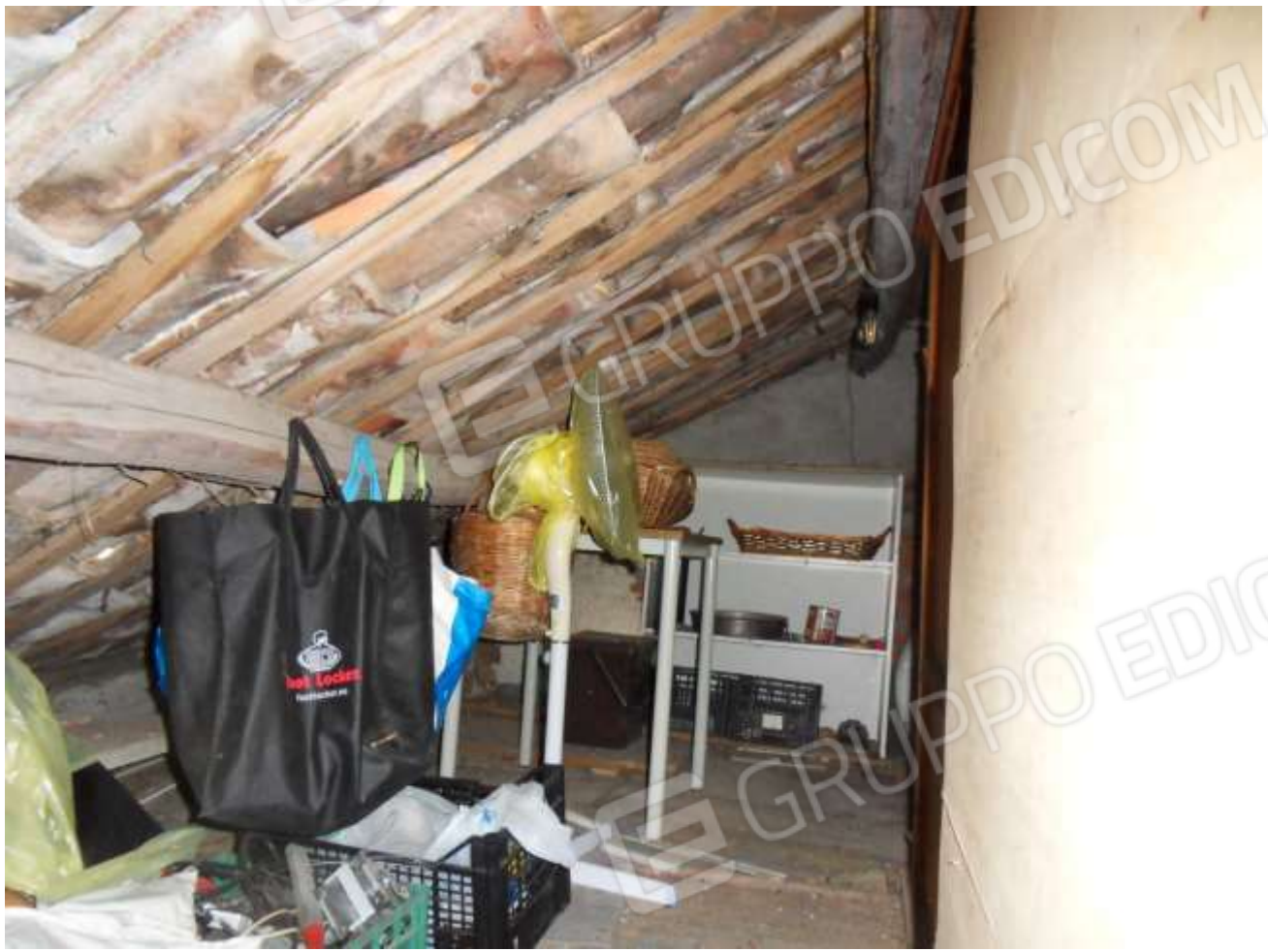
FOTO N. 39: Interni Immobile – Sottotetto
