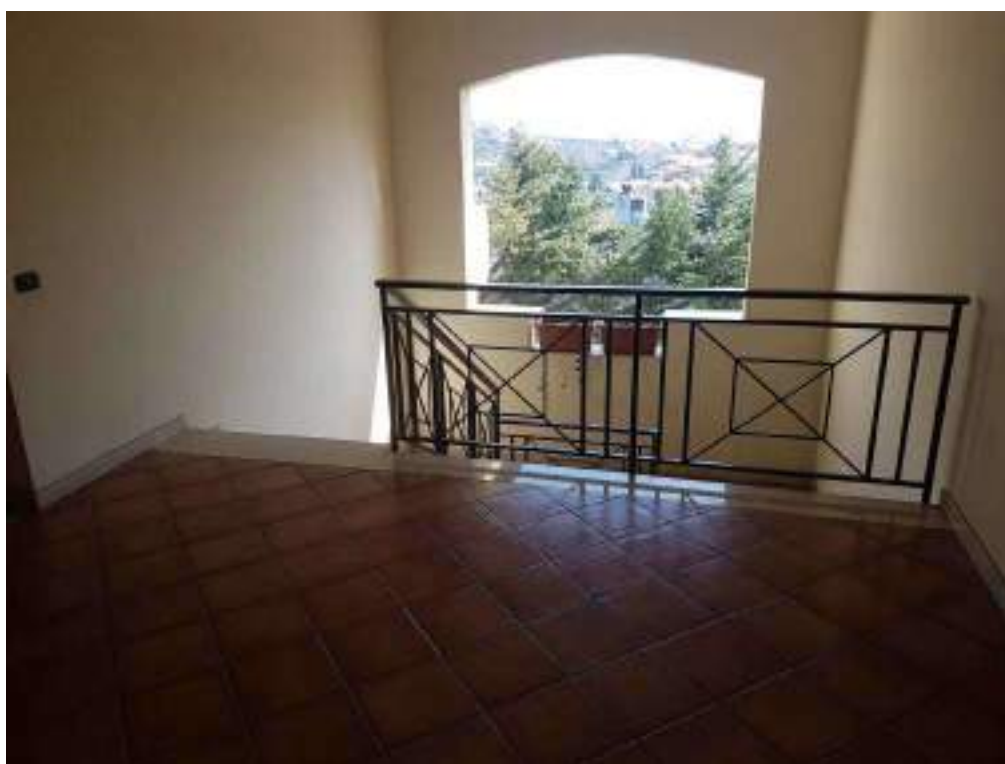
Foto 6: vano scala palazzina e pianerottolo piano secondo
