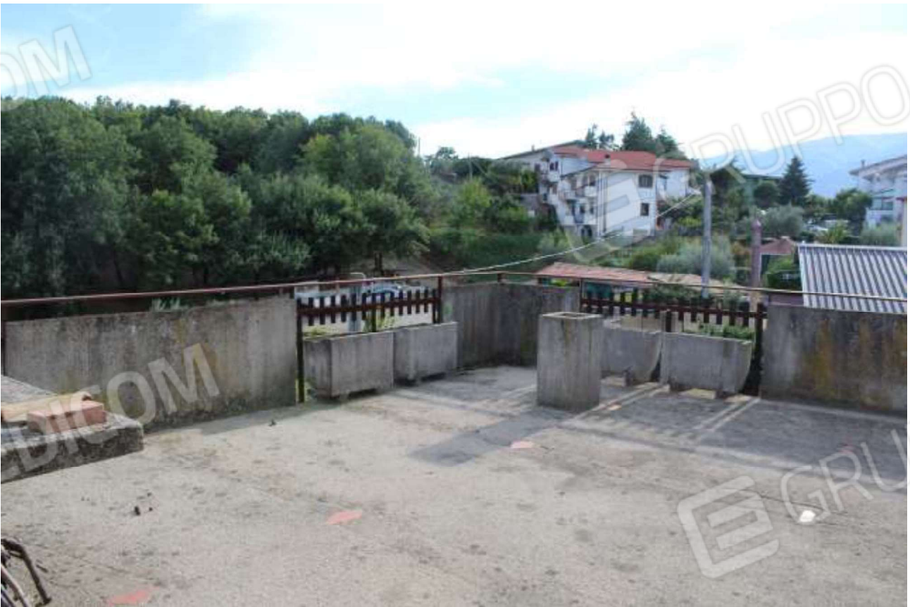
vista terrazzo piano sottotetto
