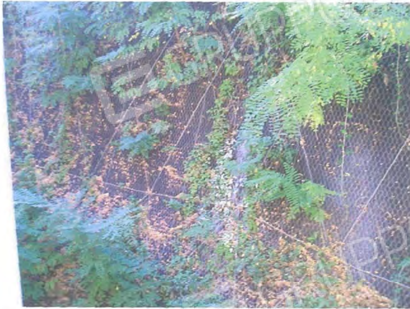
Foto n. 11: particolare dell'intervento di consolidamento del pendio a monte del fabbricato.
