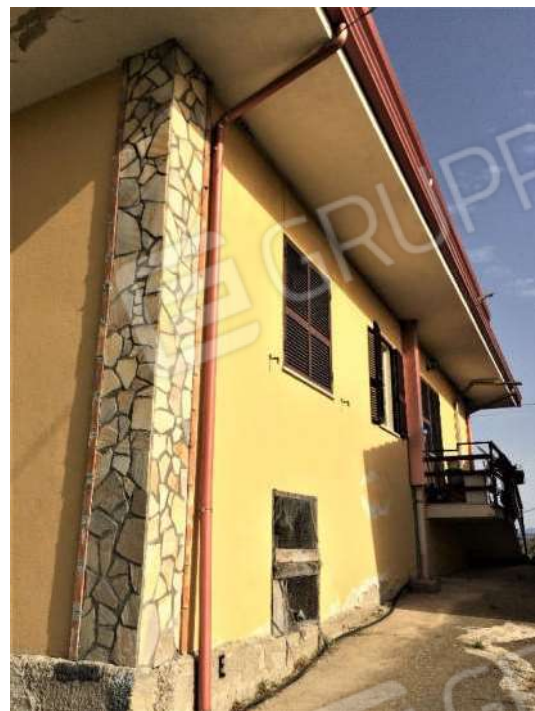
Foto 5 – Particolare prospetto est
