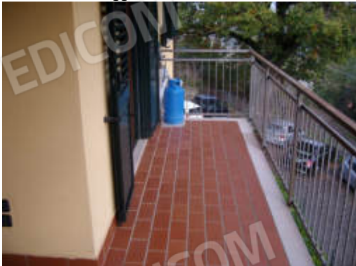
Foto n°21: Balcone Soggiorno-Cucina, Vista Zona Cucina;
