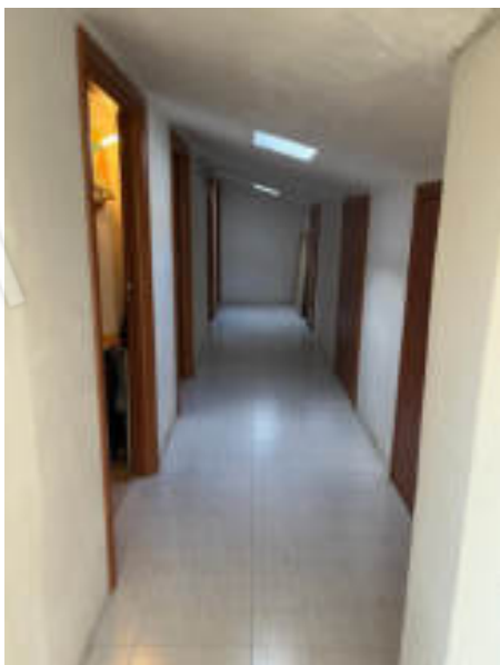
Foto n°23: Piano Sottotetto; Corridoio Soffitte
