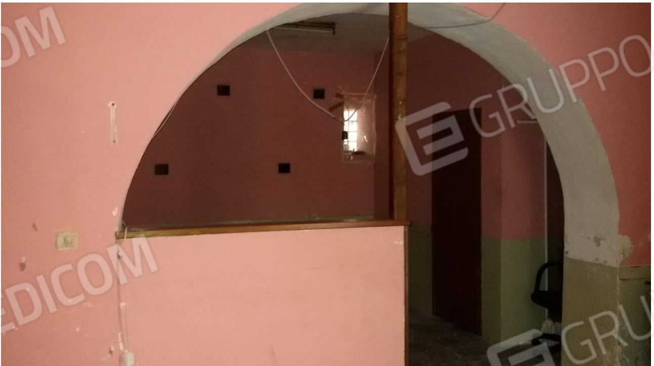
Immobile B sub2 foto 10
