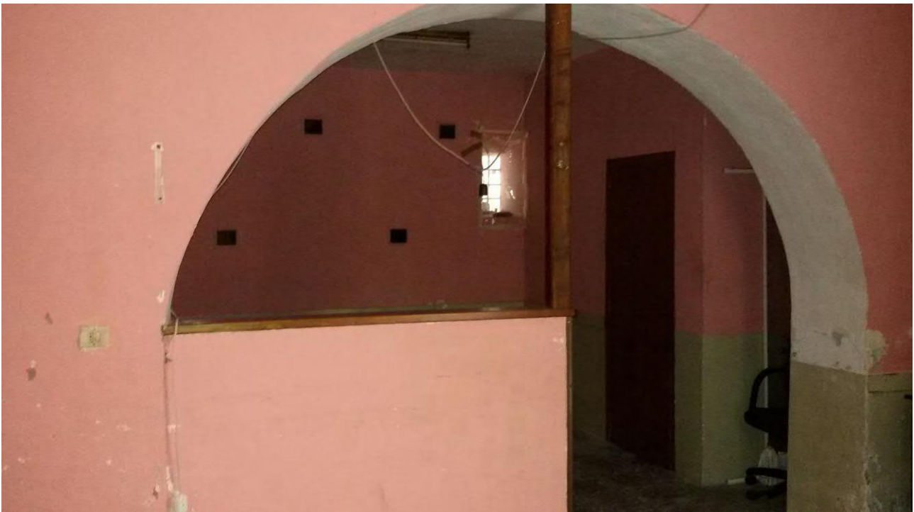
Immobile B sub2 foto 10
