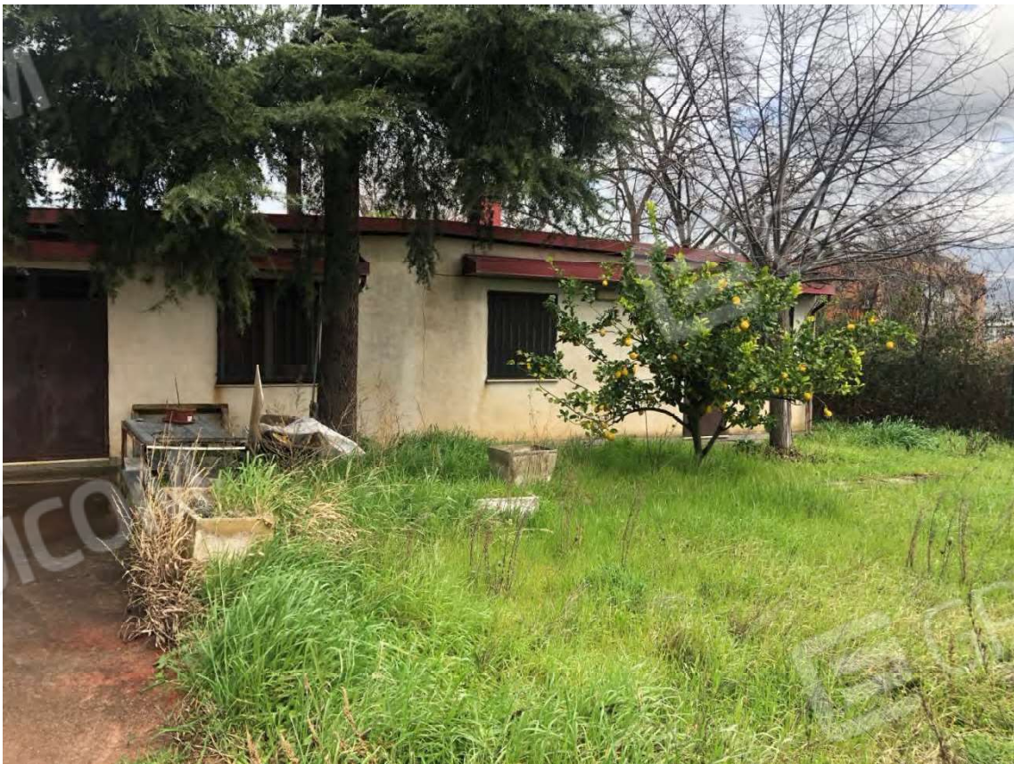
Foto 22 - Magazzino Rende, fg.50, p.lla 809, sub.2-3
