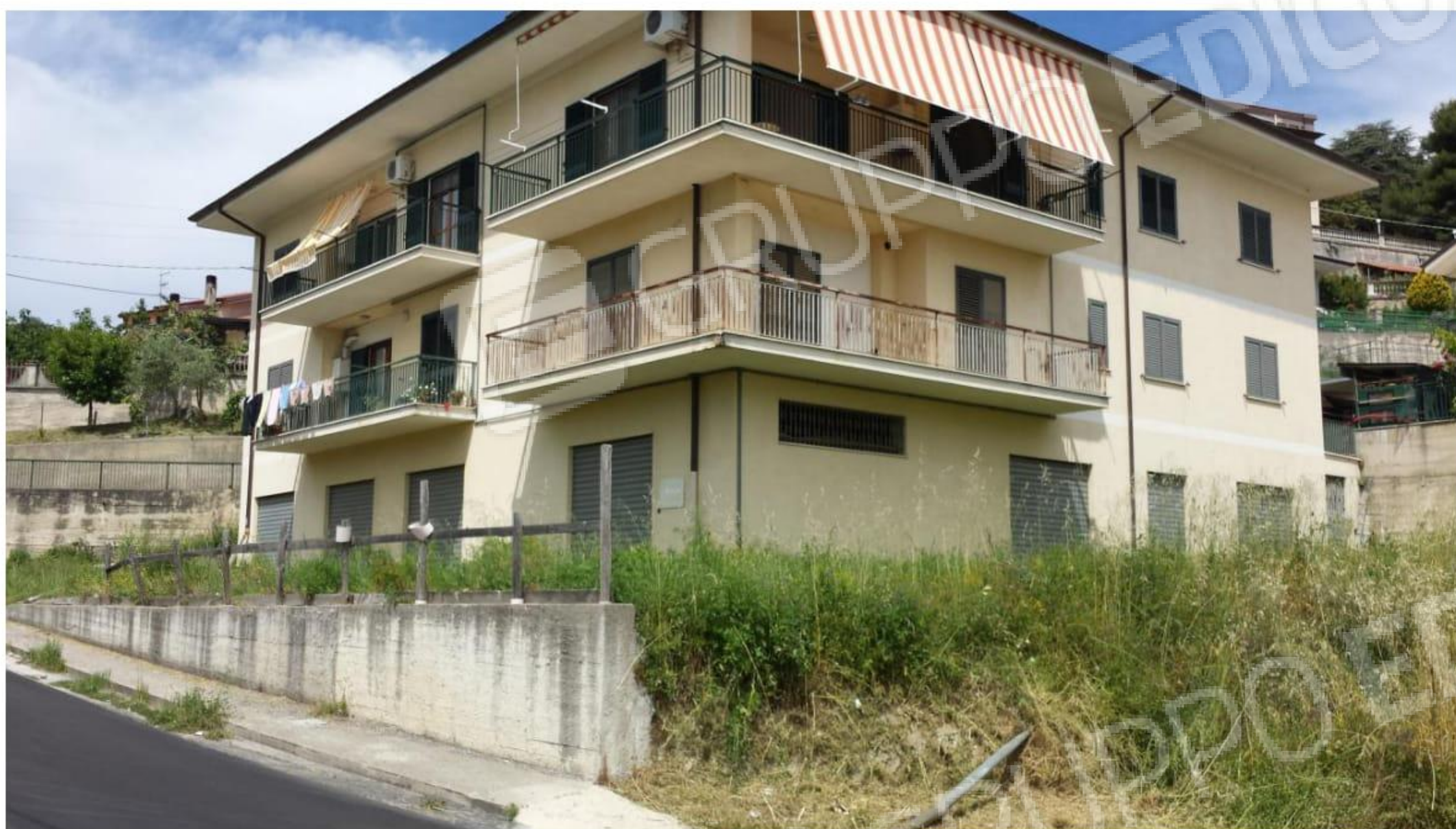
FOTO n.7 – Foglio 12 Part. 224 Sub. 6,7,8
