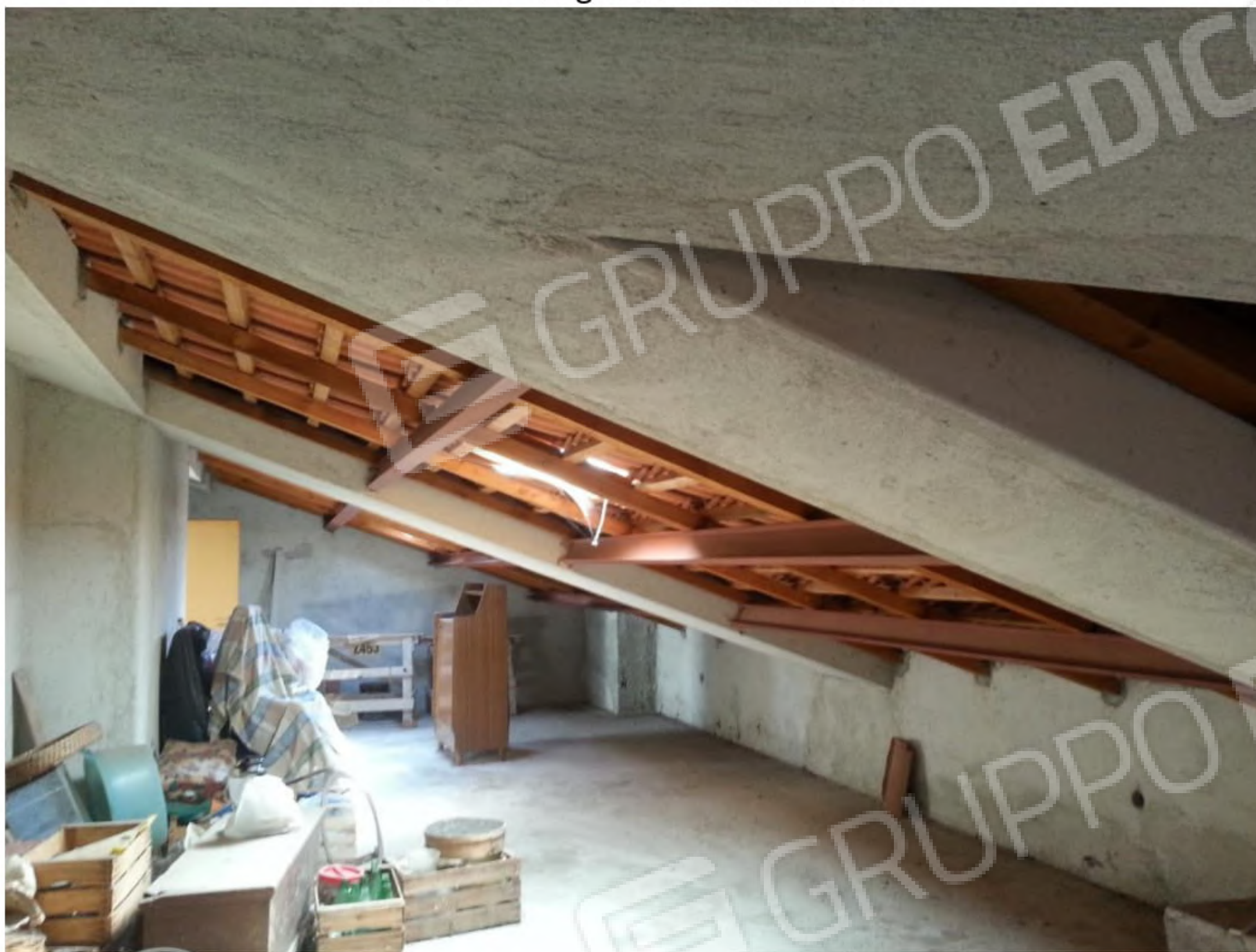
FOTO n.15– Foglio 12 Part. 224 Sub. 5
