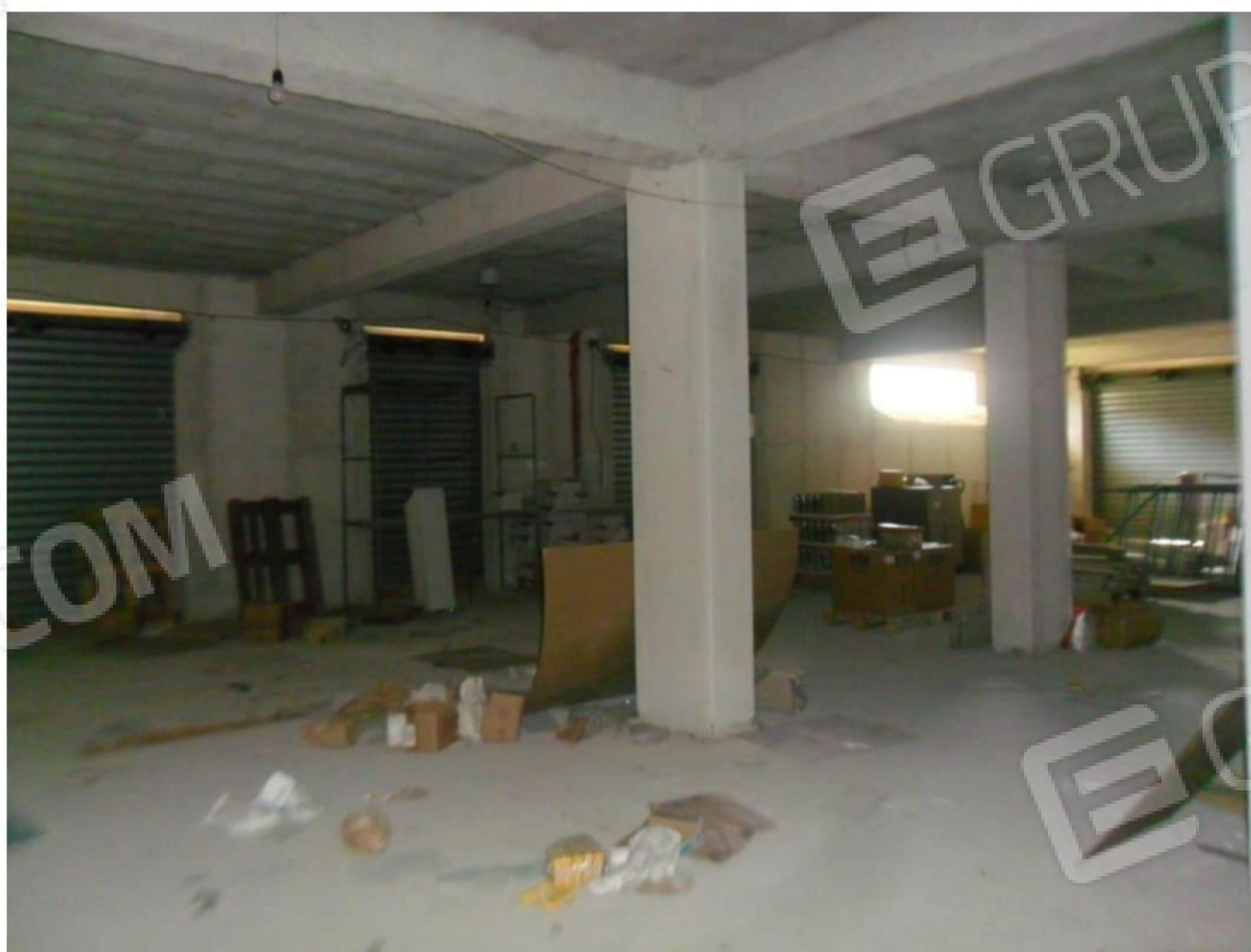
FOTO n.8 – Foglio 12 Part. 224 Sub. 6 -7
