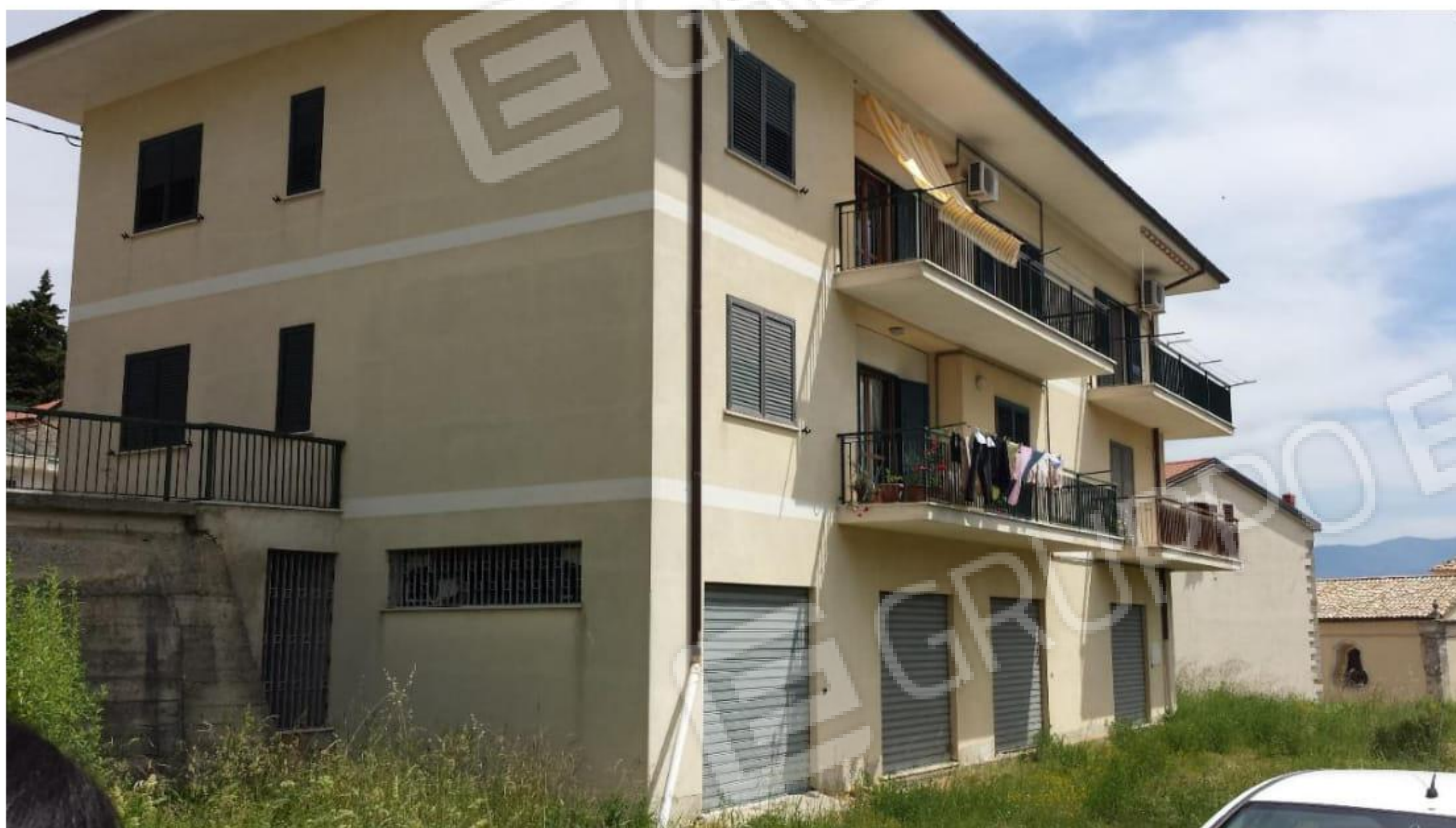
FOTO n.5 – Foglio 12 Part. 224 Sub. 6,7,8
