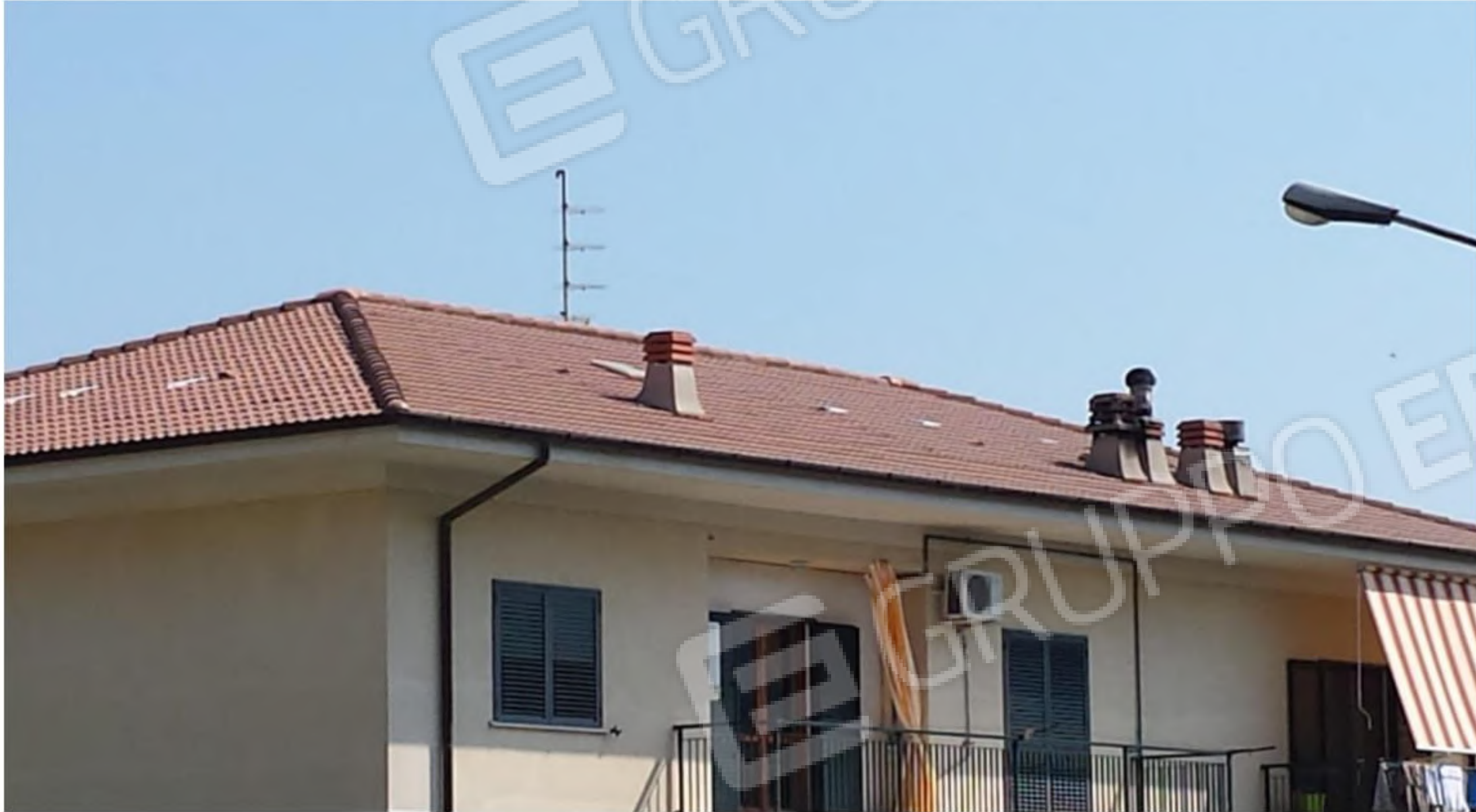
FOTO n.13 – Foglio 12 Part. 224 Sub. 5
