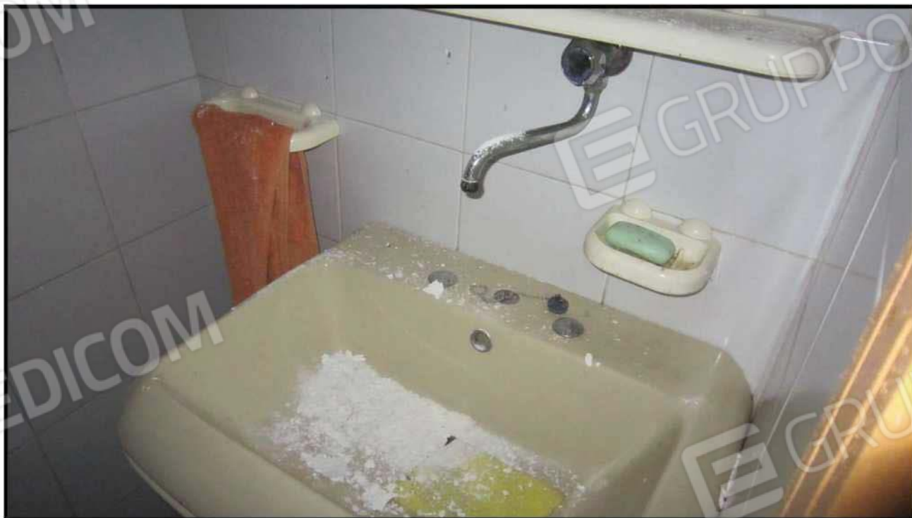
Foto 18 Interno Piano Seminterrato (Sub. 19) – Wc
