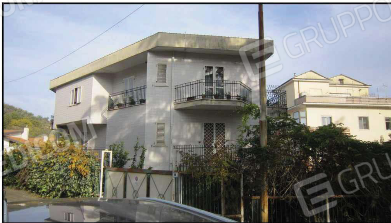
Foto 2 Fabbricato part. 135 in vista da Via G. Amantea (Sud)
