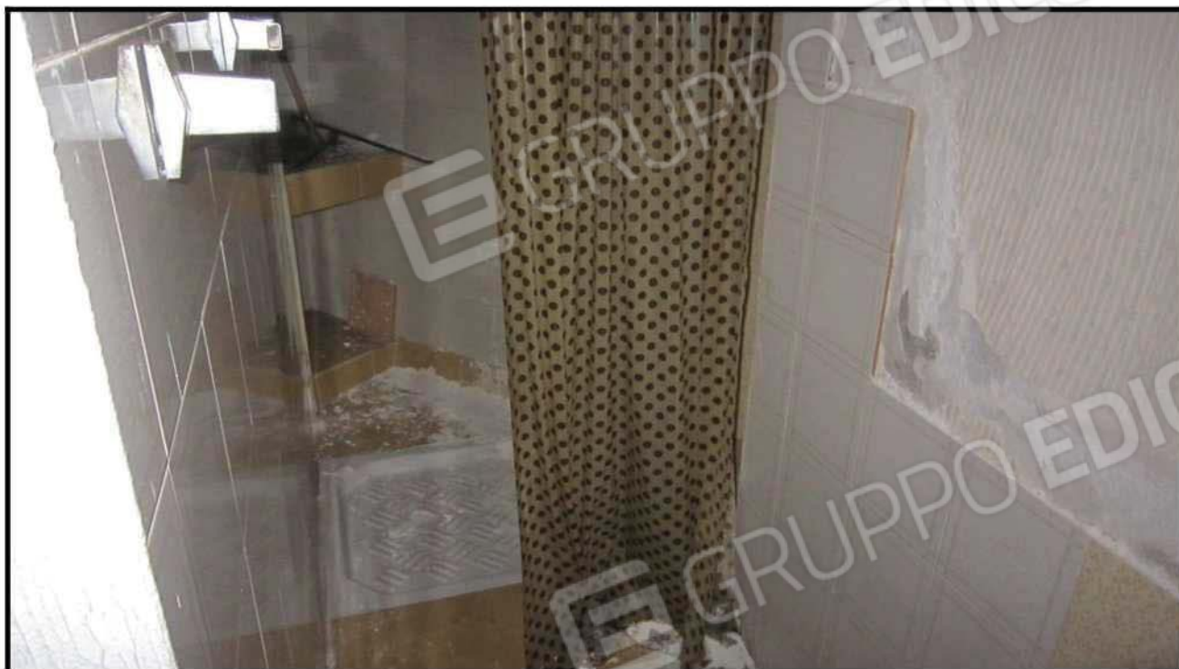
Foto 17 Interno Piano Seminterrato (Sub. 19) – Doccia
