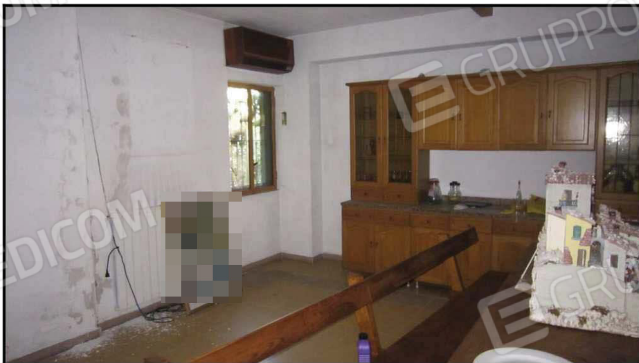
Foto 16 Interno Piano Seminterrato (Sub. 19)
