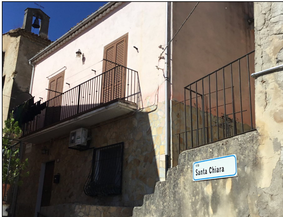
Particolare vista segnaletica toponomastica (via Santa Chiara)
