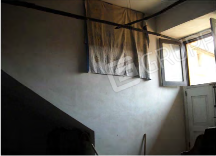
Piano terra deposito
