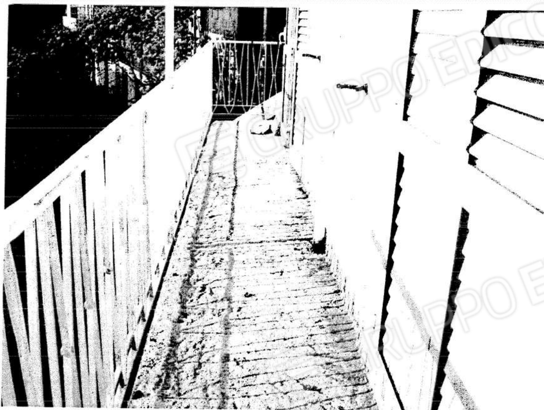
Foto n°. 14 - Balcone
