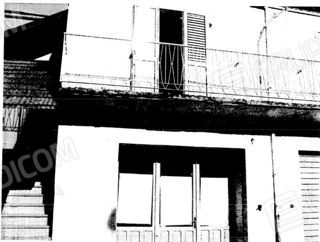
Foto n°. 15 - Balcone
