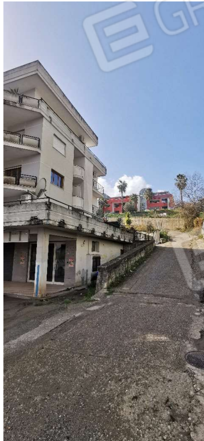
Foto 2: Rampa di accesso.
