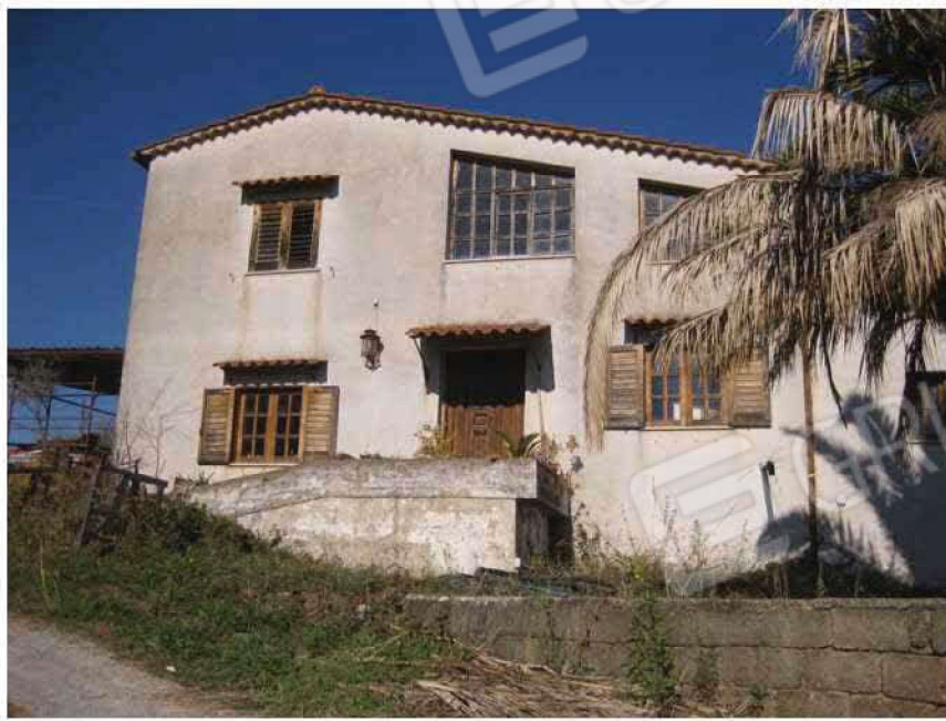
Prospetto ingresso principale - Strada interna al cortile Foglio 11 Part. 162 sub. 1
