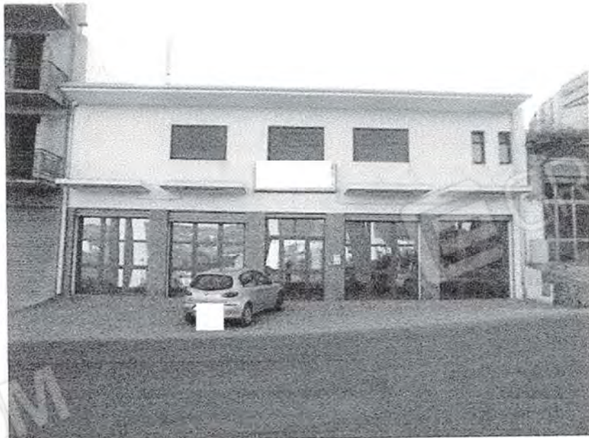
Vista esterna Lotti N. 6-7
