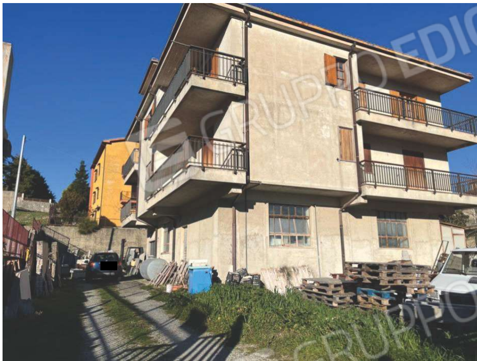
Foto 1 – Vista esterna intero fabbricato
